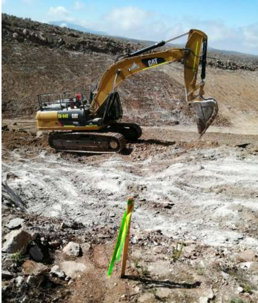
Foto 1: Corte de material orgánico en la ampliación del PAD II de lixiviación Cuajone
