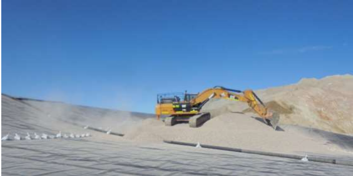
Foto 7: Sobrerevestimiento en la ampliación del PAD II de lixiviación Cuajone
