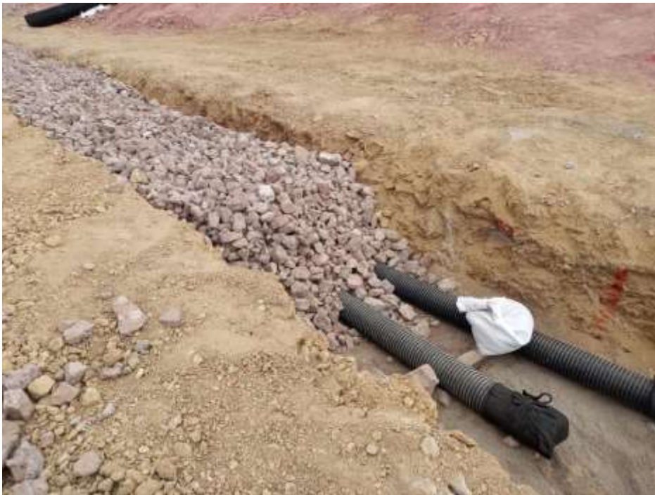
Foto 3: Sistema de subdrenaje en la ampliación del PAD II de lixiviación Cuajone
