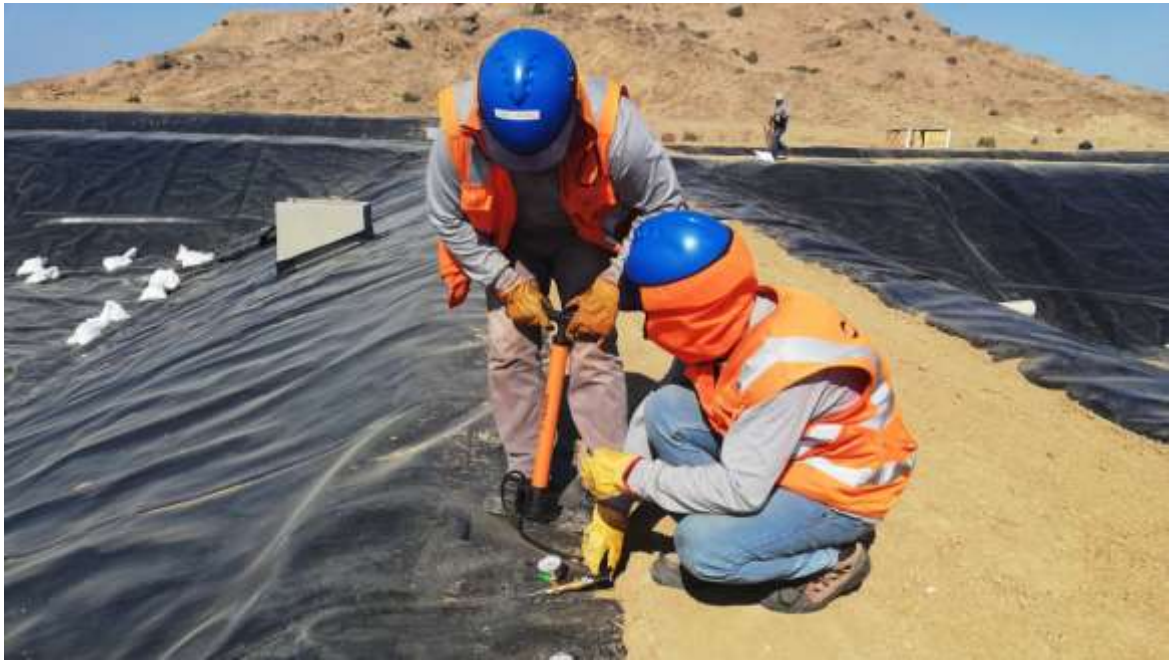
Foto 6: Colocación de geomembrana en la ampliación del PAD II de lixiviación Cuajone
