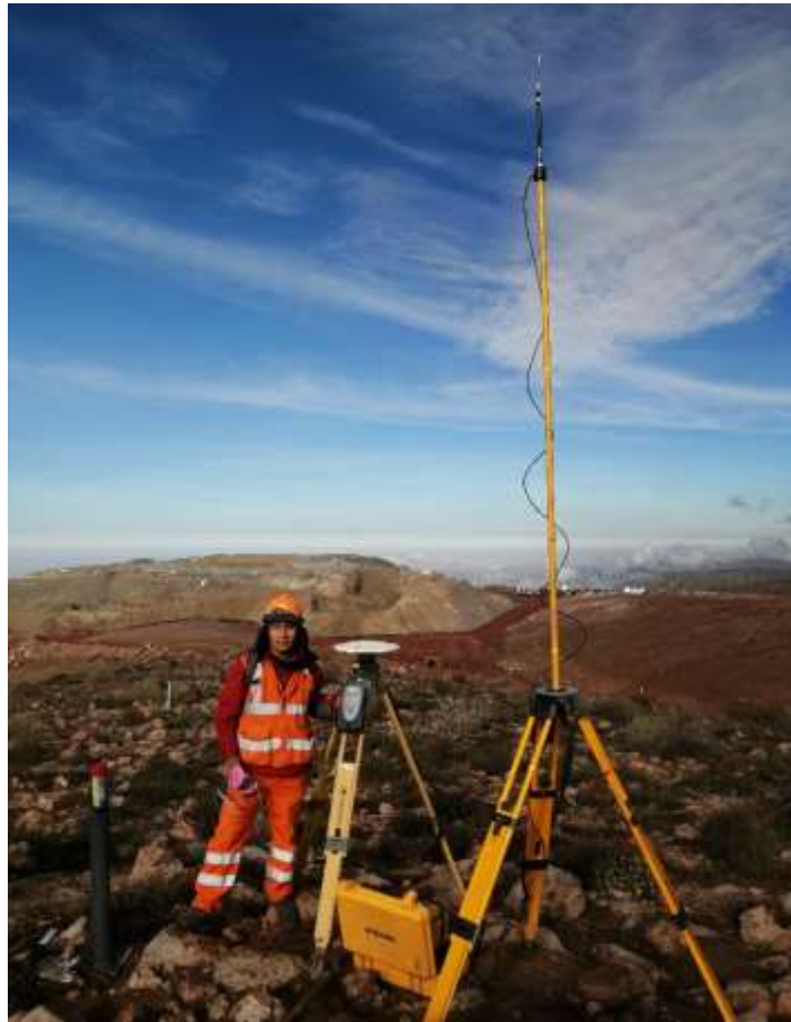
En el área de control de equipos topográficos, ampliación del PAD II de lixiviación
