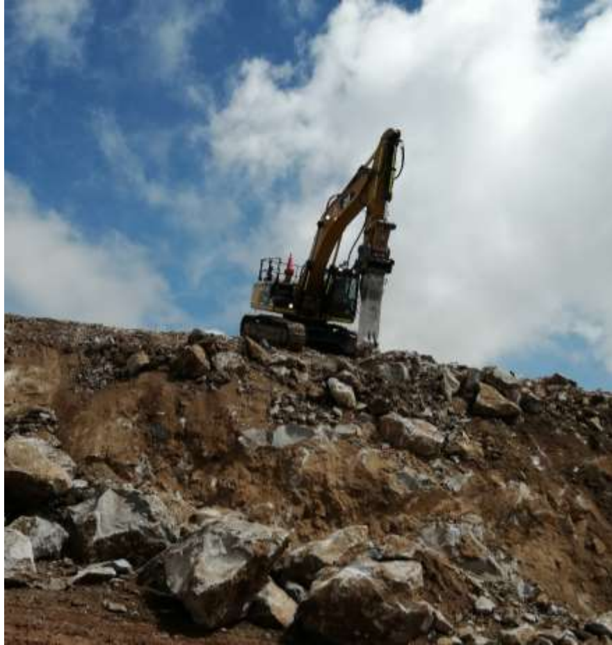
Foto 2: Corte de material inadecuado en la ampliación del PAD II de lixiviación Cuajone
