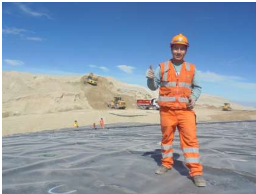
En el área de instalación de geomenbrana en la ampliación del PAD II de lixiviación
