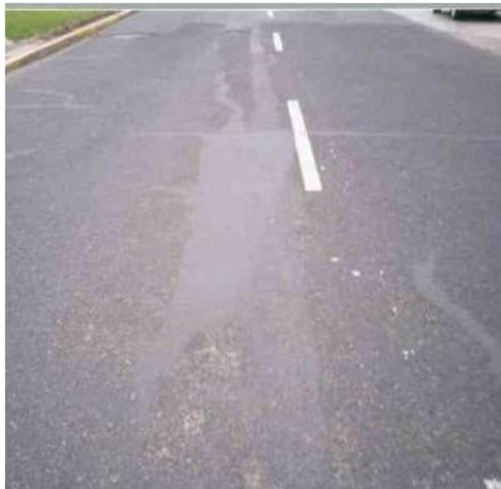
Figura 20 Falla tipo:Exudacion
