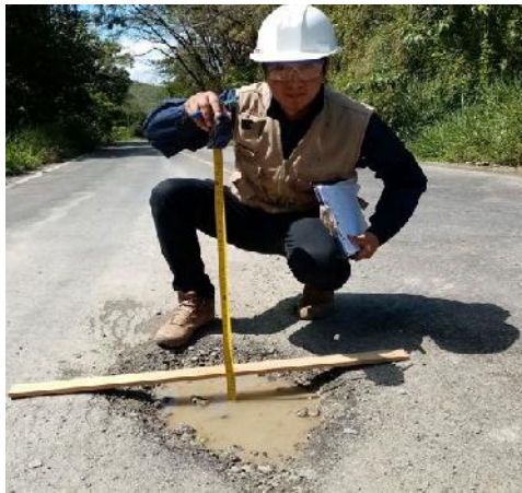
Figura 18 Falla tipo:Baches
