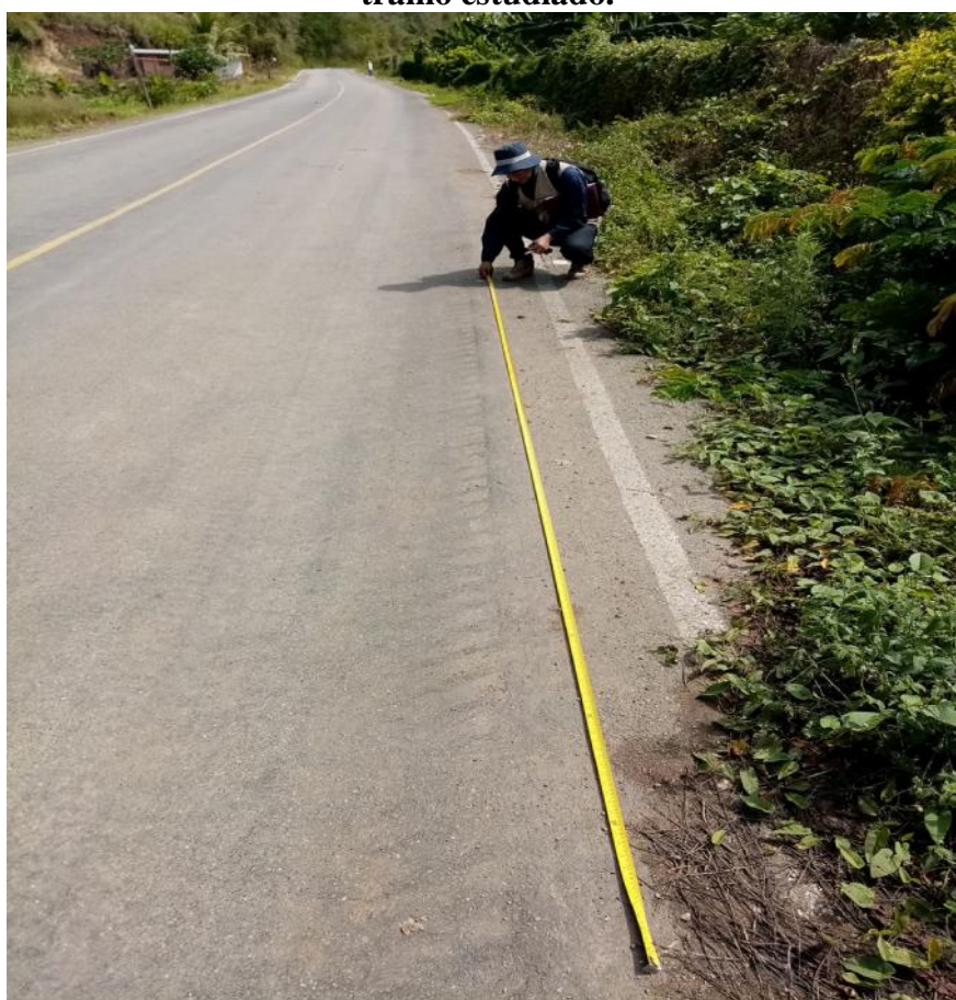
Fotografía 04. Falla tipo Ahuellamiento. Se presenta con gran incidencia a lo largo del tramo estudiado.
