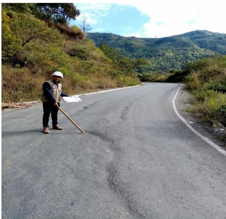
Fotografía 04. Falla tipo Ahuellamiento. Se presenta con gran incidencia a lo largo del tramo estudiado.
