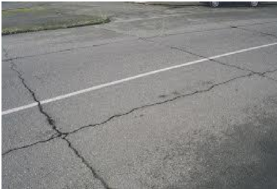
Figura 9 Reflexion de junta
