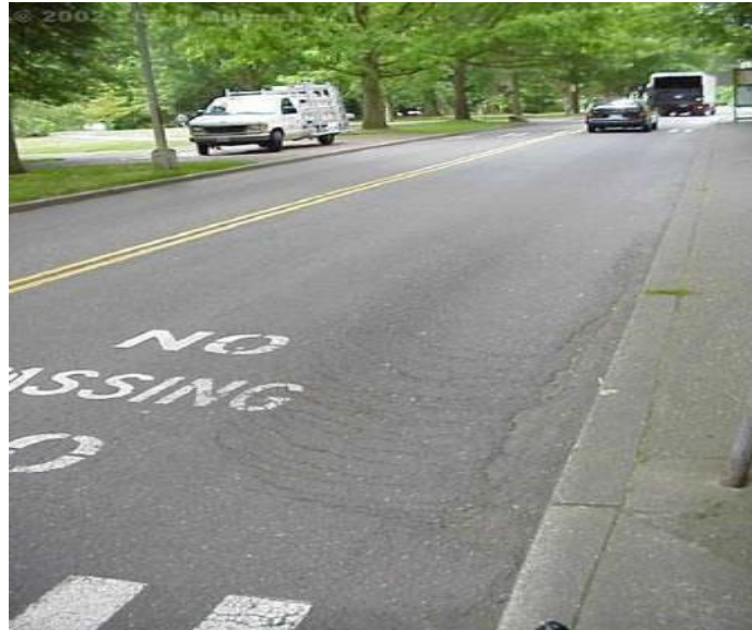
Figura 16 Falla tipo:Desplazamiento
