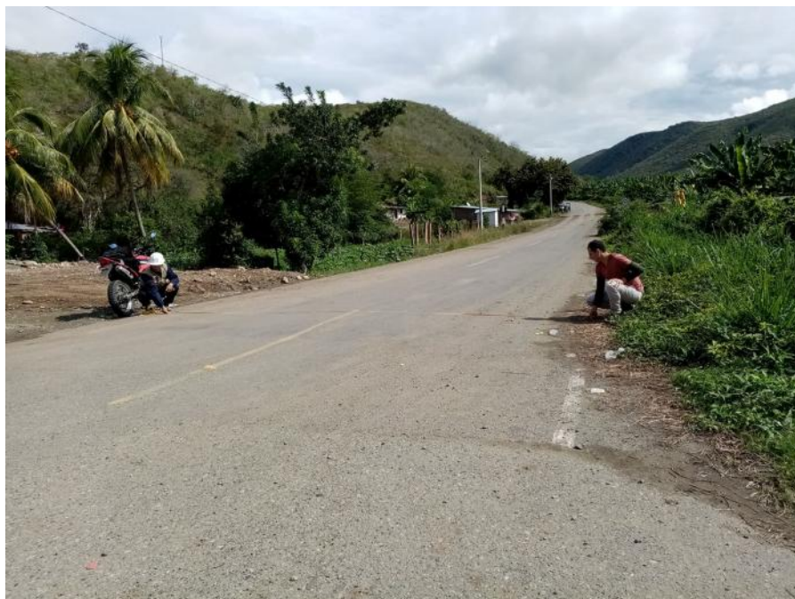
Fotografía 01. Toma de medidas de calzada, berma y cunetas del tramo en estudio.
