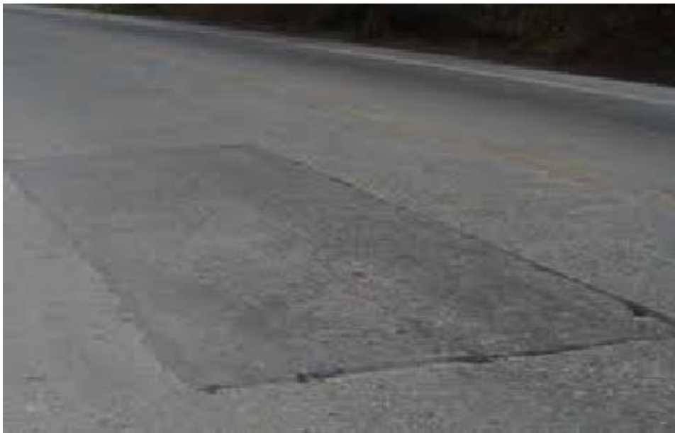
Figura 23 Falla tipo:Parches
