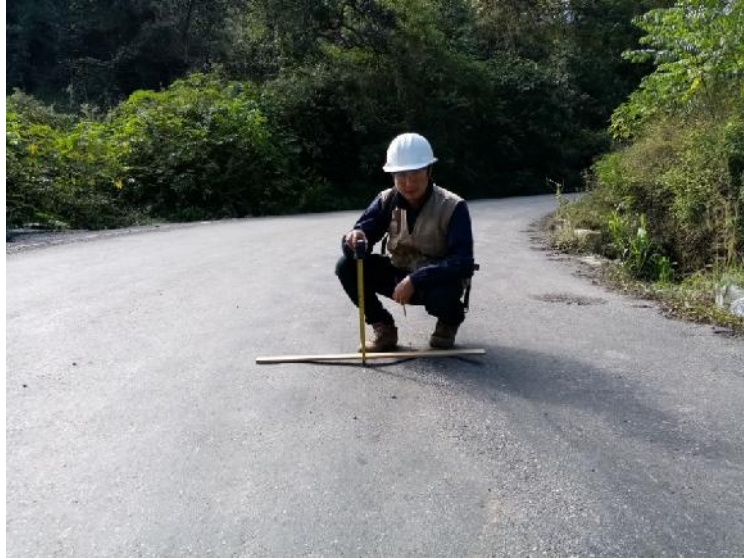
Figura 14 Falla tipo:Depresiones
