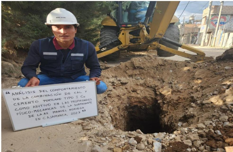
**Figura 9:** Excavación de calicata para extracción de la muestra de suelo.
