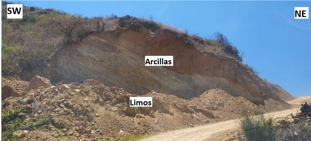
Foto 13: Estación 7, N: 9201111 E: 793056 C: 2916 m.s.n.m., Talud de depósitos cuaternarios conformados por limos y arcillas.
