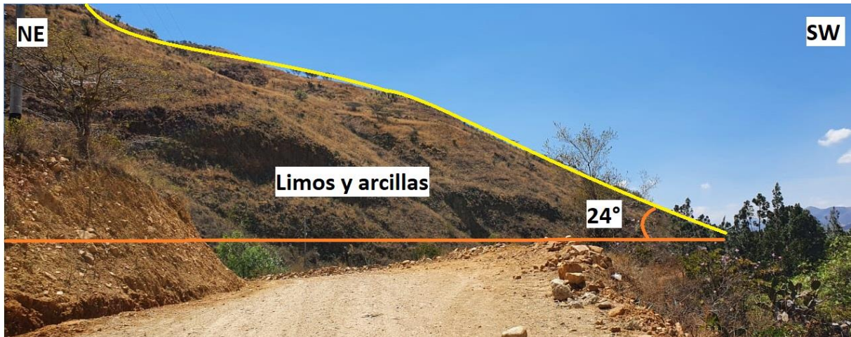
Foto 14: Estación 8, N: 9194642 E: 788638 C: 3160 m.s.n.m., Talud de depósitos cuaternarios conformados por limos y arcillas.
