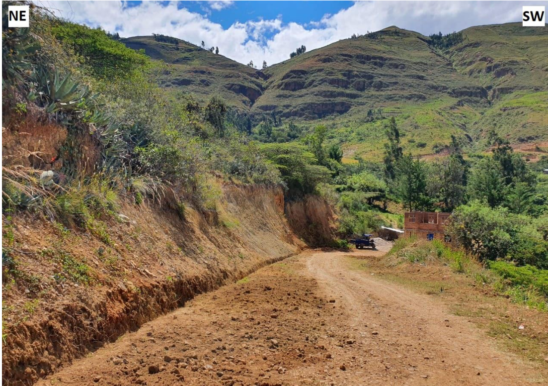
Foto 8: Estación 2, N: 9198444 E: 790500 C: 2538 m.s.n.m., Talud de depósito aluvial.
