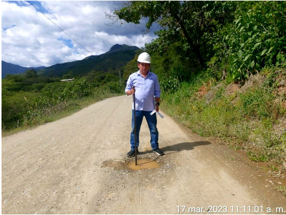
Figura 35 .- Baches de gravedad 1, ubicada en la sección KM (4+000-4+500)
