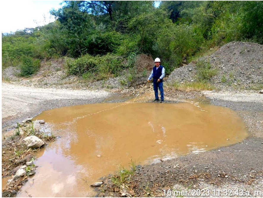
Figura 27 .- Cruce de agua, ubicada en la sección KM (2+500-3+000)
