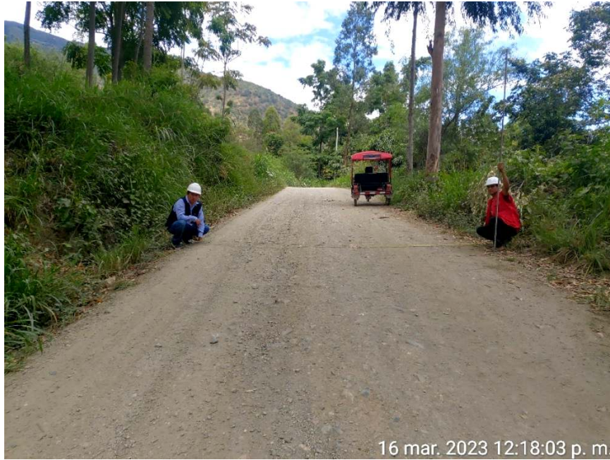
Figura 29 .- Medida del ancho de la sección de la Vía, ubicada en la sección KM (2+500-3+000)
