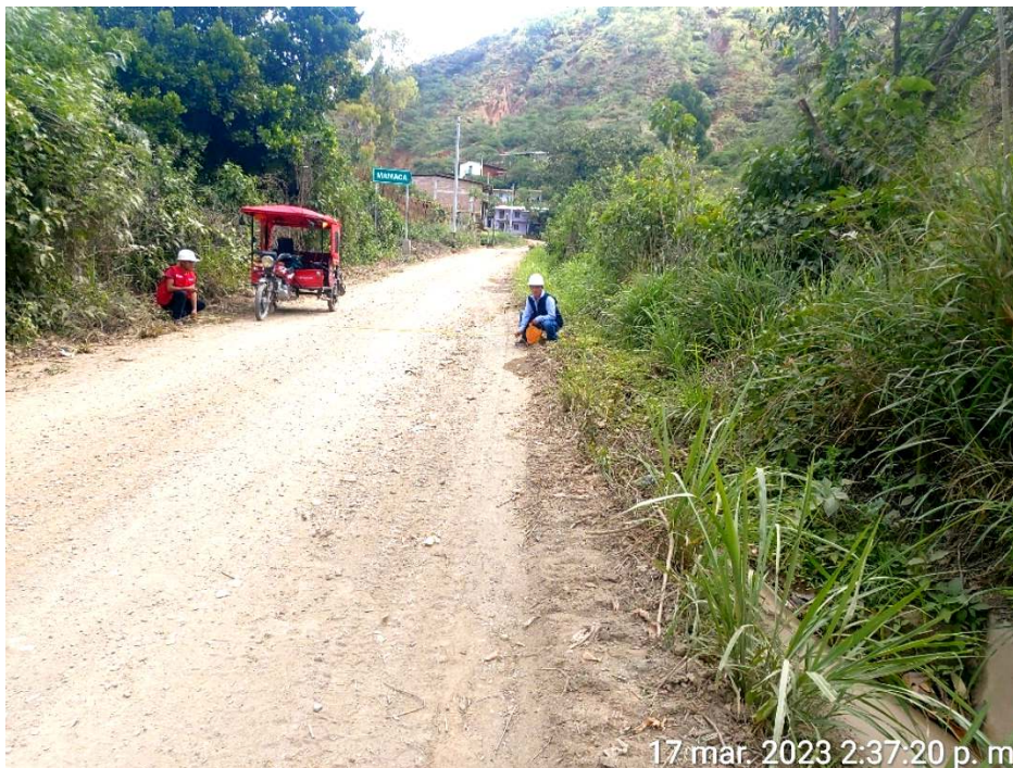
Figura 38 .- Medición del ancho de vía, ubicada en la sección KM (5+500-6+000)
