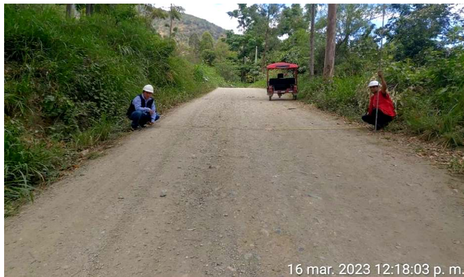
Figura 17 .- medida del ancho de la sección de la vía
