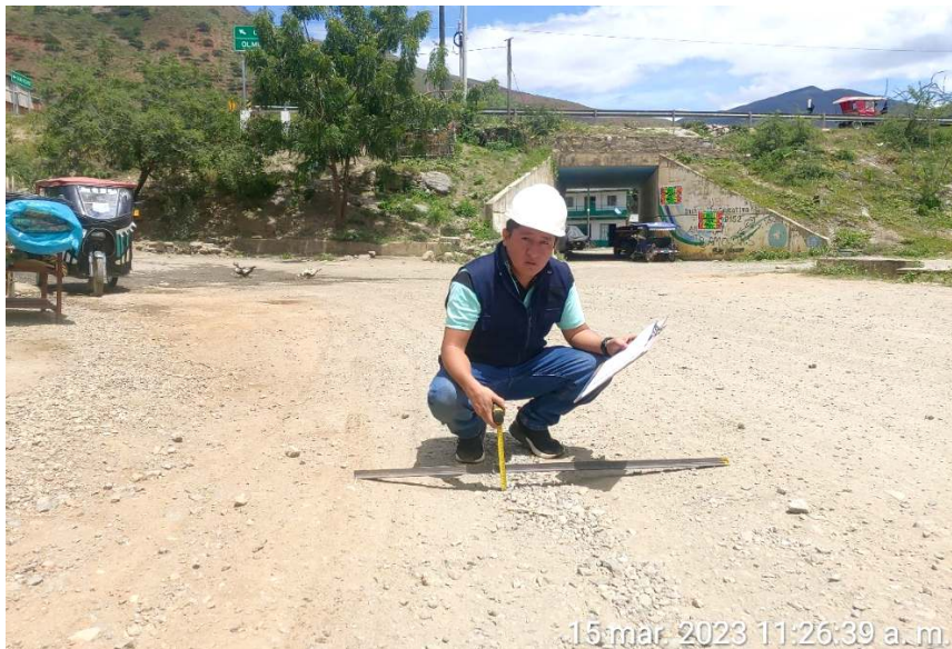
Figura 22 .- Erosión de gravedad 2, ubicada en la sección KM (0+000-0+500)
