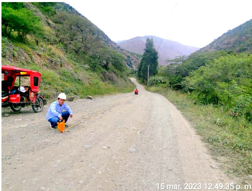
Figura 24 .- Medición de Erosión de gravedad 2, ubicada en la sección KM (1+000-1+500)
