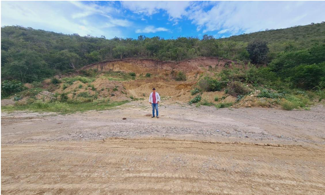
La cantera Olano es una cantera de ladera, tiene un área de explotación aproximada de 12 ha., con un método de explotación tal como se aprecia en la Figura 16.
