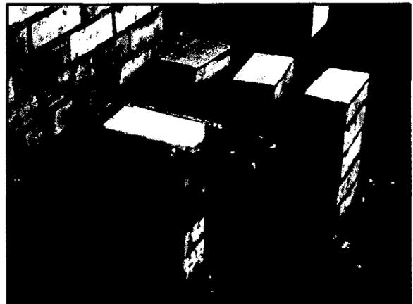
*Ilustración 49. Nivelado con Yeso*
