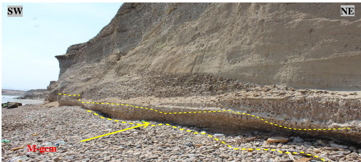
Foto 84: Formación de cuevas marinas en la base de los acantilados por la erosión marina en zonas débiles poco consolidadas. (Coordenadas UTM 657817 E, 9182510 N).
