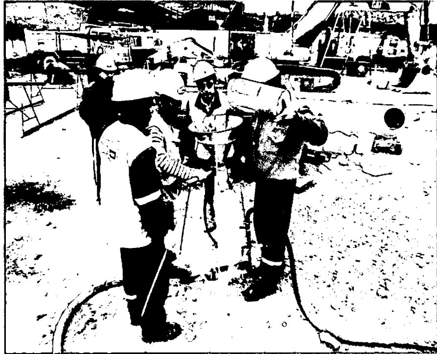
Imagen A.VII.2: Colocación del material al Equipo de Bombeo.
