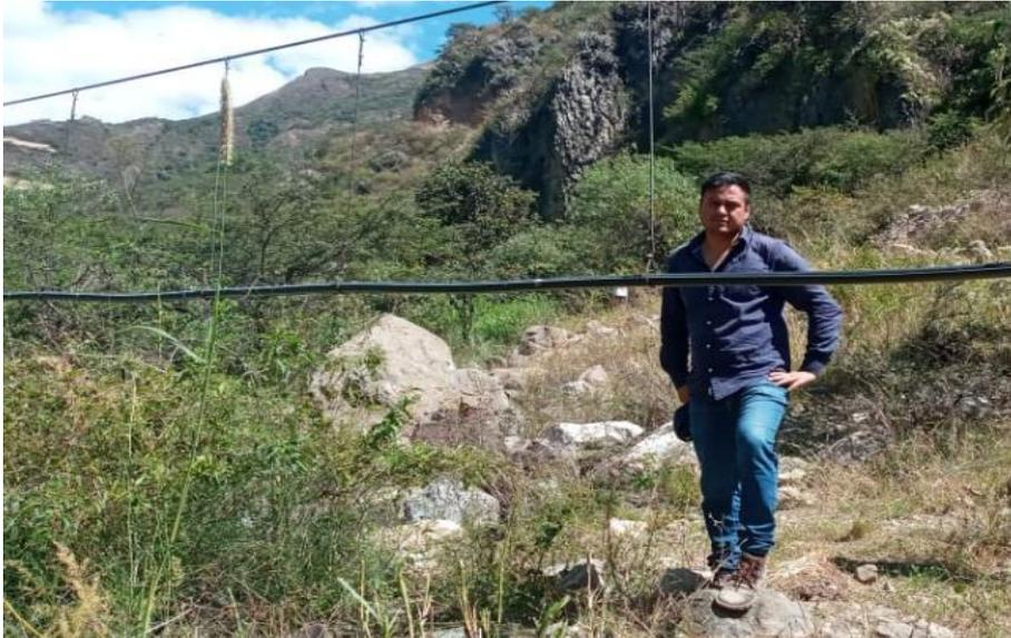
**Foto 5.** Pase aéreo en la línea de conducción diámetro 1 ½” progresiva 1+202.88
