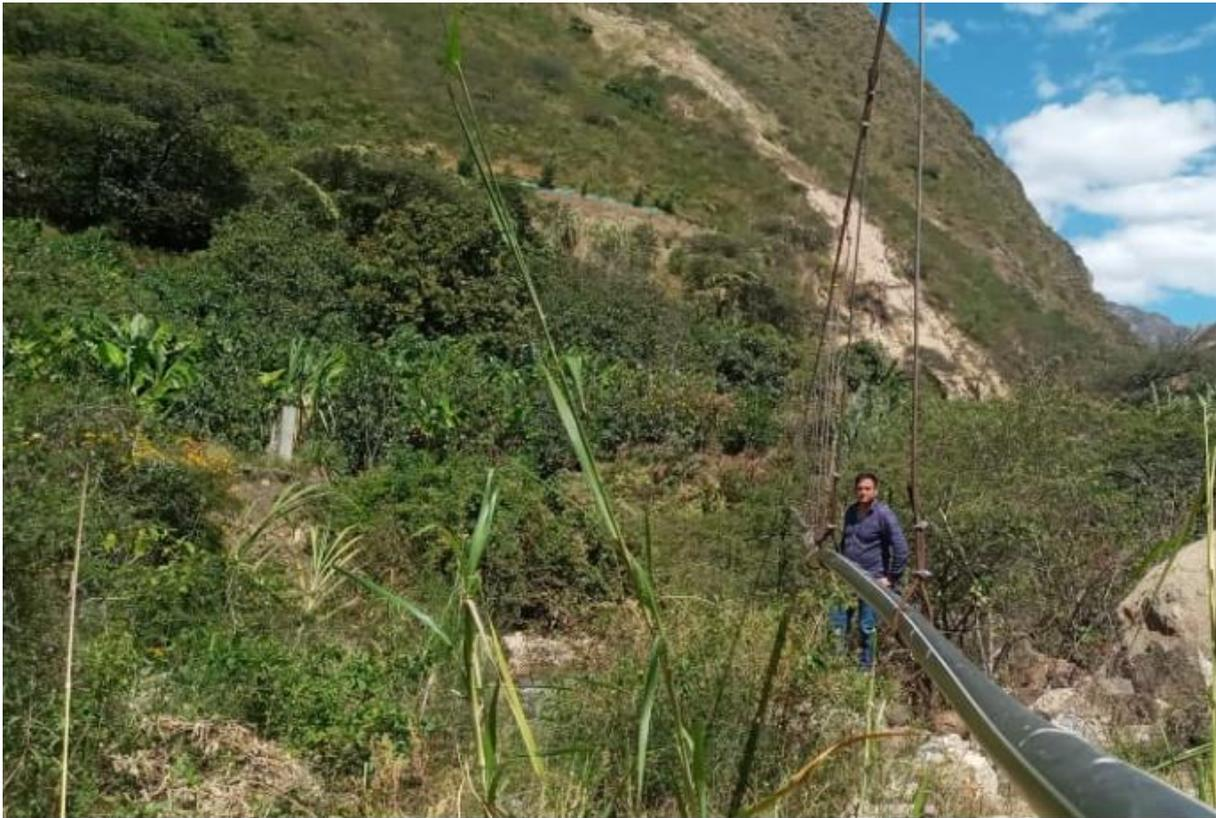
**Foto 21:** Pase aéreo en la línea de conducción de 60 metros de longitud
