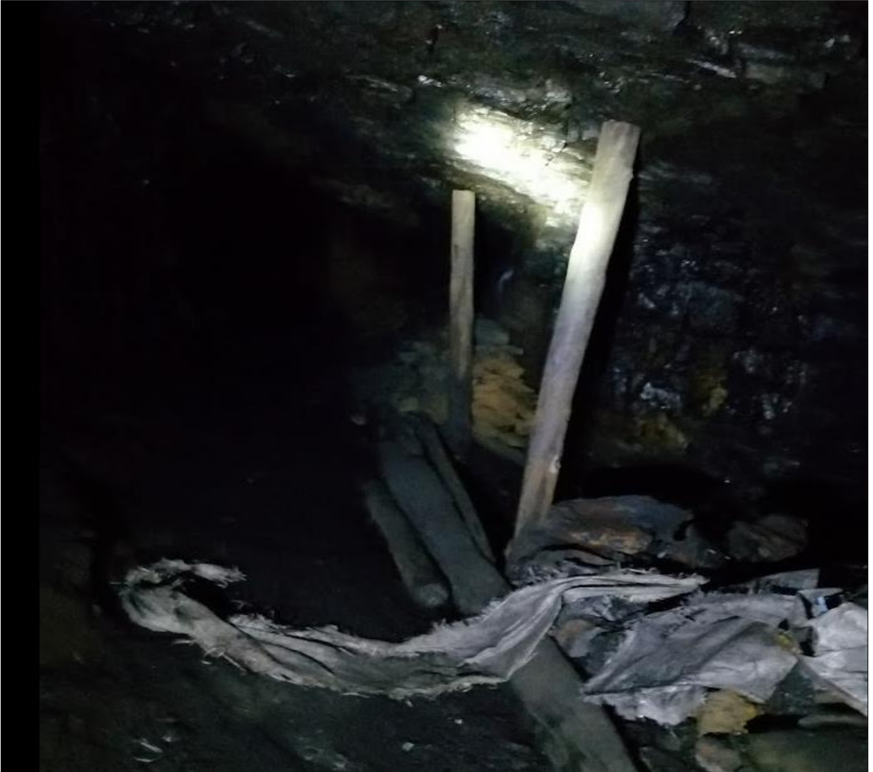
Figura 12. Falta de orden y limpieza en labor 08 - Nv.2
