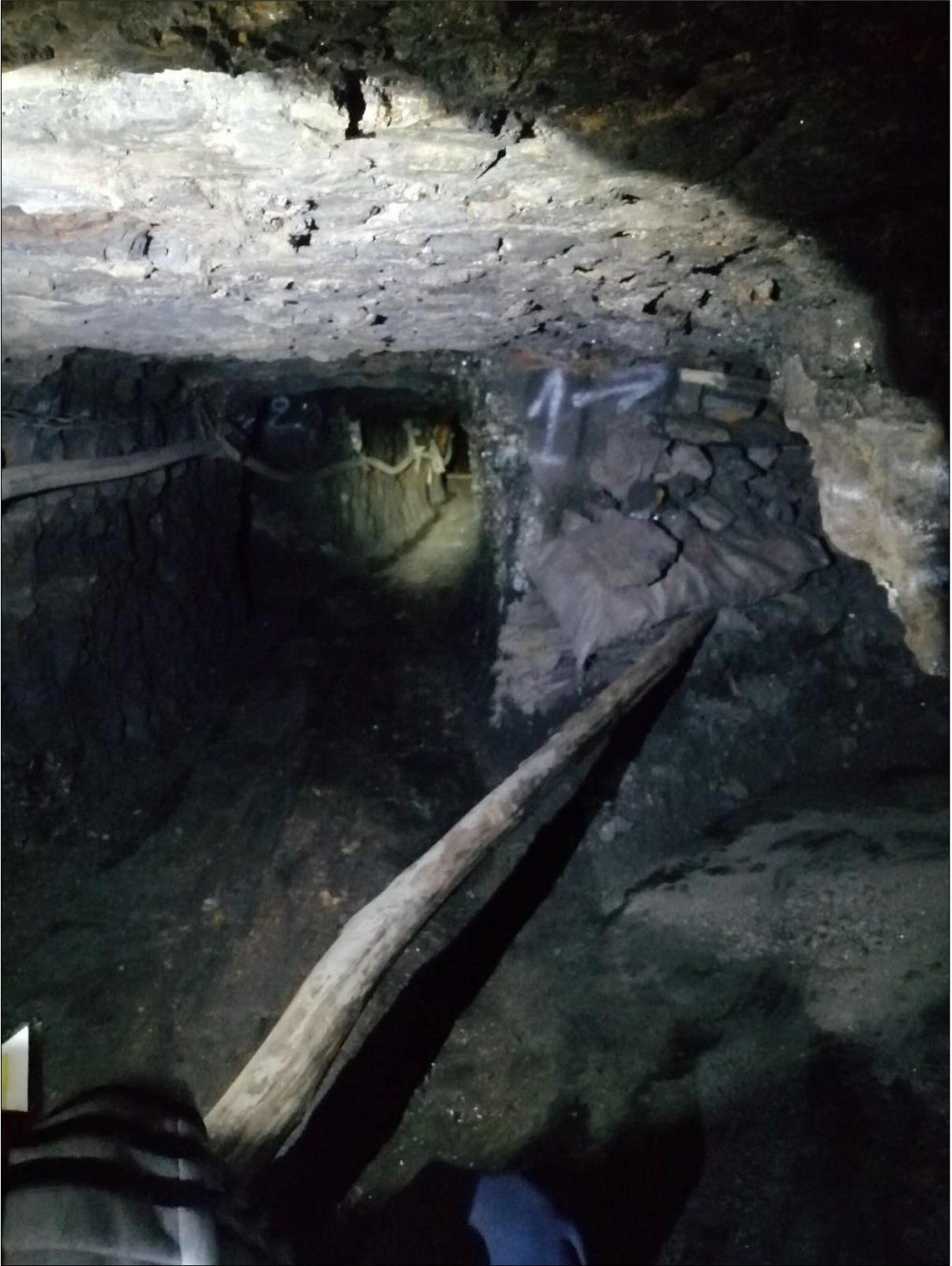
Figura 15. Verificación de labores PI + 73 – Nv.2
