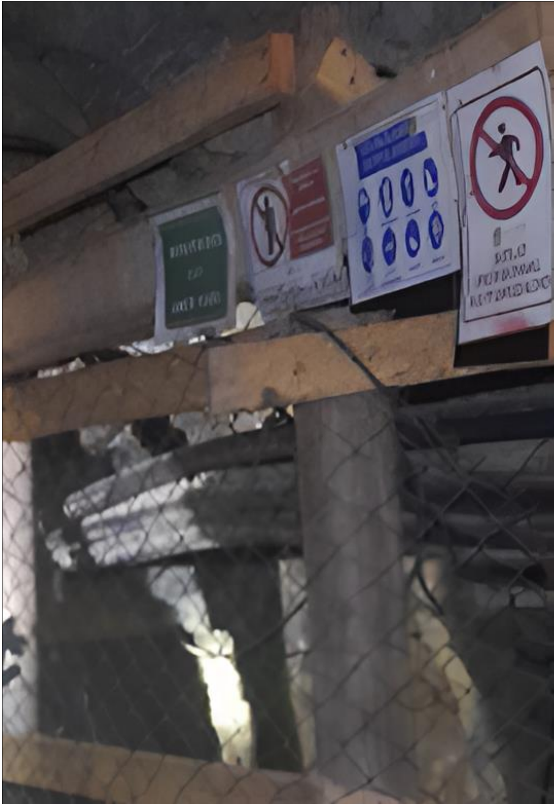
Figura 14. Señalización en accesos del nivel 2 del interior de la mina.
