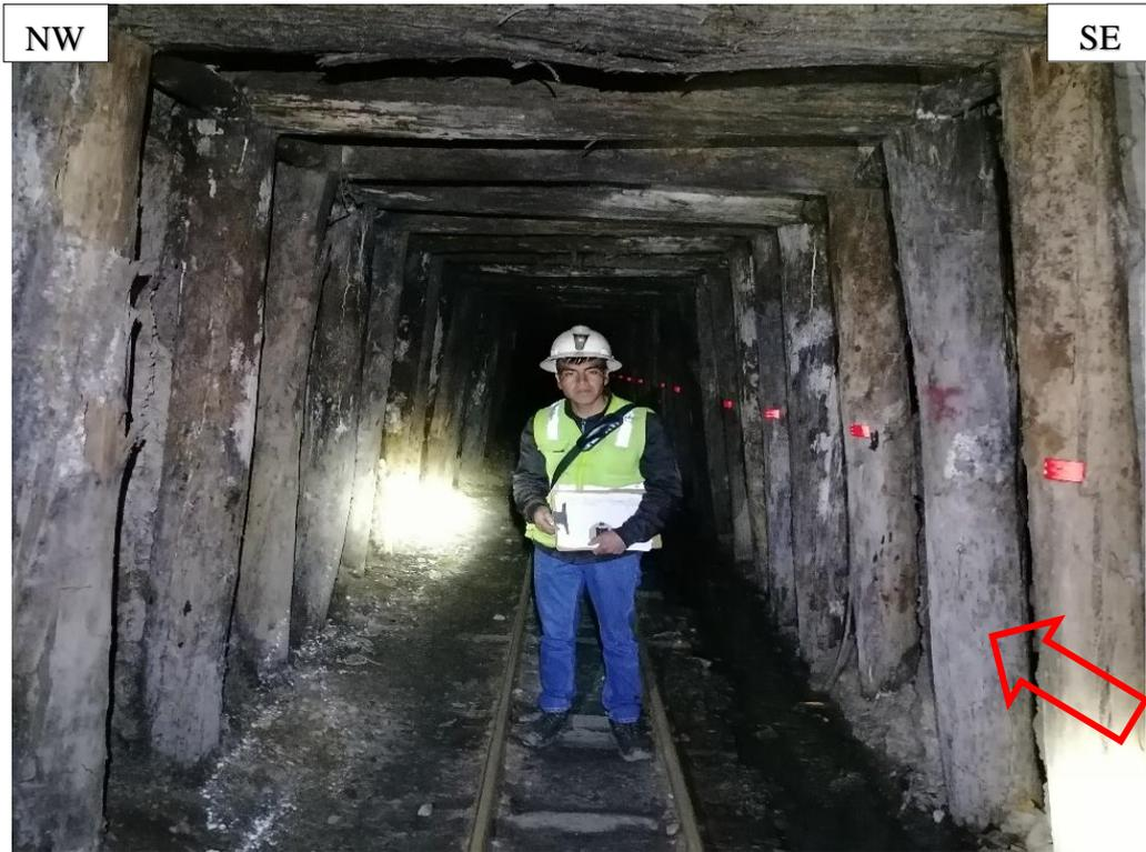
Figura 3.33. Sostenimiento por cuadros de maderos cónicos desde:  $Pi + 4.20$  m. al  $141.50$  m., de madera de eucalipto de diámetro de  $0.30$  m. categorizándolo como roca de mala calidad:  $RQD = 44.81$ ,  $RMR = 38$ ,  $GSI = 33$ ,  $Q = 3.94$  y  $RMi = 8.22$ .
