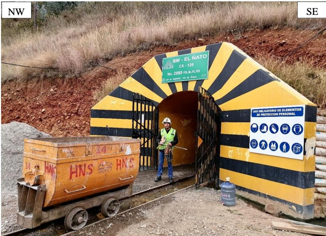
Figura 3.1. Emboquille del cruceo El Ñato, compuesto y estabilizado con muros de concreto armado.
