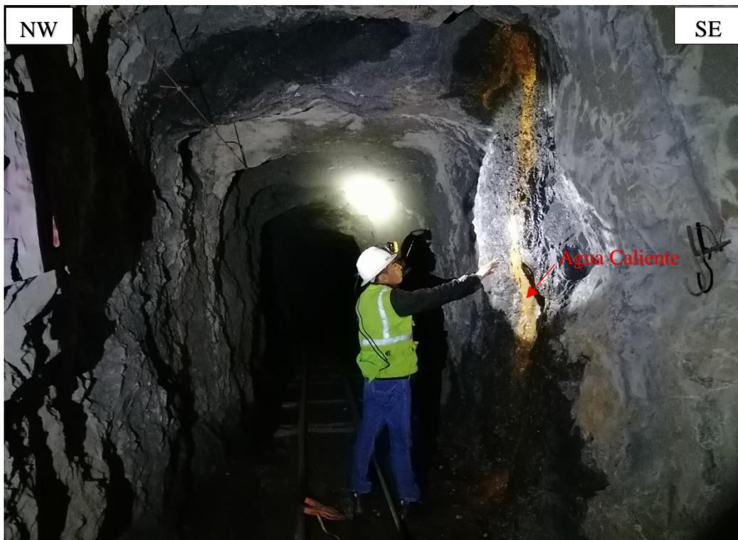
Figura 3.9. Sección ubicada desde Pi + 322.10 m. al 373.15 m., presentando filtraciones de agua fría de la clave y hastiales. Por lo contrario, también presenta nivel freático de agua caliente, que filtran de ambos hastiales por los planos de estratificación, a altura 0.50 m. de la rasante.
