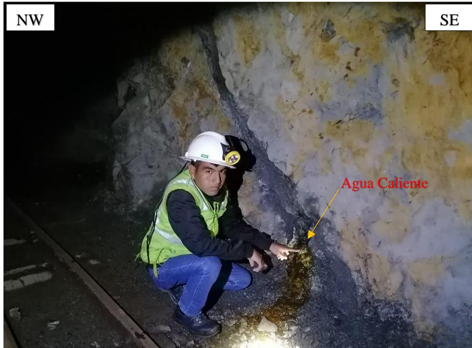
Figura 3.8. Nivel freático de agua caliente, ubicado Pi + 312.90 m. del hastial derecho drenando con orientación SW en relación de los planos de estratificación.
