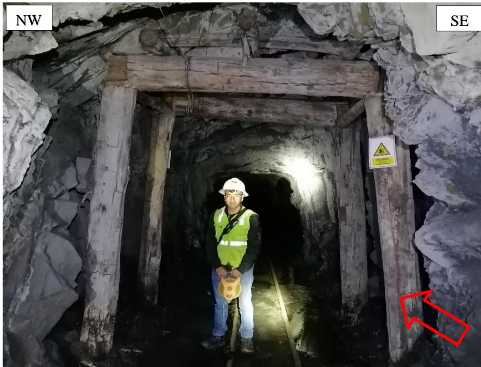
Figura 3.34. Cuadros rectos compuesto de maderos de eucalipto desde:  $Pi + 193.60$  m. al  $200.50$  m., con un diámetro de  $0.35$  m. categorizándolo como roca de mala calidad.
