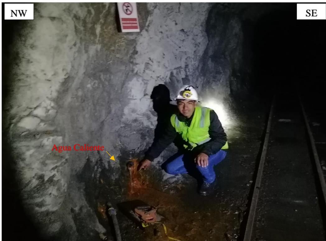
Figura 3.7. Captación del nivel freático de agua caliente mediante entubación de acero horizontal ubicado en el hastial izquierdo del Pi + 240.50 m., de la Formación Carhuaz a altura 0.30 m. del nivel de rasante de la galería principal.
