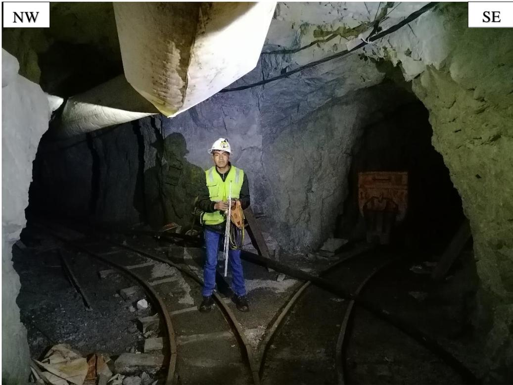
Figura 3.35. Tope de galería principal formando bypass, ubicado Pi + 815 m., cortando a la Formación Chimú, categorizándolo como roca de buena calidad: RQD = 83.72, RMR = 76, GSI = 71, Q = 18.60 y RMI = 58.20.
