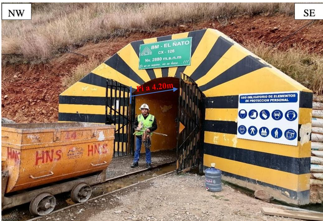
Figura 3.36. Estabilización con concreto armado del emboquille El Ñato y la excavación subterránea desde el Pi + 0.00 m al 4.20 m.
