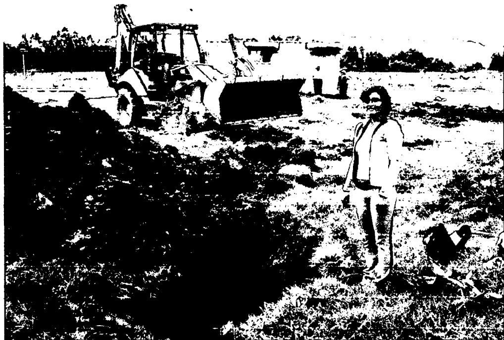
Excavación de calicatas
