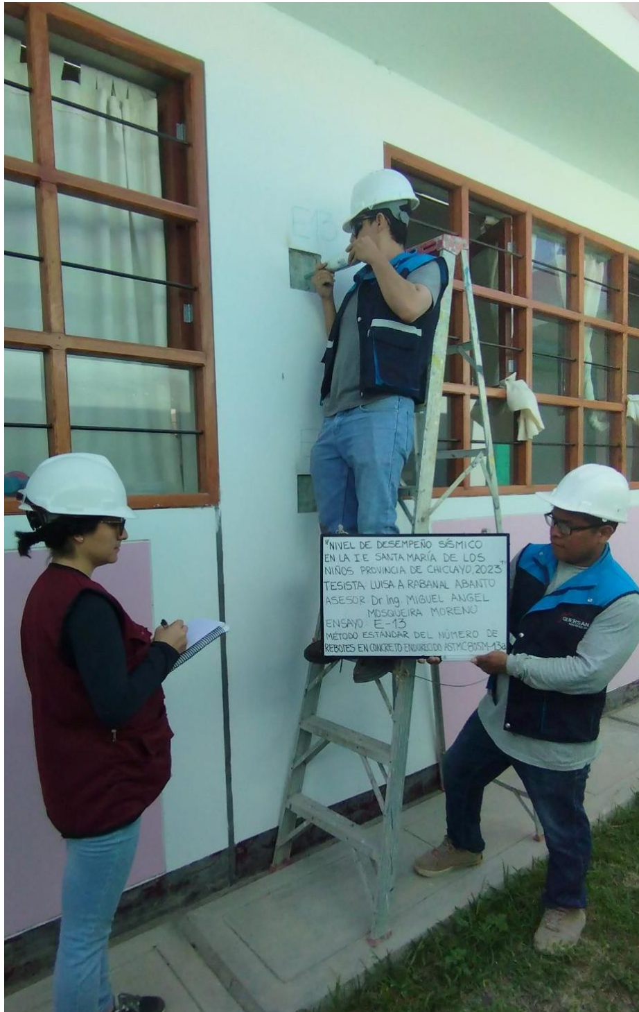
FOTOGRAFÍA N°14 Ensayo 13-MOD.II: Columna N°3 Entre eje 2-2 y I-I
