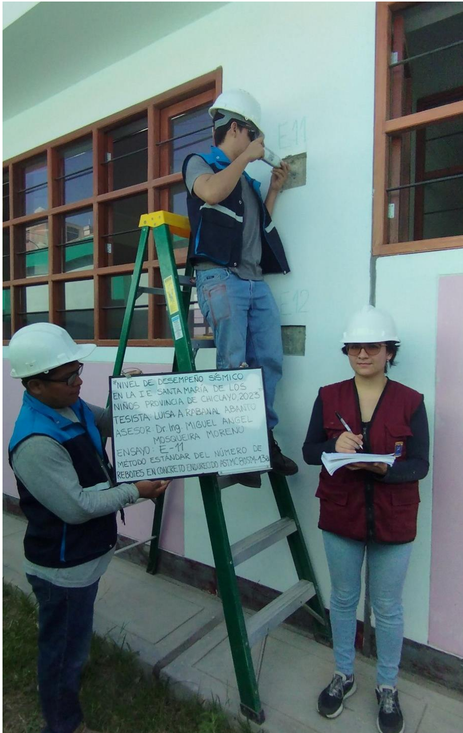
FOTOGRAFÍA N°11 Ensayo 11-MOD.II: Columna N°2 Entre eje 2-2 y G-G
