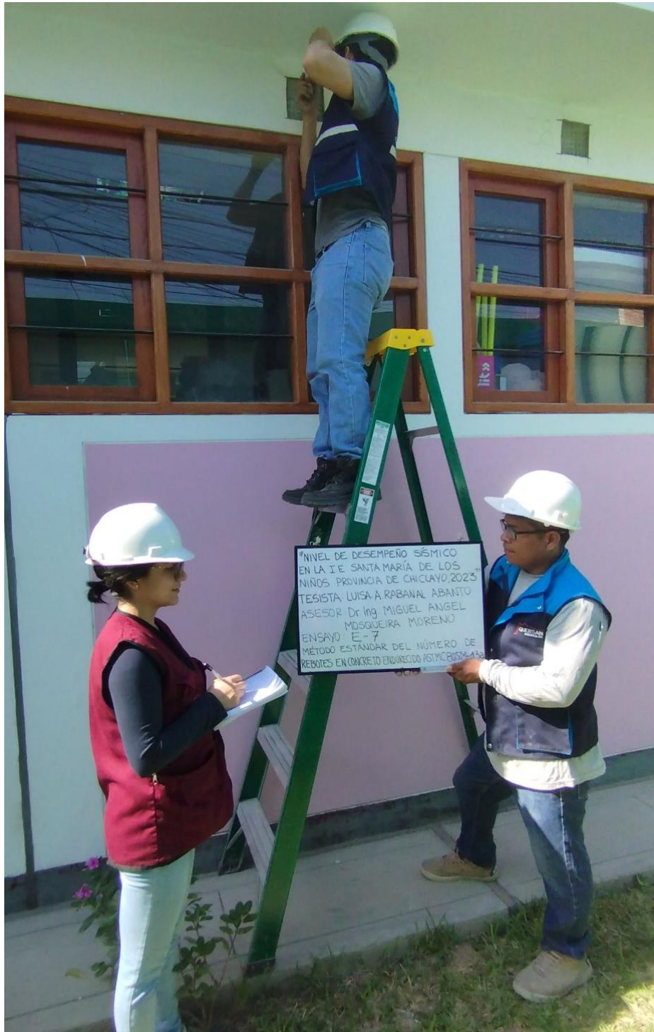
FOTOGRAFÍA N°7 Ensayo 7-MOD.IV: Viga N°1 eje B-B tramo 13 - 15
