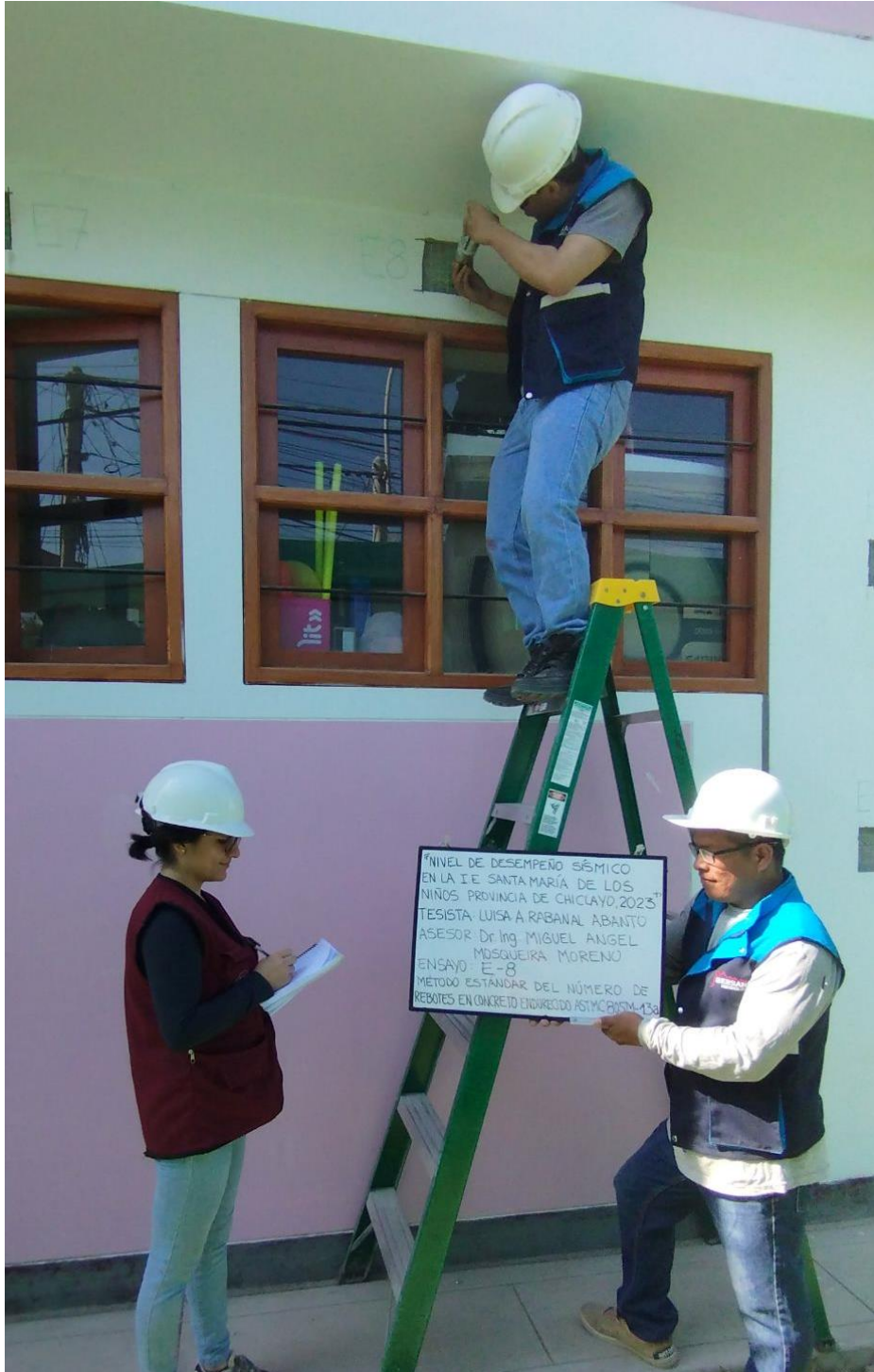
FOTOGRAFÍA N°8 Ensayo 8-MOD.IV: Viga N°1 eje B-B tramo 13 - 15
