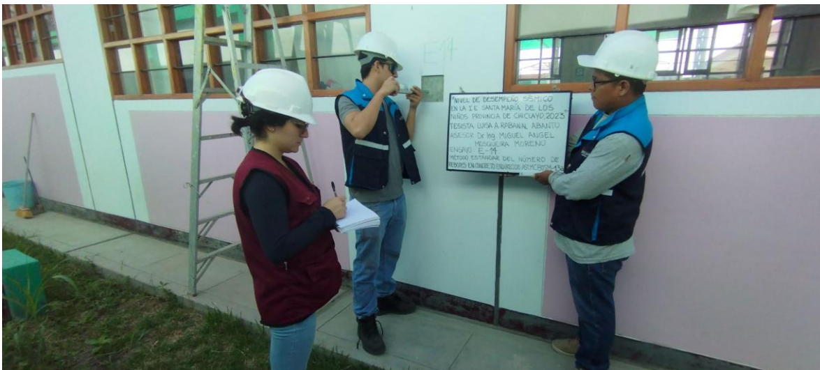
FOTOGRAFÍA N°13 Ensayo 14-MOD.II: Columna N°3 Entre eje 2-2 y I-I
