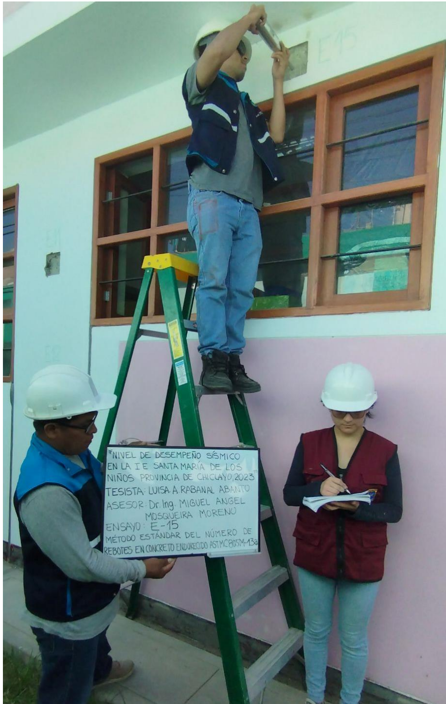
FOTOGRAFÍA N°15 Ensayo 15-MOD.II: Viga N°1 eje 2-2 tramo G-H
