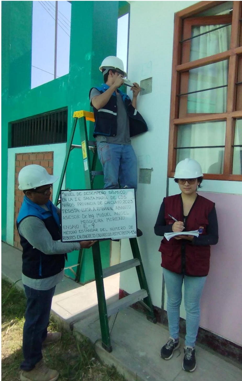
FOTOGRAFÍA N°9 Ensayo 9-MOD.II: Columna N°1 Entre eje 2-2 y C-C
