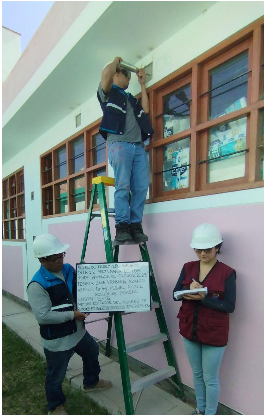
FOTOGRAFÍA N°16 Ensayo 16-MOD.II: Viga N°1 eje 2-2 tramo G-H
