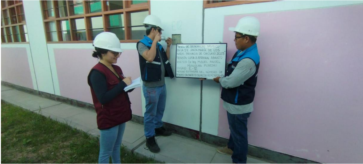
FOTOGRAFÍA N°12 Ensayo 12-MOD.II: Columna N°2 Entre eje 2-2 y G-G
