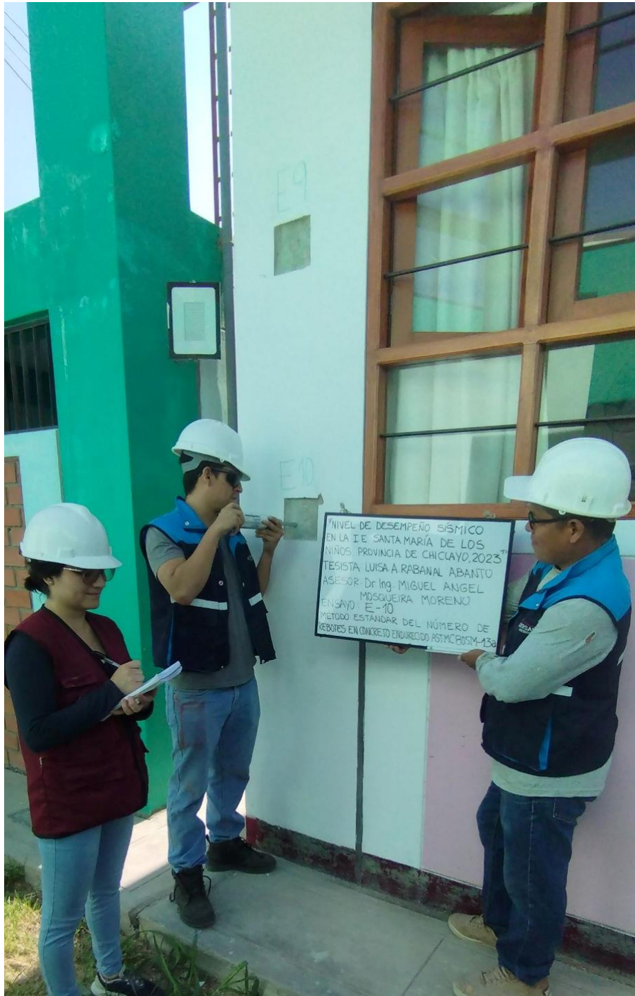
FOTOGRAFÍA N°10 Ensayo 10-MOD.II: Columna N°1 Entre eje 2-2 y C-C
