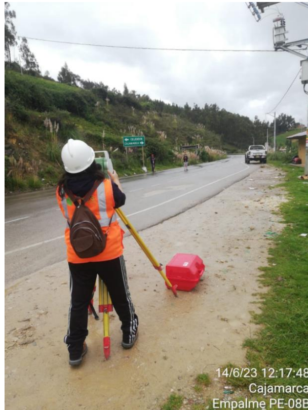
Fotografía 15. Toma de puntos del eje y la berma de la vía en el último día de levantamiento
