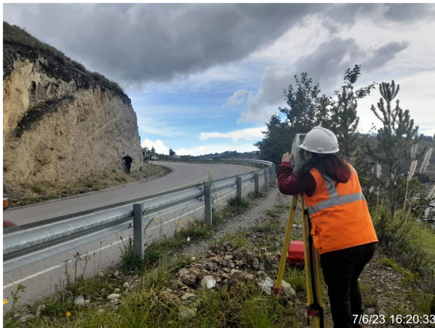
Fotografía 6. Toma de un punto de talud en el tercer día de levantamiento topográfico
