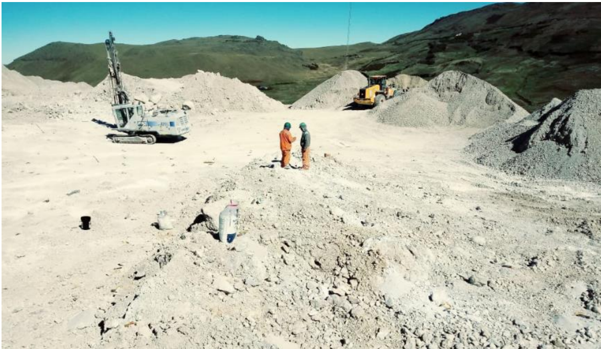
Foto 5. Finalización de perforación e inicio de carguío de explosivo.
