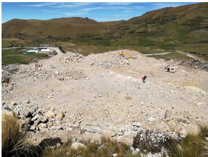
Foto 3. Zona de perforación y voladura.
