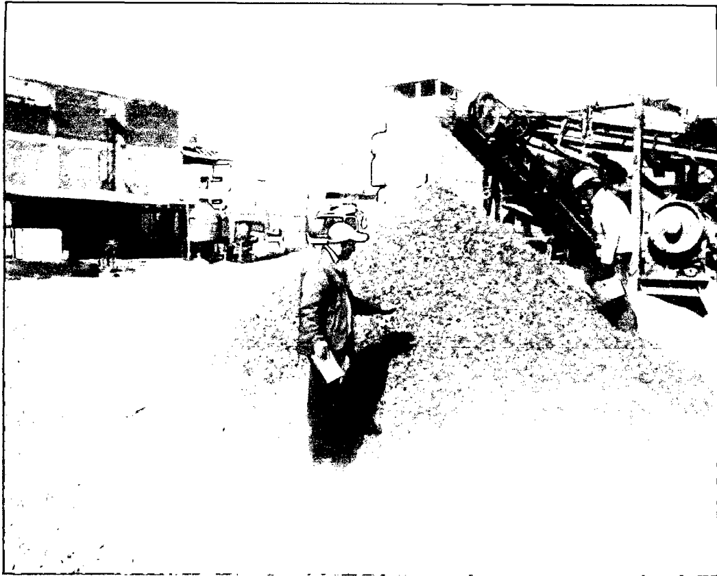
Foto N° 9: Máquina de chancado y material grueso acumulado
