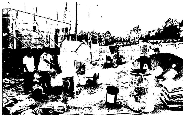
**Fotografía N°7:** Concreto hecho al pie de obra elaborado con mezcladora y con agregado global de cerro ("Caso típico 2").
