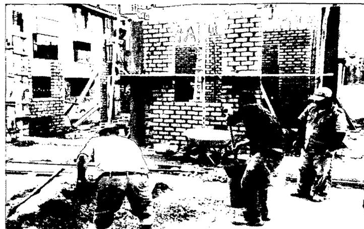
**Fotografía N°14:** Concreto hecho al pie de obra con a agregado global para columnas y elaborado de forma manual.
