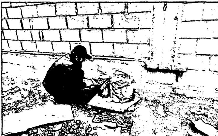
**Fotografía N°21:** Protección de las muestras elaboradas en campo, hasta que completen su fraguado.
