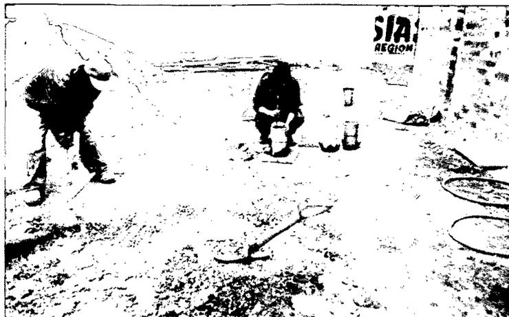
**Fotografía N°4:** Elaboración de especímenes cilíndricos de concreto hecho al pie de obra para evaluar su resistencia.
