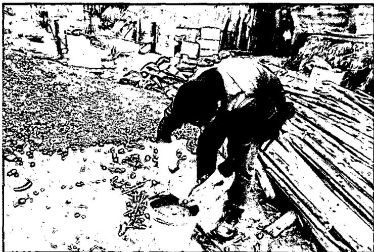
**Fotografía N°17:** Muestreo de concreto elaborado con agregado global de cerro ("Caso típico 2"), de mayor uso en concreto hecho al pie de obra.
