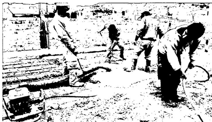
**Fotografía N°51:** Proceso de colocación del concreto premezclado en losa aligerada. El personal necesario es mínimo (03).
