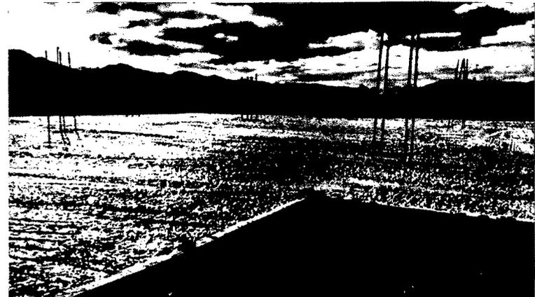
**Fotografía N°47:** Losa aligerada terminada en poco más de 2 horas, el proceso de colocación del concreto es rápido, los trabajos de acabado son los que tardan un poco.
