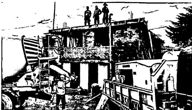
**Fotografía N°41:** Se observa la instalación del sistema de bombeo para colocar el concreto premezclado en losa aligerada de vivienda unifamiliar.
