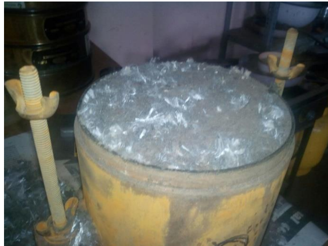
Fotografía N° 05 – Suelo reforzado compactado
