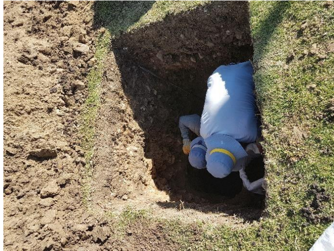
Fotografía N° 01- Calicata de muestra de suelo
