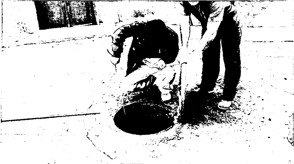
Foto 5. Inspección de los buzones, altura de sedimentos y profundidad
