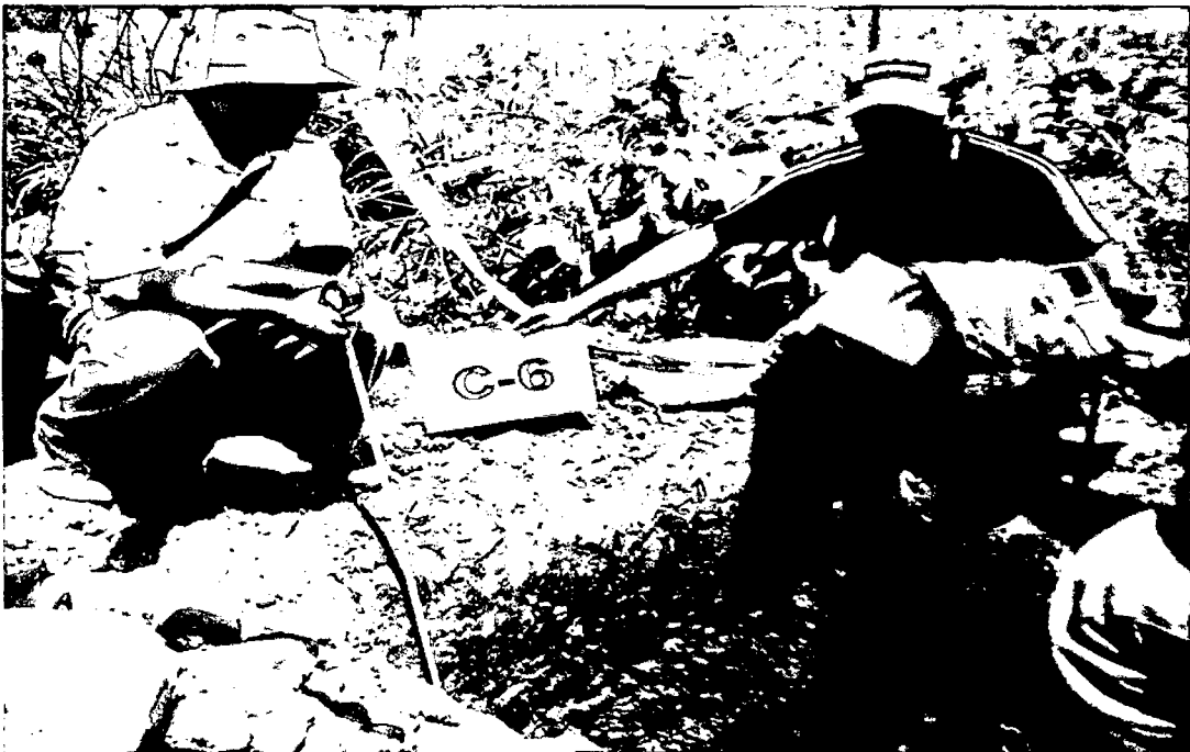
Foto 21. Calicata C - 06 en la planta de tratamiento de aguas residuales. (Sedimentador Dortmund)
