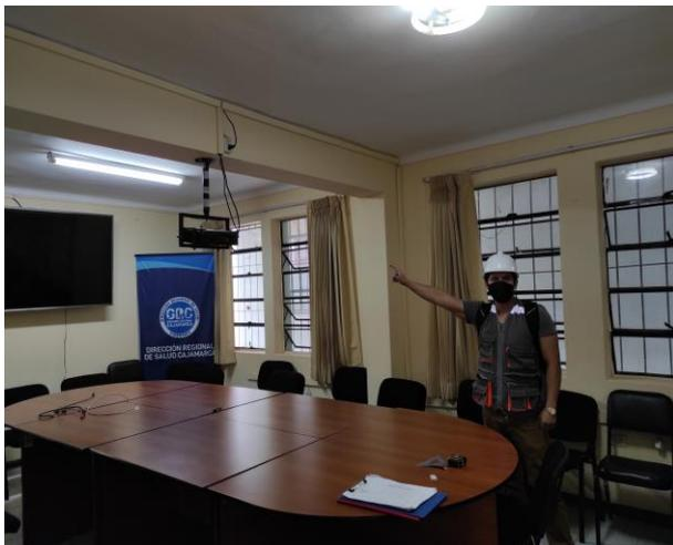
Muro portante removido y viga reforzara en segundo nivel del pabellón N°2 para ampliación de la sala de reuniones.
