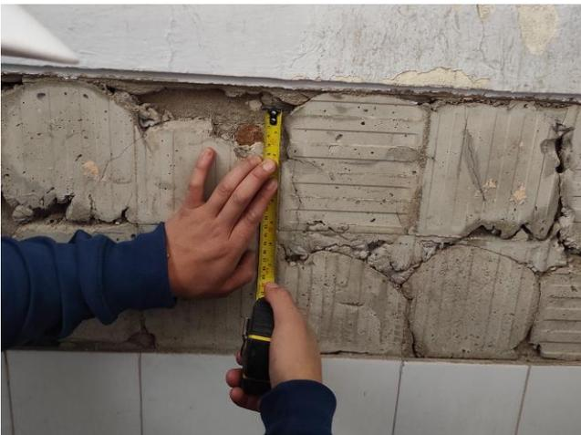
Desprendimiento de cerámica de las paredes de los baños donde además se aprecia el tipo de ladrillo utilizado y el espesor de juntas de mortero.
