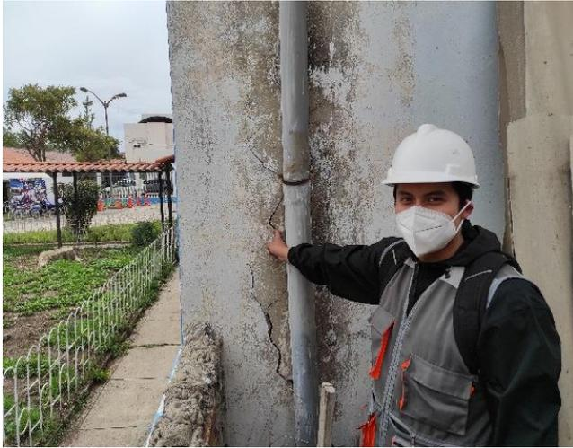
Grieta probablemente producida por desgarro en una de las esquinas del pabellón N°1, además de observarse el mal estado de conservación de las abrazaderas y tubería de drenaje pluvial. La grieta de la imagen des de 0.5cm,
