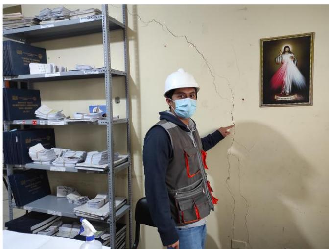
**Figura 49:** Grieta en muro portante del primer nivel del pabellón N° 1
