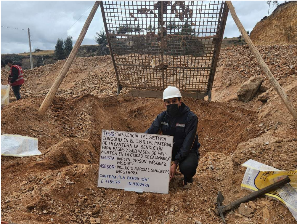
Figura 9. Extracción de material de la cantera La Bendición
