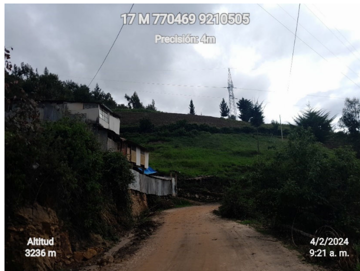
Figura 56. Talud del tramo Km 07+531 al Km 07+765 con pastos y vegetación ligera, y pendiente pronunciada
