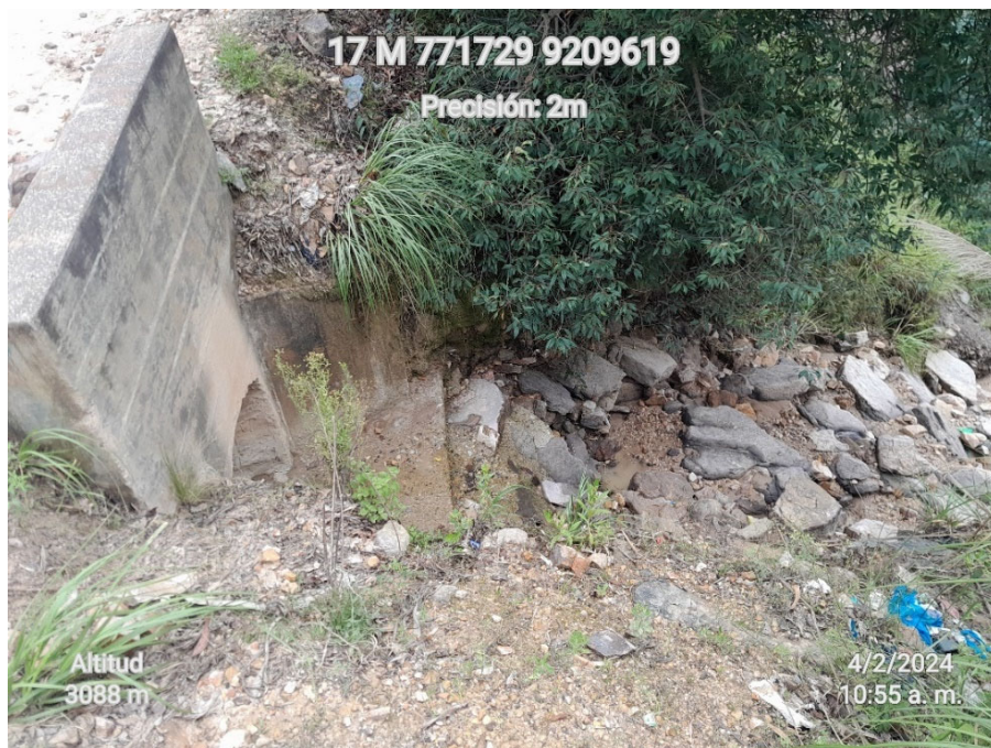
Figura 20. Entrada y salida de alcantarilla N°04
