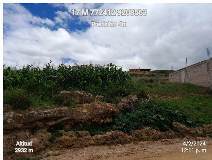
Figura 43. Talud del tramo Km 02+636 al Km 03+155 con cultivos, y pendiente media
