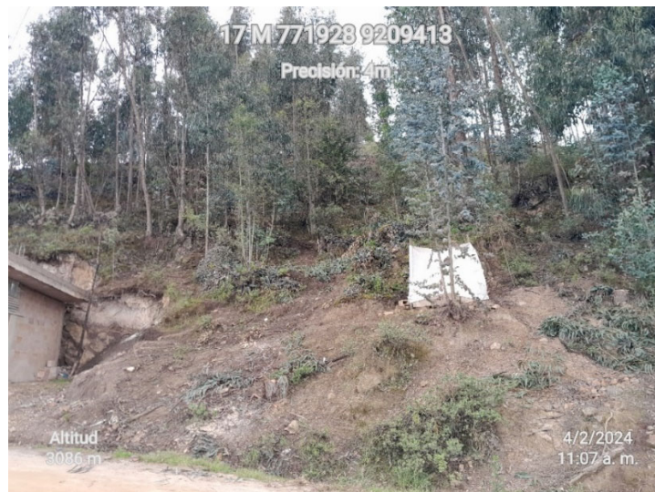
Figura 47. Talud del tramo Km 05+000 al Km 05+650 con bosques y densa vegetación, con pendiente pronunciada
