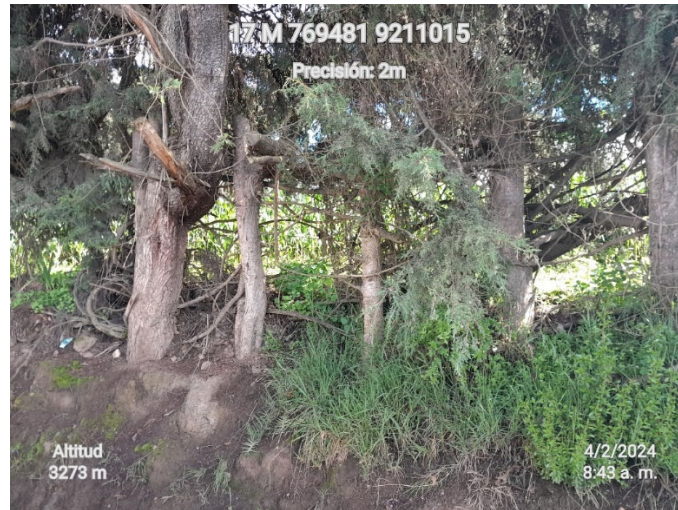
Figura 62. Talud del tramo Km 08+620 al Km 09+520 con cultivos, y pendiente media
