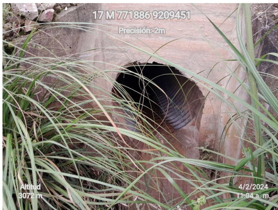
Figura 19. Entrada y salida de alcantarilla N°03
