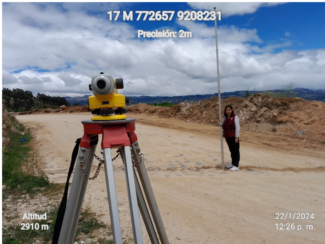
Fotografía N° 1: Levantamiento topográfico con nivel en la sección del Badén N°06 (Km.02+353.216)
