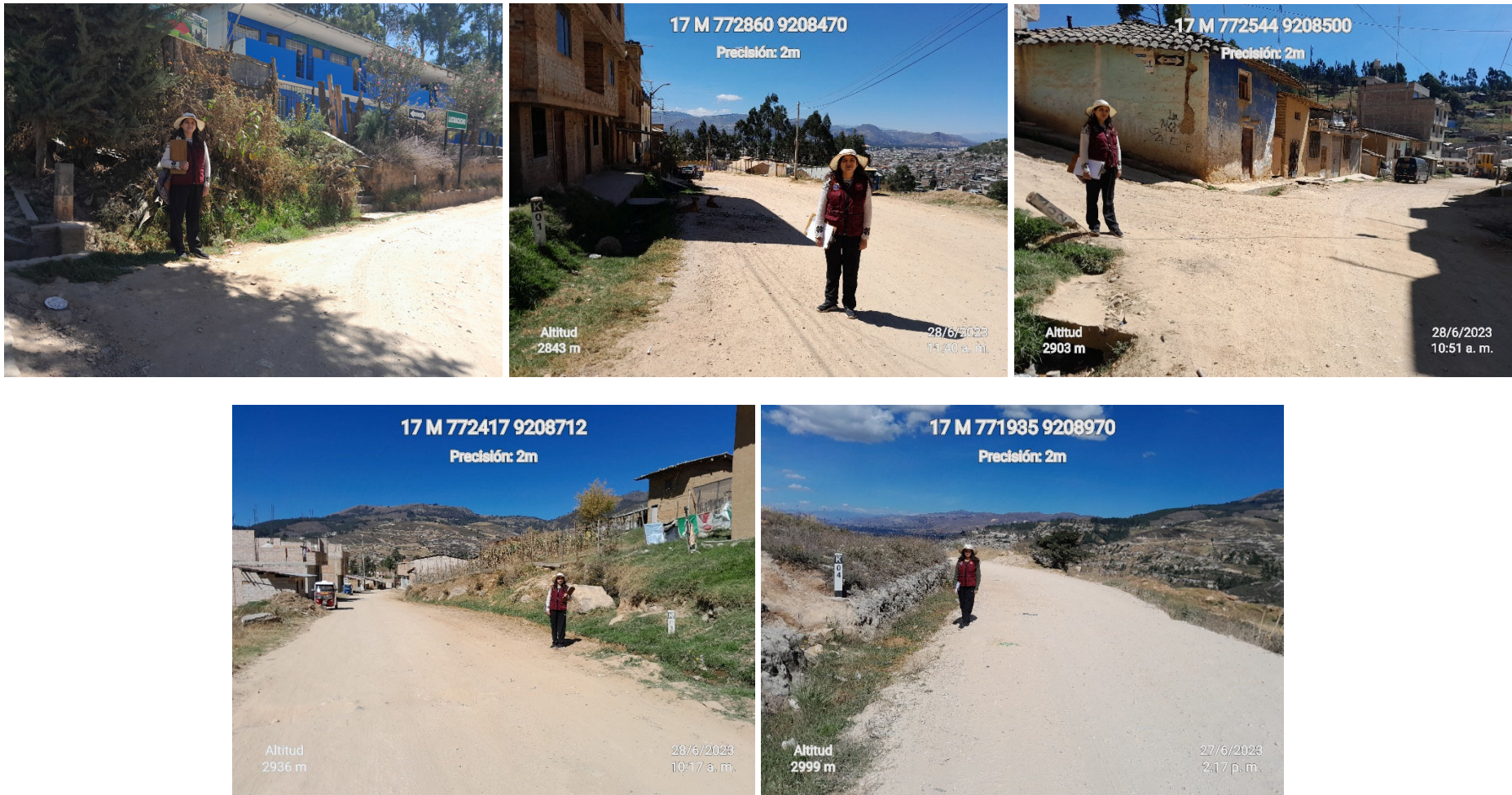
Fotografía N° 11: Kilometraje existente en la vía Cajamarca – C.P. Chamis (Km.00 – Km.04)
