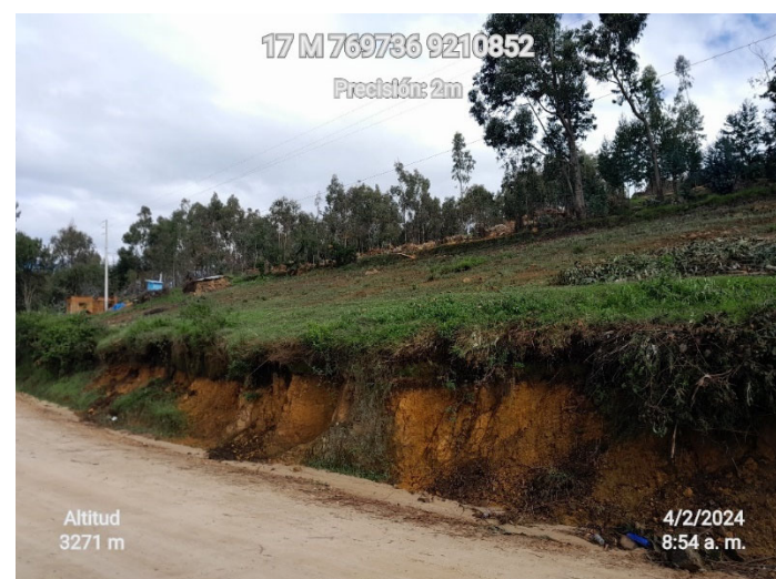
Figura 61. Talud del tramo Km 08+460 al Km 08+620 con pastos y vegetación ligera, con pendiente alta
