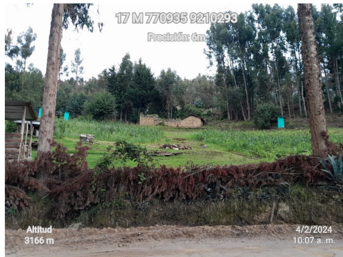
Figura 50. Talud del tramo Km 06+316 al Km 06+540 con cultivos, con pendiente alta
