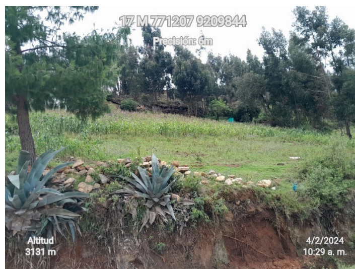
Figura 49. Talud del tramo Km 06+085 al Km 06+316 con cultivos, con pendiente pronunciada
