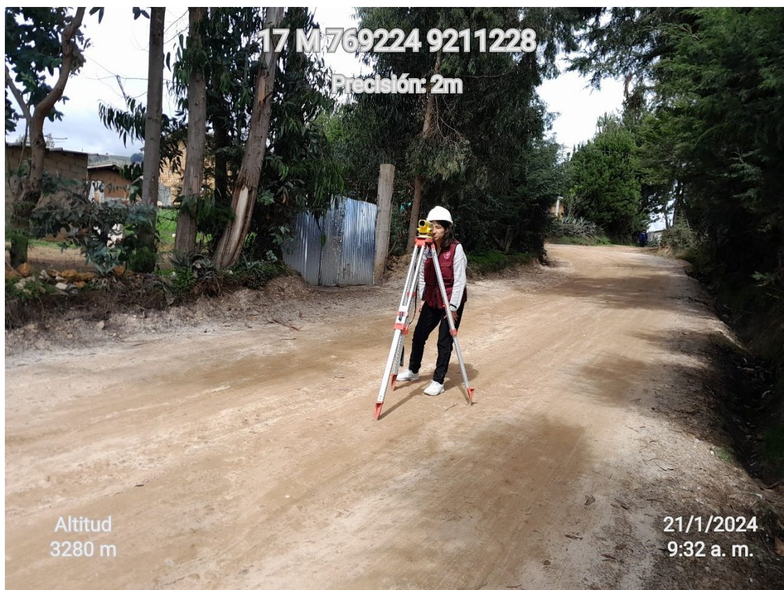
Fotografía N° 10: Levantamiento topográfico con nivel del perfil de cunetas (Km.09)
