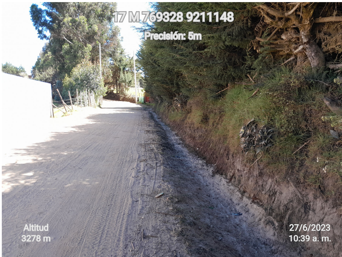
Fotografía N° 9: Estado actual de cunetas Km.09
