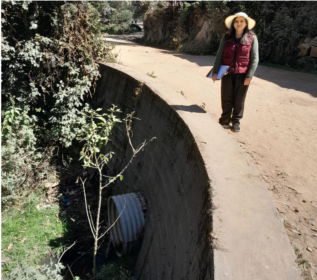
Fotografía N° 7: Salida de alcantarilla en el Km.07
