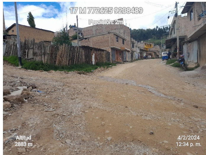
Figura 41. Talud del tramo Km 00+600 al Km 02+090 con viviendas, y pendiente alta
