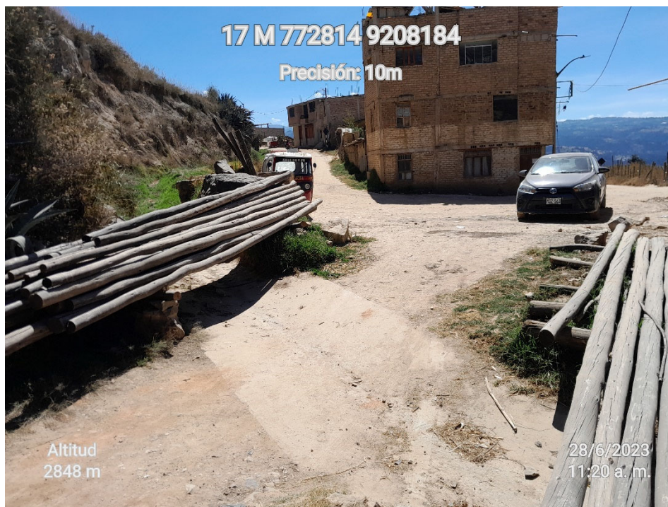
Figura 26. Estado actual de badén N°04
