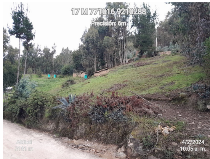
Figura 51. Talud del tramo Km 06+540 al Km 06+800 con pastos y vegetación ligera, con pendiente alta
