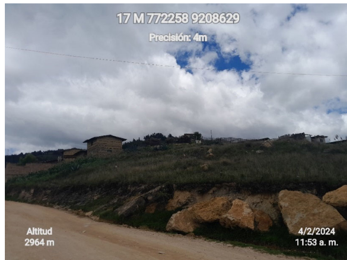
Figura 44. Talud del tramo Km 03+155 al Km 04+025 con hierba y grama, con pendiente media
