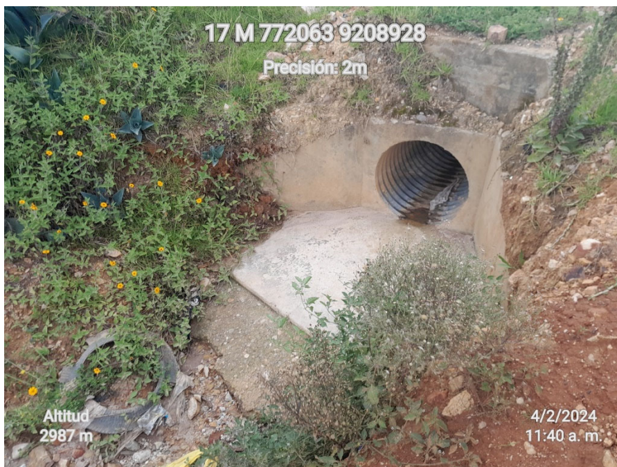
Figura 18. Entrada y salida de alcantarilla N°02
