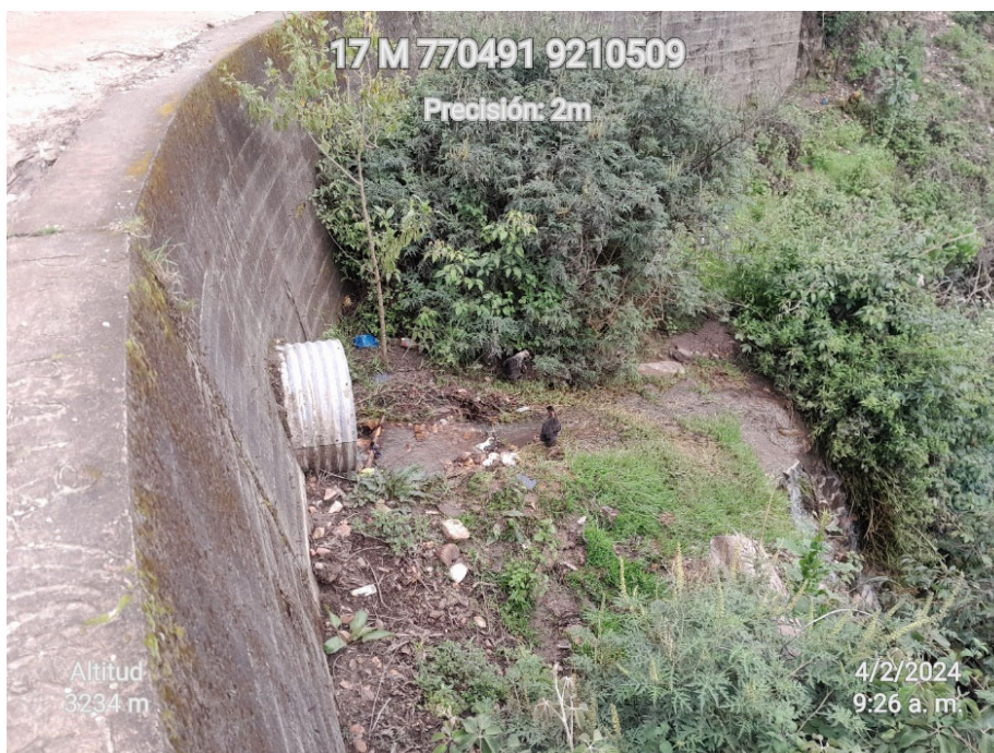
Figura 22. Entrada y salida de alcantarilla N°06
