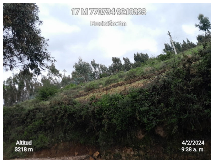
Figura 54. Talud del tramo Km 07+114 al Km 07+400 con pastos y vegetación ligera, y pendiente pronunciada
