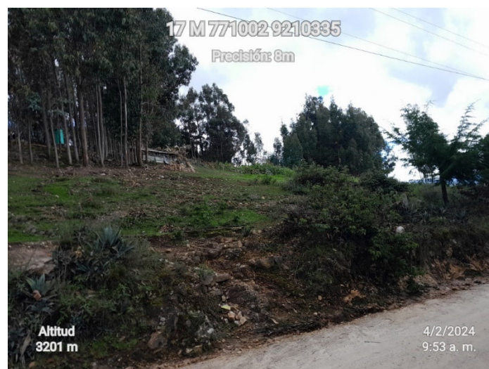
Figura 52. Talud del tramo Km 06+800 al Km 07+040 con pastos y vegetación ligera, y pendiente pronunciada
