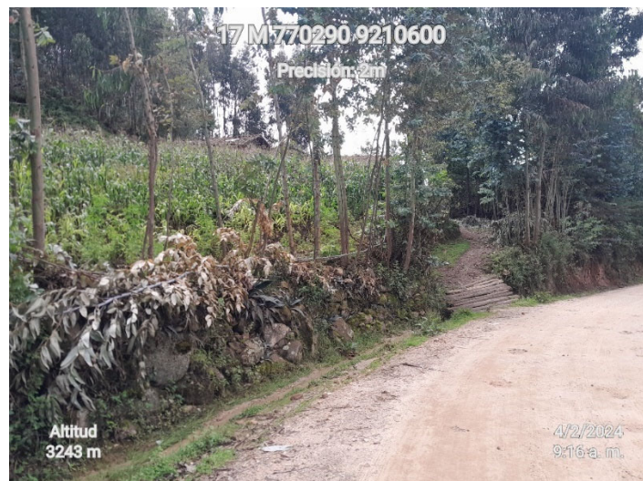
Figura 57. Talud del tramo Km 07+765 al Km 07+832 con cultivos, y pendiente media
