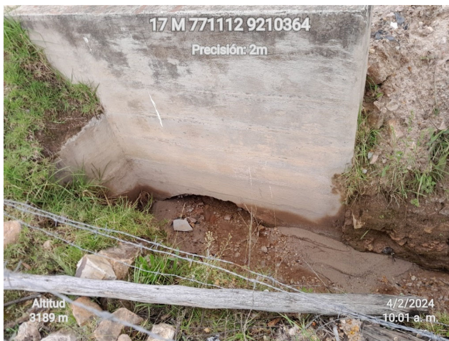
Figura 21. Entrada y salida de alcantarilla N°05
