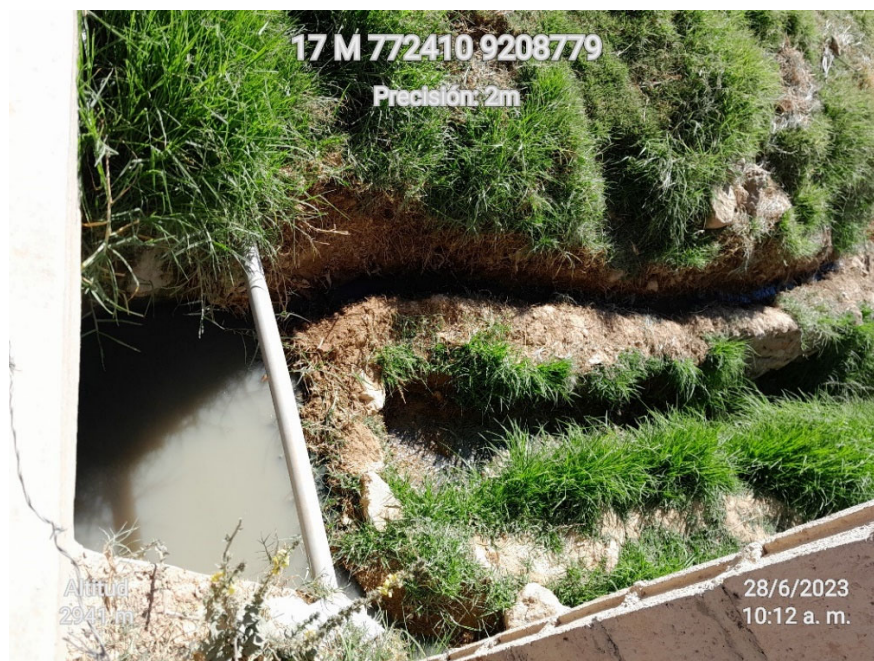
Figura 17. Entrada y salida de alcantarilla N°01
