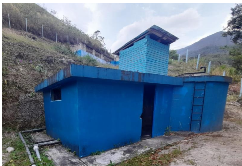
Foto N° 5. Reservorio, clorador y caseta de válvulas
