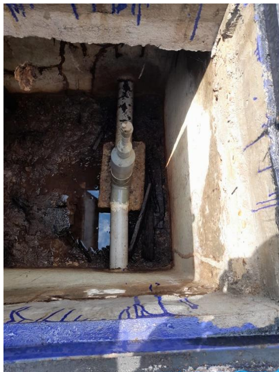
Foto N° 13. Válvula de Aire N° 01
