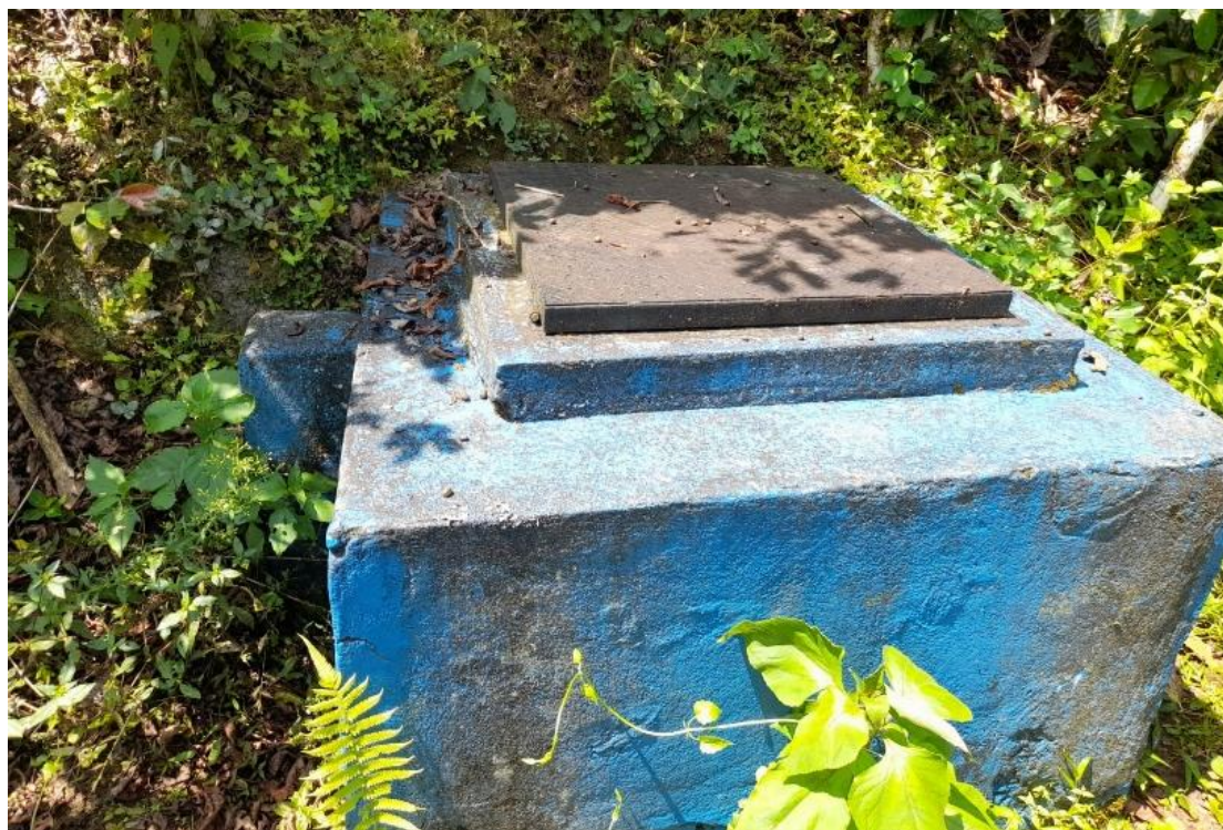
Foto N° 9. Cámara Rompe Presión Tipo 6 – 02
