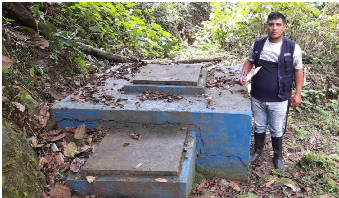
Foto N° 9. Cámara Rompe Presión Tipo 6 – 02
