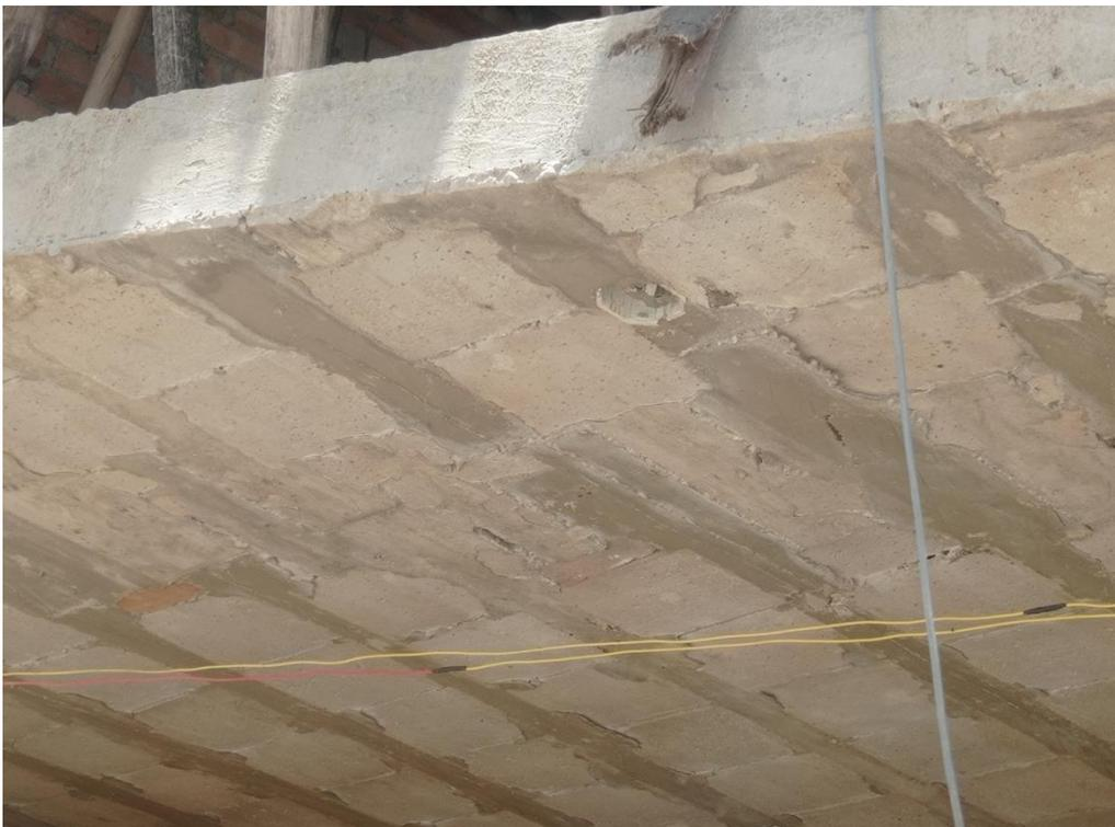
Fotografía N° 6: Incumplimiento de procesos constructivos (Caja octogonal colocada en vigueta de losa aligerada)
