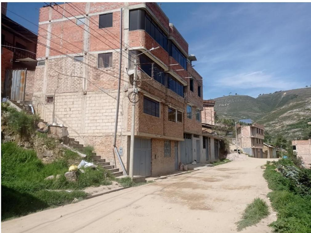
Fotografía N° 8: Vivienda cercana a la zona del deslizamiento, donde se observa el uso de diferentes tipos de ladrillo en la vivienda, generando un cambio de rigidez
