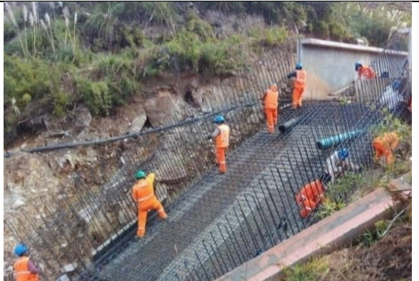
07 ACERO DE REFUERZO fy=4200 kg/cm2
