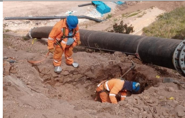
19 EXCAVACIÓN DE ZANJAS - MANUAL
