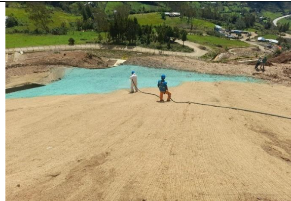
16 SUMINISTRO Y COLOCACIÓN DE HIDROSIEMBRA
