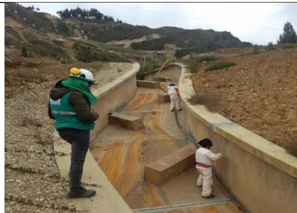
31 JUNTA DE CONTRACCIÓN
