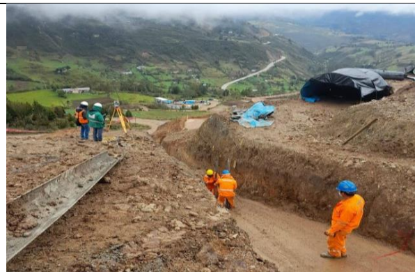
23 REFINE Y NIVELACIÓN DE TERRENO
