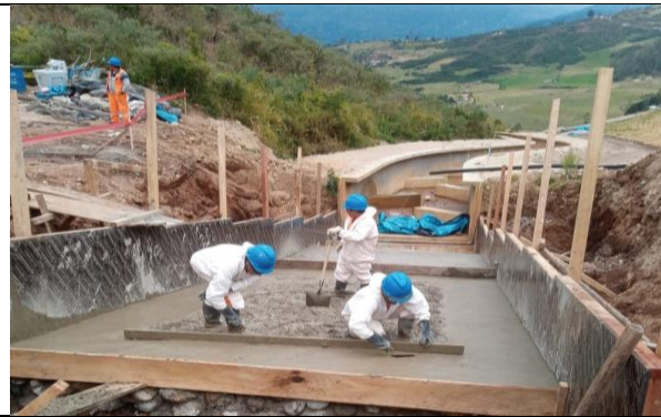
23 REFINE Y NIVELACIÓN DE TERRENO
