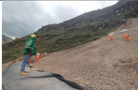
15 SUMINISTRO Y COLOCACIÓN DE GEOCELDA (INCLUYE TENSOR) – TRASLADO Y TENDIDO C/ EQUIPO
