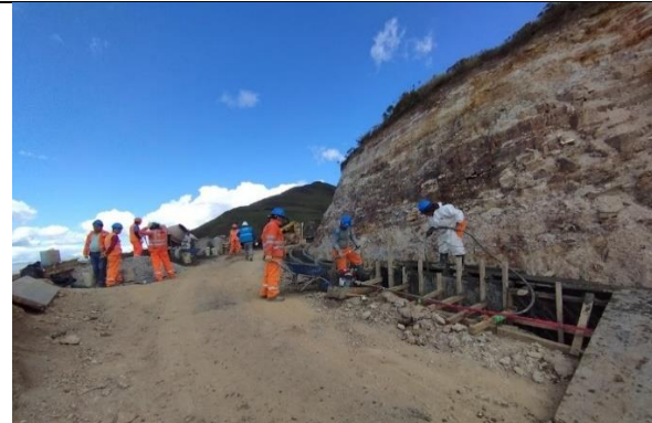
16 SUMINISTRO Y COLOCACIÓN DE HIDROSIEMBRA
