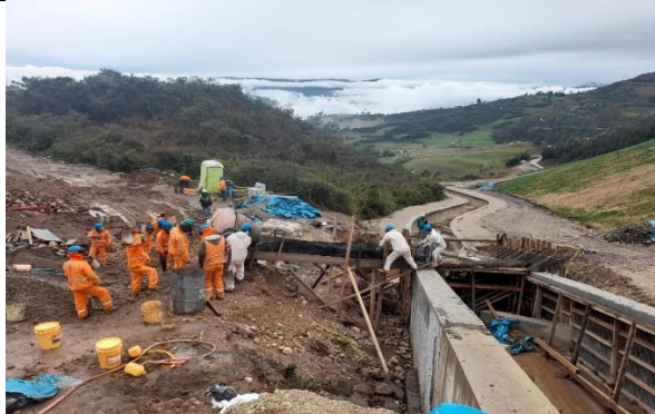
05 ENCOFRADO Y DEENCOFRADO CANAL
