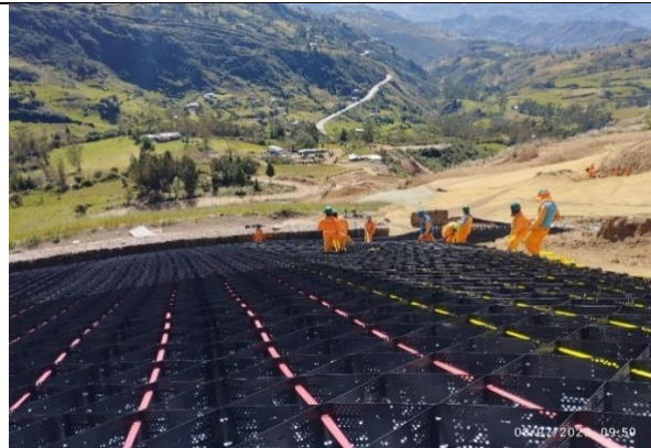
15 SUMINISTRO Y COLOCACIÓN DE GEOCELDA (INCLUYE TENSOR) – TRASLADO Y TENDIDO C/ EQUIPO
