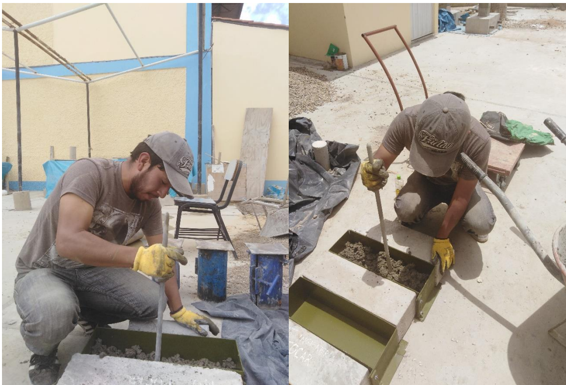
Figura 66: Colocación y compactación de la mezcla en los moldes prismáticos.
