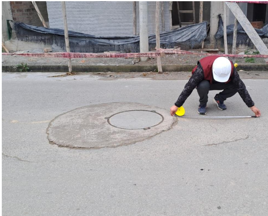
Figura 229: Medición de falla por hundimiento. UM-44
