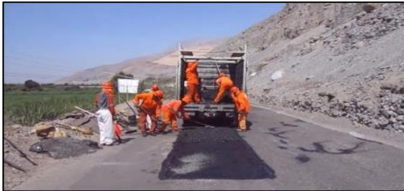
Figura 8: Parchado superficial en calzada.
