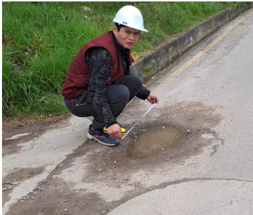
Figura 231: Medición de hueco. UM-52
