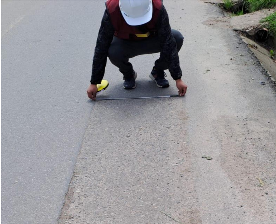
Figura 229: Medición de falla por hundimiento. UM-44
