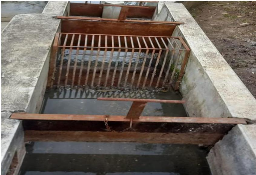
Al observar la estructura concerniente a la cámara de rejas presenta un buen estado, correctamente tarrajado, presentando un agrietamiento visible en la parte media del by pass, el cual no ocasiona ninguna interferencia en el funcionamiento de la misma.
