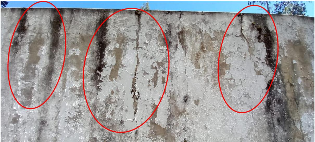
En esta estructura hay presencia de fisuras muy visible en todo su perímetro y deterioro total de la pintura en todos los frentes.
