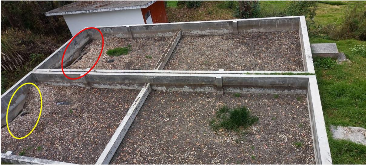
Figura 21. Agua residual no filtrada en el filtro percolador.
