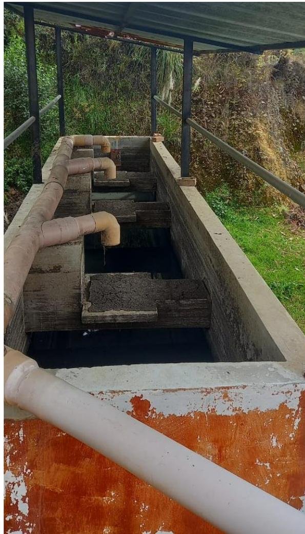
Los lechos de secado se encuentran con la pintura en mal estado y como también el techo en la parte del fondo ya deteriorada, sin embargo, no se visualizan grietas en el concreto.
