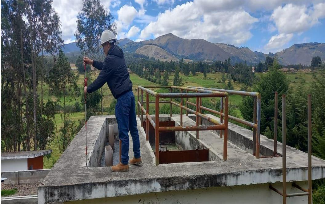
Figura 18. Deterioro de la pintura en las partes laterales del tanque Imhoff.
