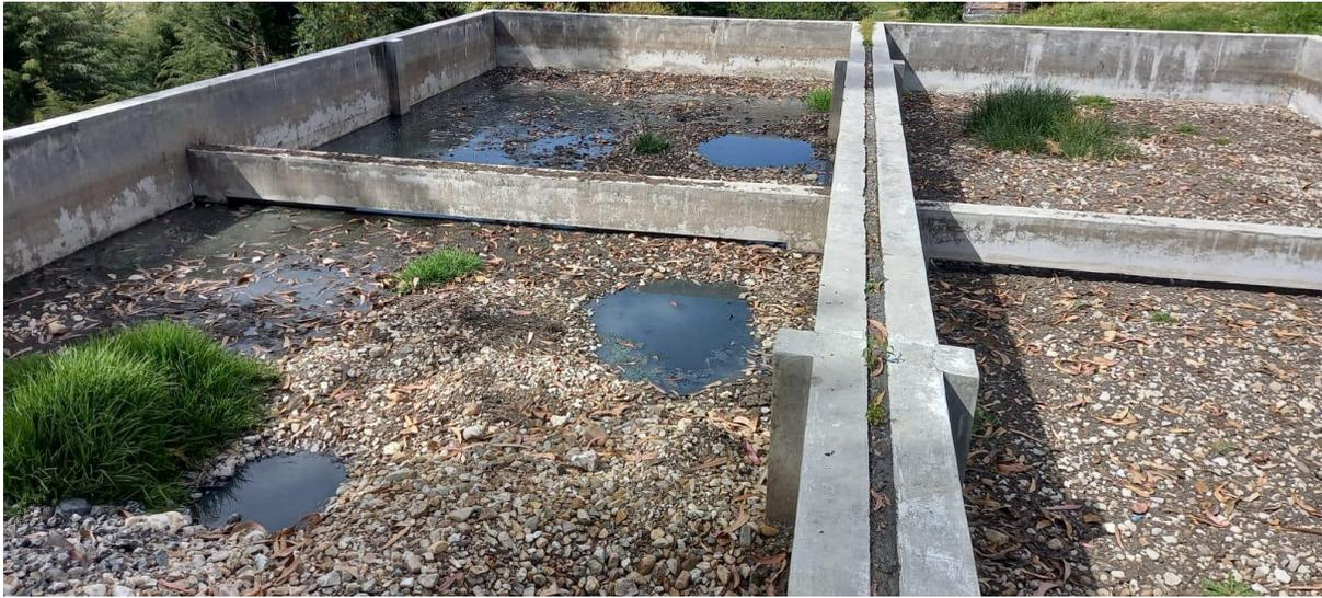
Figura 31. Rotura de tubería de distribución del agua residual.
