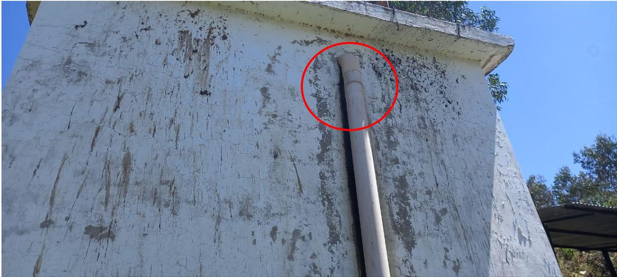
Observamos en la figura N° 18 el deterioro total de la pintura por acción de la humedad en todo su perímetro y en la figura N° 19 se observa una fuga de agua residual en la parte de la salida que alimenta al filtro percolador, ocasionando malestar a los ganaderos que alimentan a su ganado de heno regado por esta agua, ya que va directamente a estos pastizales, más aún, provocando malos olores y proliferación de enfermedades.
