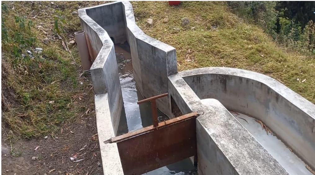
La criba está compuesta por barras de acero inoxidable de sección transversal de 6.4 mm de espesor, espaciados 25.4 mm e inclinadas 60° con respecto a la horizontal la cual está anclada a la estructura de cemento. Sin embargo, esta estructura in situ tiene de acero liso de 12.7 mm
