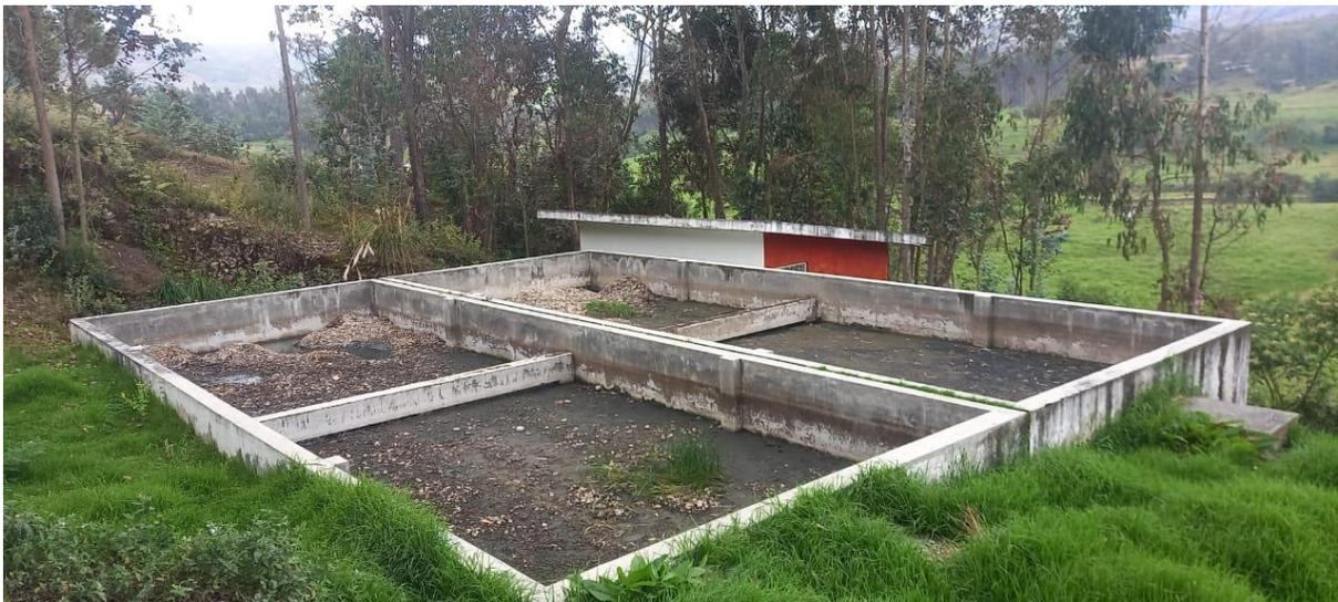
Se observa en la figura N° 20 la forma de como se ha diseñado el filtro percolador y como la tubería está distribuida a lo largo y ancho del filtro, además de que, la tubería filtrante perforada está enterrada, lo que ocasiona alta carga hidráulica en todo el perímetro del filtro percolador como se observa en la figura N° 21
