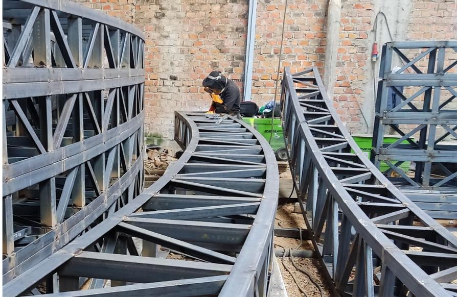
En la **Figura 76**, se llevó a cabo el procedimiento de soldadura en la celosía de los segmentos de tijeral que, de acuerdo al plano de taller indica que, tiene que ser soldadura de filete con electrodo de 1/8" E-6011 para mayor penetración en el material base, con un cateto de 3/16", evitando la distorsión de soldadura; Con una separación de diagonales con montante de 1.5cm, El contorno es convexo y acabado G: pulido o esmerilado.
