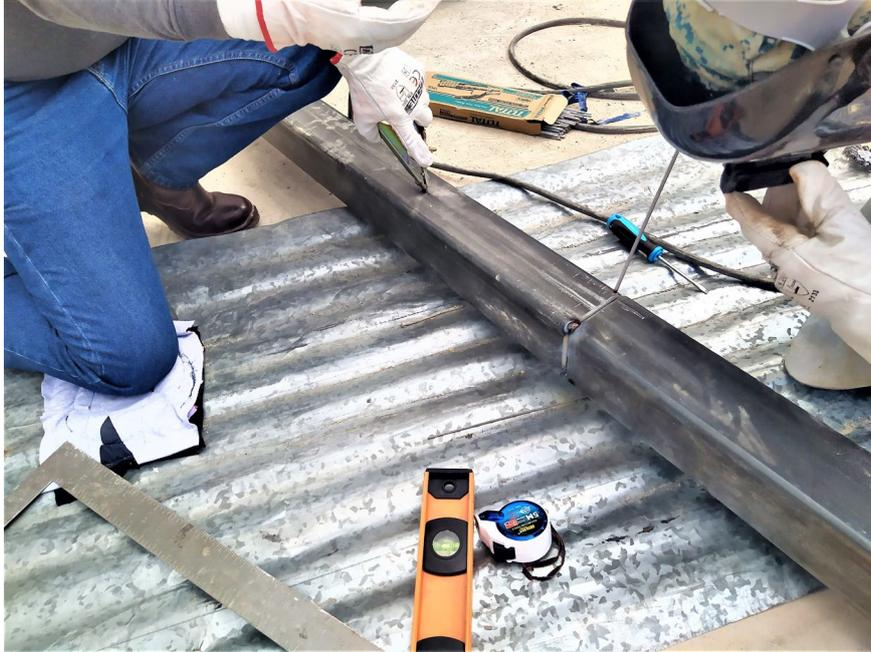
En la **Figura 74**, se puede ver el procedimiento realizado para la soldadura de bridas, en la tubería de 4" x 4" x 6mm. Se ha procedido con el biselado unilateral a tope o en V a 45°, de la tubería en la junta; Esto de acuerdo al plano de taller que indica soldadura en V, todo alrededor, con electrodo de 1/8" E-6011, como material de aporte para tener mayor penetración en el material base.
