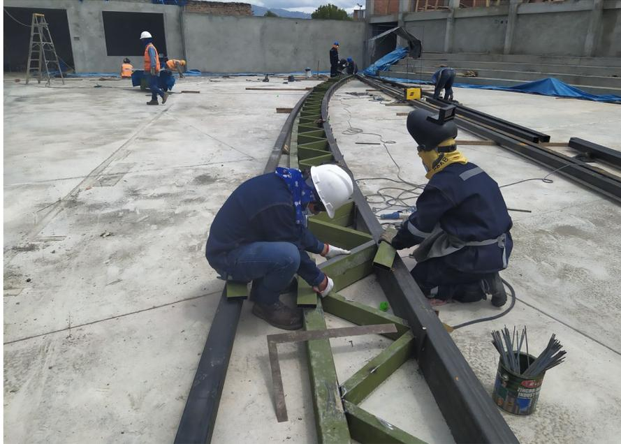
En la **Figura 65**; Para el armado de estos tijerales completos y teniendo como patrón de armado la plantilla, solo se tenía que reproducir sobre esta el resto de los tijerales, teniendo la seguridad de que la curvatura de los tijerales no variaría, a pesar de la forma irregular del terreno.
