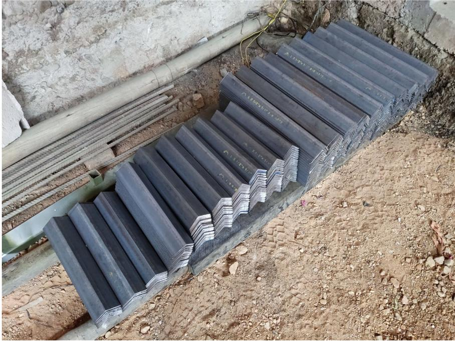
En la **Figura 62**, se muestran los cortes realizados con la tronzadora, además de la verificación de las medidas indicadas en el plano de taller del techo parabólico de la Infraestructura para el Almacén–Semillero-Michiquillay, asimismo, que el corte realizado, haya quedado a 90 grados, ya que las diagonales tienen que encajar correctamente entre montantes del tijeral.
