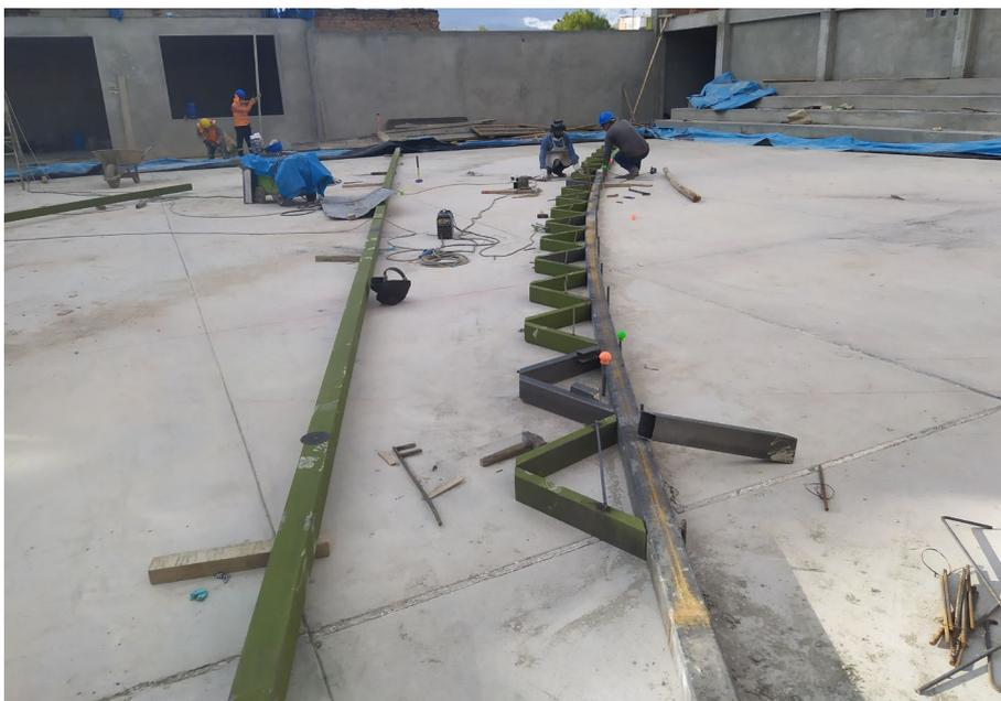
En la **Figura 52**, se observa la colocación de las diagonales, de acuerdo al plano de taller que, indicaba un destaje de 4.5cm en ambas puntas de la celosía, las cuales serán ubicadas a tope teniendo en consideración el proceso de soldadura según detalle del plano, completando el tijeral con la colocación de la brida superior. La plantilla servirá como patrón para el armado de los 10 restantes.
