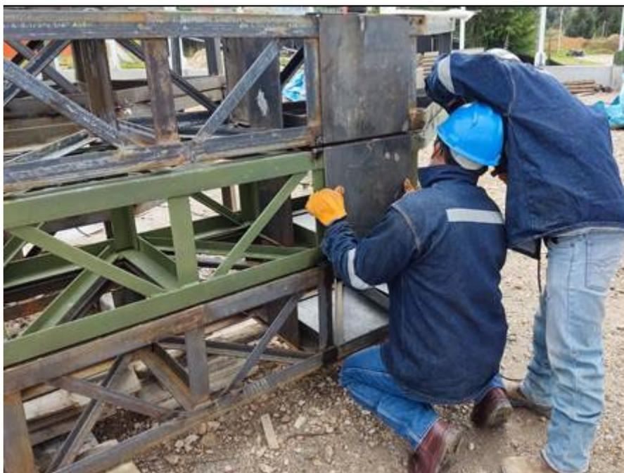
En la **Figura 71**, se observa el armado de las cajuelas de apoyo de los tijerales parabólicos, teniendo en cuenta el plano de taller y las consideraciones, dejar como máximo 1.0cm entre la unión de las planchas laterales de las cajuelas y los ángulos de las bridas
