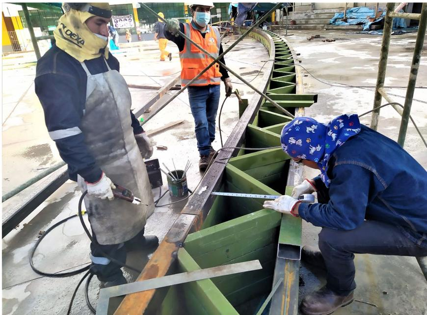
En la **Figura 72**, se está llevando a cabo el control de las dimensiones en el peralte del tijeral, así como también, el control del espaciamento de la celosía, tal como lo indican los detalles en los planos de taller y teniendo en cuenta lo que señala la norma E.090 de estructuras metálicas, en la que se rechazarán estructuras con errores de conformación durante la fabricación.
