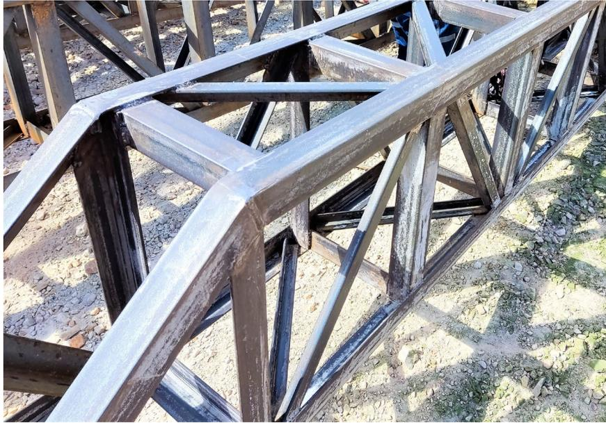
En la Figura 77, se muestra el soldado en bridas y aleros de los tijerales, esto de acuerdo a los planos de taller el cual indica que, tiene que ser soldadura plana con una separación de junta  $S=1/8''$ , con electrodo de  $1/8''$  E-6011 como material de aporte, para rellenar la junta  $3/16''$  y tener mayor penetración en el material base, esto en un ángulo estructural de  $1/4''$ , por lo que fue soldado por ambos lados.
