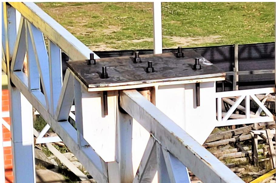
En la **Figura 99**, se observa la instalación de las planchas de apoyo con grasa grafitada entre ellas, sobre un dado de concreto armado, encimado en una columna de concreto de una edificación antigua evaluada previamente para resistir estas cargas adicionales. Por otro lado, también se observa la línea de columnas en donde serán instaladas las planchas de apoyo móvil superiores con el orificio avellanado, todo esto de cuerdo al plano de taller.
