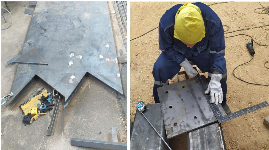
En la **Figura 63**, se observa el corte de planchas metálicas, realizado con cortadora de plasma, en la que se verifica que los cortes tienen un acabado exacto y escaza rebaba, para efectos de la limpieza y la pintura. Además, también se ve, el chequeo del espaciamiento entre los orificios, de las planchas superiores de apoyos de los tijerales. Este trabajo se realiza de acuerdo al plano de taller del techo parabólico de la Infraestructura para el Almacén-Semillero-Michiquillay.
