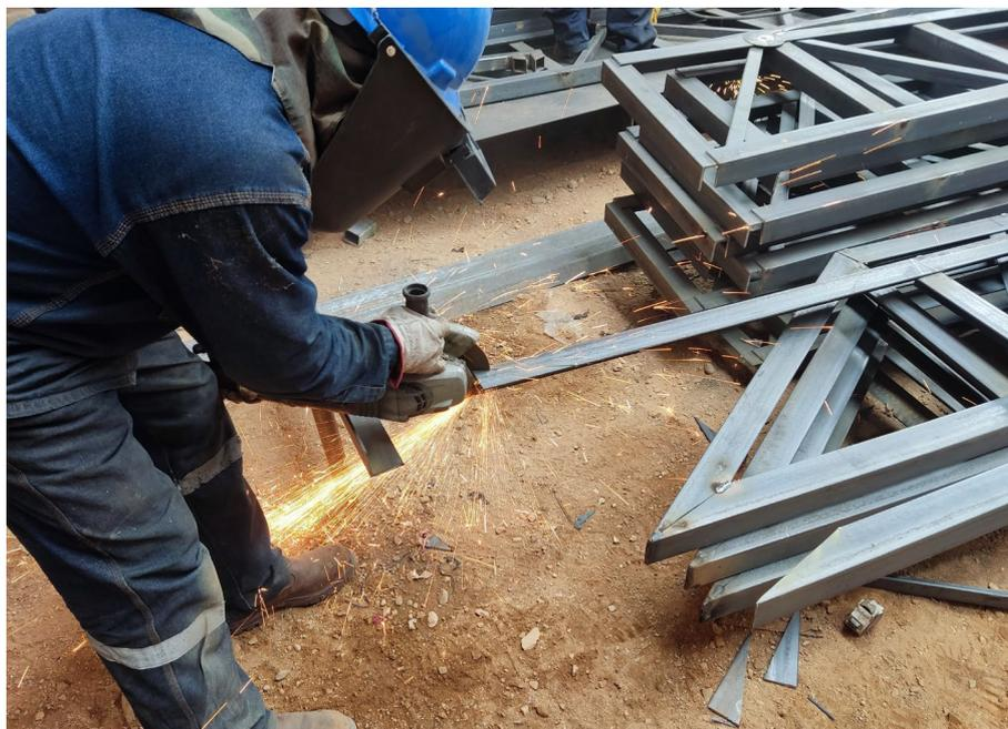
En la **Figura 68**, se ve como se lleva a cabo el proceso de armado de los aleros de los tijerales, esto desde la misma fabricación de las caras laterales de los tijerales, según los destajes indicado en los planos de taller.
