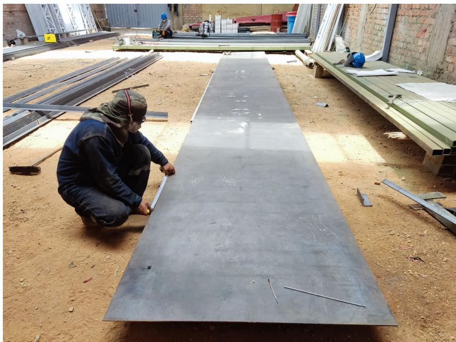
En la **Figura 53**, se tiene que las planchas unidas por soldadura provisional o de apuntalado, la cual servirá como base de apoyo para el trazado del plantillaje; Se está considerando que, el filo inferior de las planchas se tomara como la línea directora del trazo de las perpendiculares para la ubicación de los puntos de rolado, en donde se parte marcando las distancia horizontales dadas en el plano de taller.
