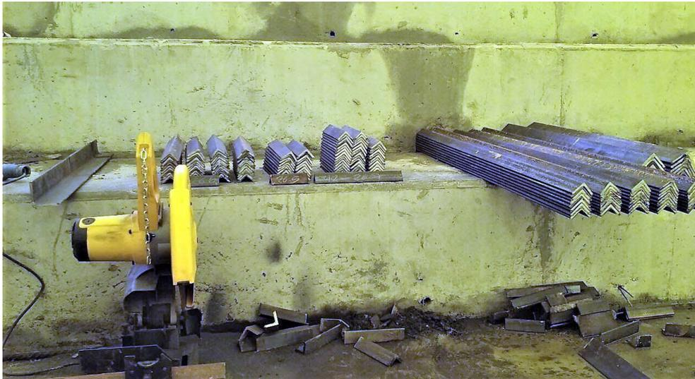
En la **Figura 59**, se observa la habilitación de material con el uso de tronzadora para el corte, de diagonales, montantes y conectores, para los tijerales parabólicos de La infraestructura para el Almacén–Semillero-Michiquillay.
