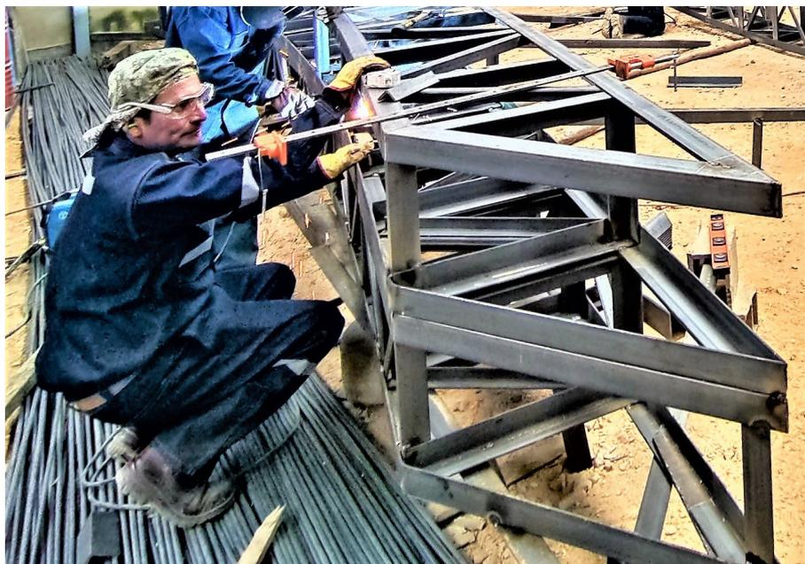
En la **Figura 73**, se observa el proceso de control de la dimensión correcta del peralte de los segmentos de tijerales, además, principalmente, se lleva a cabo el control de la conformación de los segmentos, para verificación del escuadrado correcto de las esquinas de ambos extremos de estos, en la zona del acople; Esto se hace usando escuadras de soldador de 60cm, así como también el control en el sentido de los ángulos de la celosía, los cuales deben ser hacia una misma dirección.
