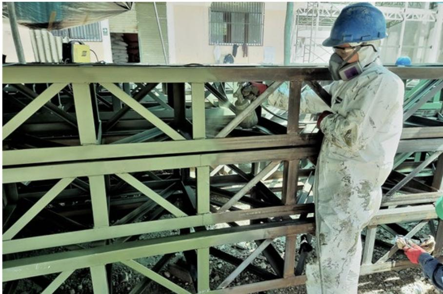
**Figura 95. Aplicación de pintura de acabado - esmalte sintético**
