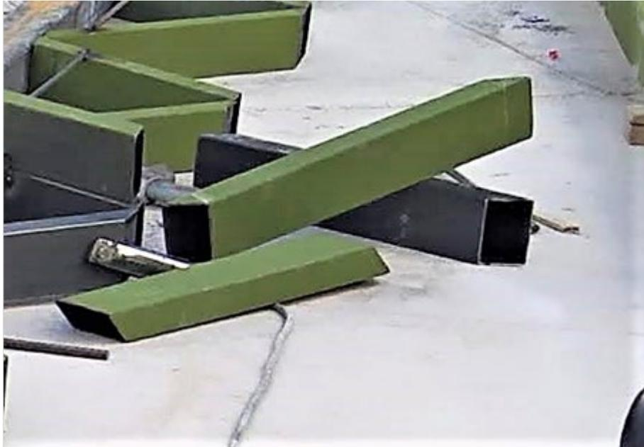
En la Figura 61, se observa el habilitado de la celosía, para el armado del tijeral metálico del Coliseo de la I. E. San Marcelino Champagnat, con un destaje de cada diagonal de 4.5cm en cada punta.
