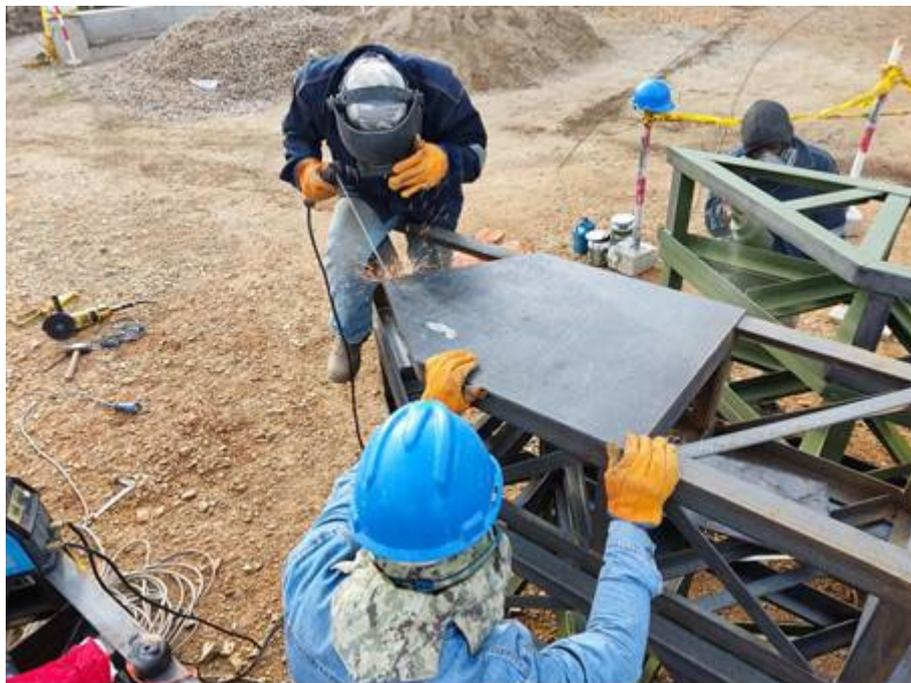
En la **Figura 79**, Para el ensamble de las planchas metálicas de las cajuelas, con el tijeral, el procedimiento del plano de taller, indica que, se tiene que aplicar soldadura de filete con electrodo de 1/8" E-6011 para mayor penetración en el material base.
