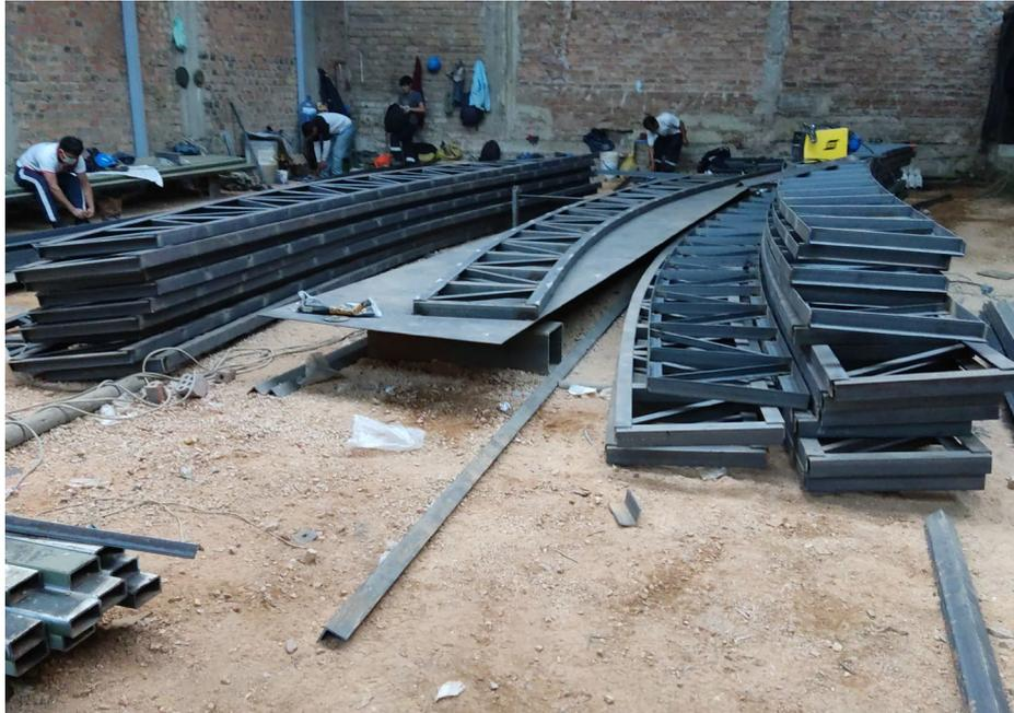
El proceso de fabricación de todas las caras laterales de los segmentos de tijeral, se realizan sobre el lado posterior de esta plantilla, considerando que se tienen que fabricar una cara lateral izquierda y otra derecha, tal como se muestra en la **Figura 67**.
