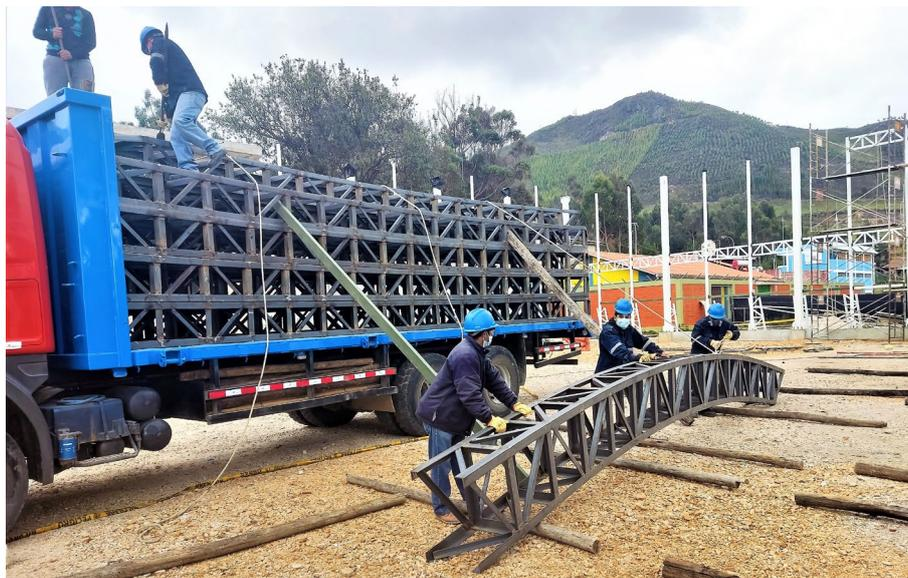
En la **Figura 97**, se puede observar el descargado de las estructuras, que para el caso del techo parabólico de Michiquillay, se utilizó el método de rampa formado por tubo metálicos y retenida con sogas tipo cuerdas como retenida, sin ningún tipo de contratiempo.
