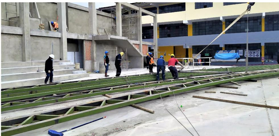
En la **Figura 106**, según lo investigado en obra, la manera correcta de colocar las eslingas a un tijeral de sección plana es mediante un elemento rígido, como un tubo metálico, y desde sus extremos colocar las eslingas hacia el tijeral.
