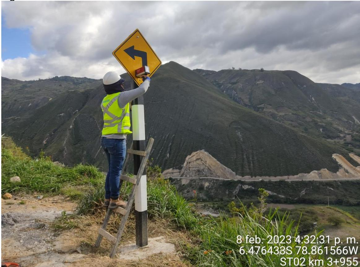
**Figura 45. Propuestas de intervención: Reposición de Panel de señal vertical**
