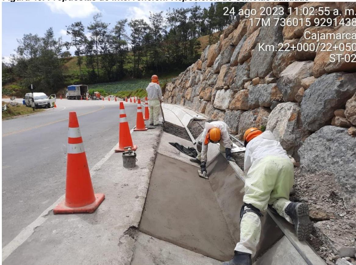
**Figura 50. Propuestas de intervención: Sellado de fisuras >5mm**
