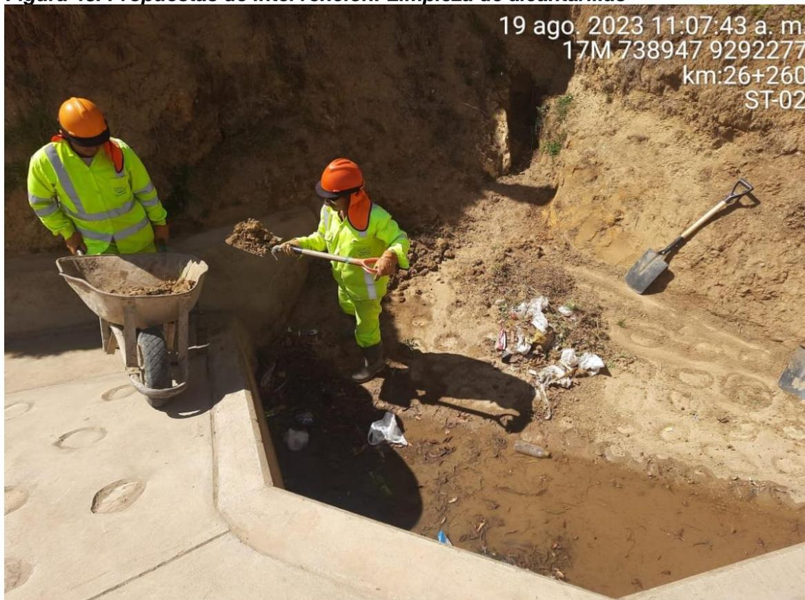
**Figura 49. Propuestas de intervención: Reposición de Cunetas dañadas**
