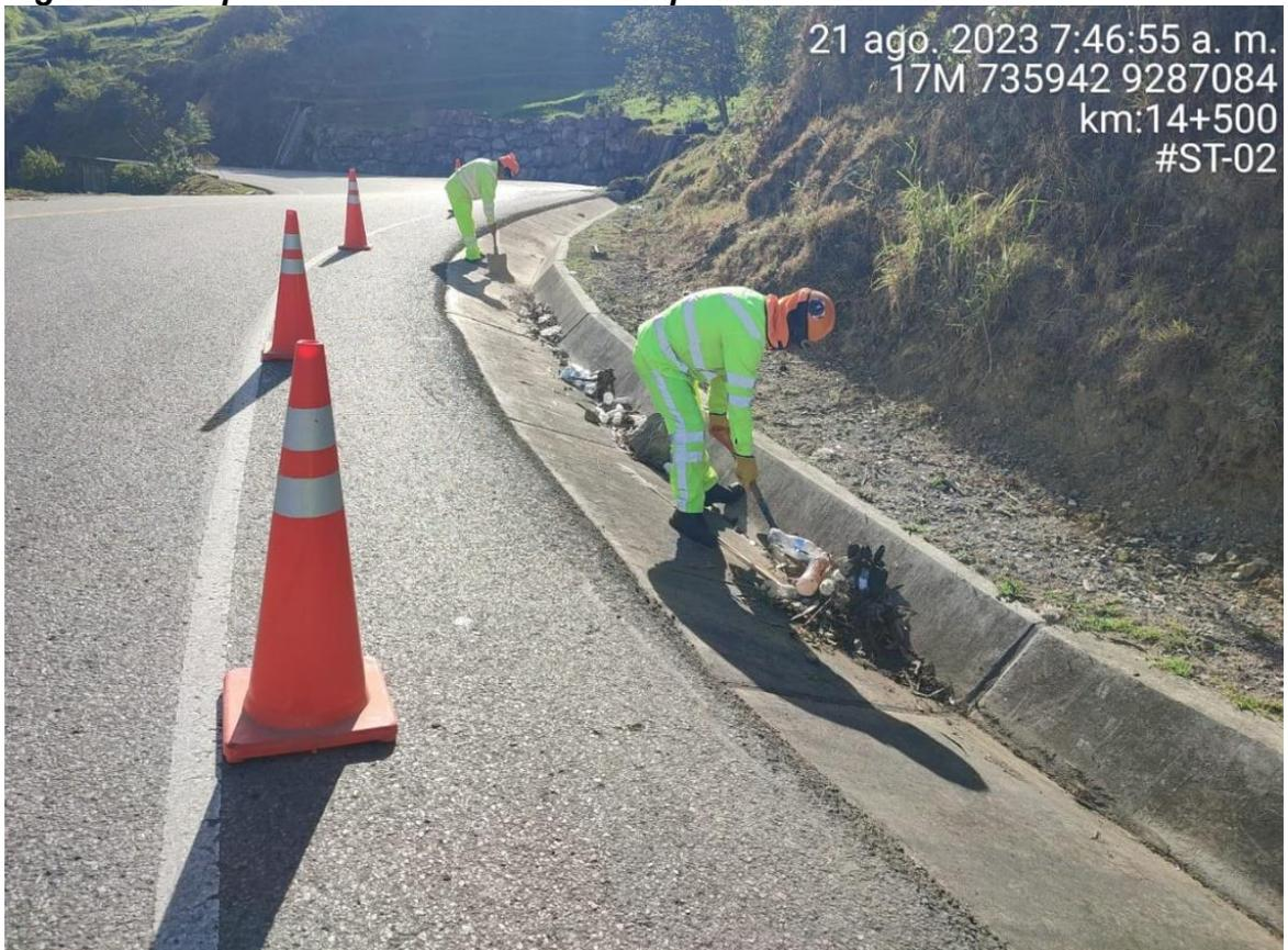
**Figura 48. Propuestas de intervención: Limpieza de alcantarillas**
