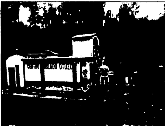
Foto3.3. Izquierda: muestra el reservorio 01 de 50m 3 y cumple la función de cámara de carga; Derecha muestra la evaluación del reservorio y caja de válvulas.
