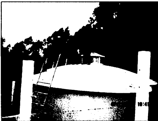
Foto 5.7. Izquierda; muestra al reservorio de 100m 3 de capacidad del sistema de agua potable; Derecha muestra a la caja de válvulas del reservorio.
