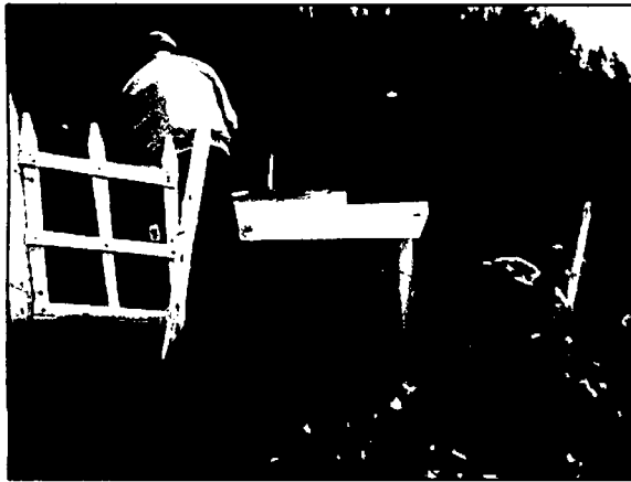
Foto 5.9. Izquierda: muestra a una cámara rompe presión tipo 7; Derecha: muestra la evaluación de la cara rompe presión
