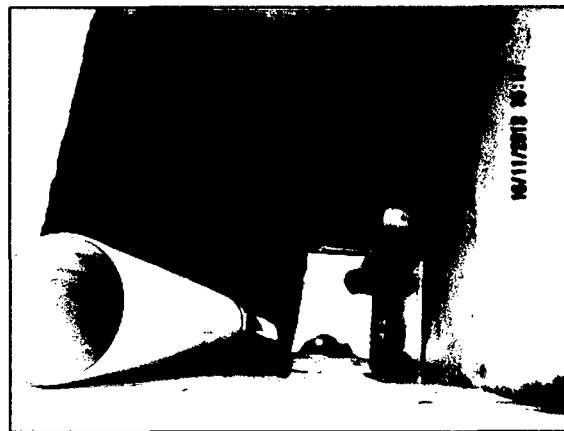
Foto 1.1. Izquierda: Captación de manantial tipo ladera del sistema de agua potable Bajo Otuzco llamado “Succha Puquio” con un caudal aforado de 5.14l/s aforado en el mes de noviembre, el manantial se encuentra ubicada en el Caserío Otuzco la Victoria; Derecha: se muestra la cámara húmeda, tubería de limpia y rebose, y la salida del agua mediante dos tuberías que conforman la línea de conducción.
