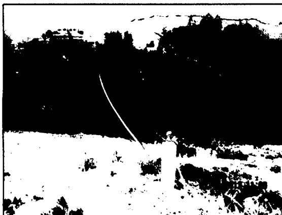
Foto 5.8. Izquierda: muestra el pase aéreo 02 de 200m de longitud ubicada en la línea de aducción; Derecha muestra al pase aéreo 03 de 60m de longitud.
