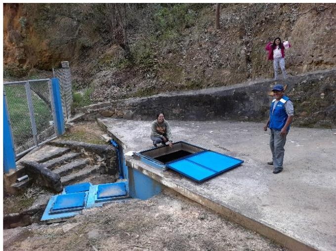
Presenta un cerco perimétrico de acero galvanizado con malla olímpica en buen estado, cámara de protección del manantial, cámara húmeda y cámara seca al nivel del terreno natural.
