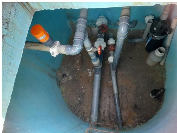
La caseta de válvulas es de concreto armado, de sección semicircular de 2,21 m de cuerda, 2,52 m de arco y 1,33 m de profundidad, en la parte superior tiene una tapa metálica de 0,60 m x 0,60 m, cuya bisagra está rota, estando expuesta las válvulas para su manipulación; con líneas de ingreso de  $\varnothing 2''$  PVC (con una válvula de aire), salida de  $\varnothing 3''$  PVC, limpia y rebose de  $\varnothing 2''$  PVC, con sus respectivas válvulas de control operativas
