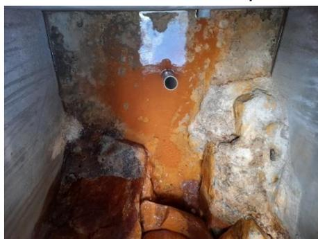
Superficialmente tiene un aspecto óptimo, con un muro de ladrillo revestido, este sobre un muro ciclópeo de protección a mediana altura para evitar el desborde de materiales (causado por cunetas metros arriba) sobre la estructura; respecto a la parte interna de la misma se observa sarro en 80% del enrocado debido a que la zona de afloramiento tiene minerales como parte de su geología.
