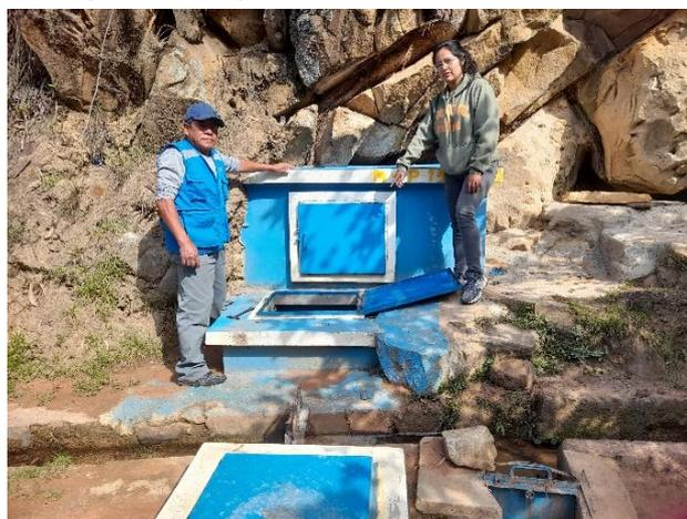
Comprende la cámara de protección del manantial construido sobre el nivel del terreno natural, una cámara húmeda y una cámara seca a nivel del terreno natural, ocupando un volumen total de 1.66 m<sup>3</sup>.
