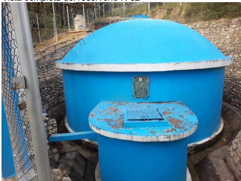
El tanque de almacenamiento tiene una capacidad de 60.51 m<sup>3</sup> de sección circular, cuyo espesor de muro es de 0.25 m y con una tapa metálica de 0.66 m de diámetro en buen estado, pero sin seguridad (falta de candado), considerando que se encuentra expuesto al ingreso de objetos que podrían afectar la calidad del agua; cuyo fin de uso de este elemento es para inspección, operación y mantenimiento.
