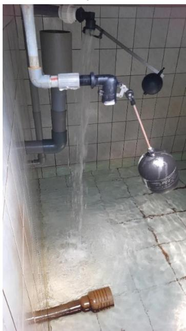
En el interior del tanque de almacenamiento se tiene un cono de rebose de  $\varnothing$  4" PVC con una reducción a una tubería de  $\varnothing$  3" PVC, una tubería de ingreso de  $\varnothing$  2" PVC, una canastilla de salida de  $\varnothing$  4" PVC con una reducción a una tubería de  $\varnothing$  3" PVC y una tubería de  $\varnothing$  1/2" PVC que permite la desinfección directa por goteo del agua almacenada en el reservorio, con más detalle se observa en la **figura 45**.
