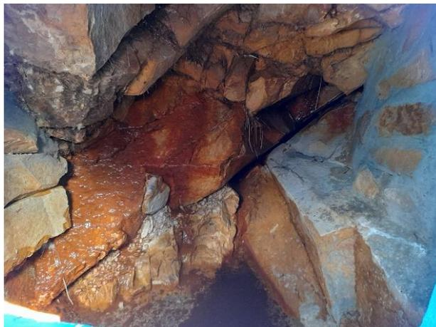
Superficialmente tiene un aspecto óptimo; respecto a la parte interna se observa sarro en el 60% del enrocado debido a que la montaña de la cual aflora el agua tiene minerales como parte de su geología, cabe mencionar que existe una canal de riego que divide la cámara húmeda y la cámara seca de la captación, lo cual no ha impedido el buen funcionamiento de la misma.
