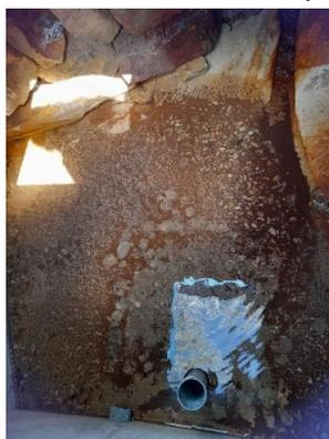
En la parte posterior - superior a la estructura presenta un muro ciclópeo o también llamado de concreto ciclópeo enrocado, de protección ante un probable deslizamiento de la ladera; respecto a la parte interna se observa sarro en el 40% del enrocado debido a que la montaña de la cual aflora el agua tiene minerales como parte de su geología.
