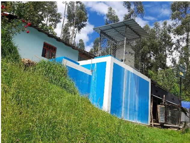
Tiene una capacidad de almacenamiento de 21.234 m<sup>3</sup>, es de sección cuadrangular, cuyo espesor de muro es de 0.25 m; en la losa presenta un tubo de ventilación de acero de 35 cm de altura, una tapa metálica de 0.60 m x 0.60 m, cuya abertura sirve de acceso para el mantenimiento, se observa dichos componentes en la **figura 47**.
