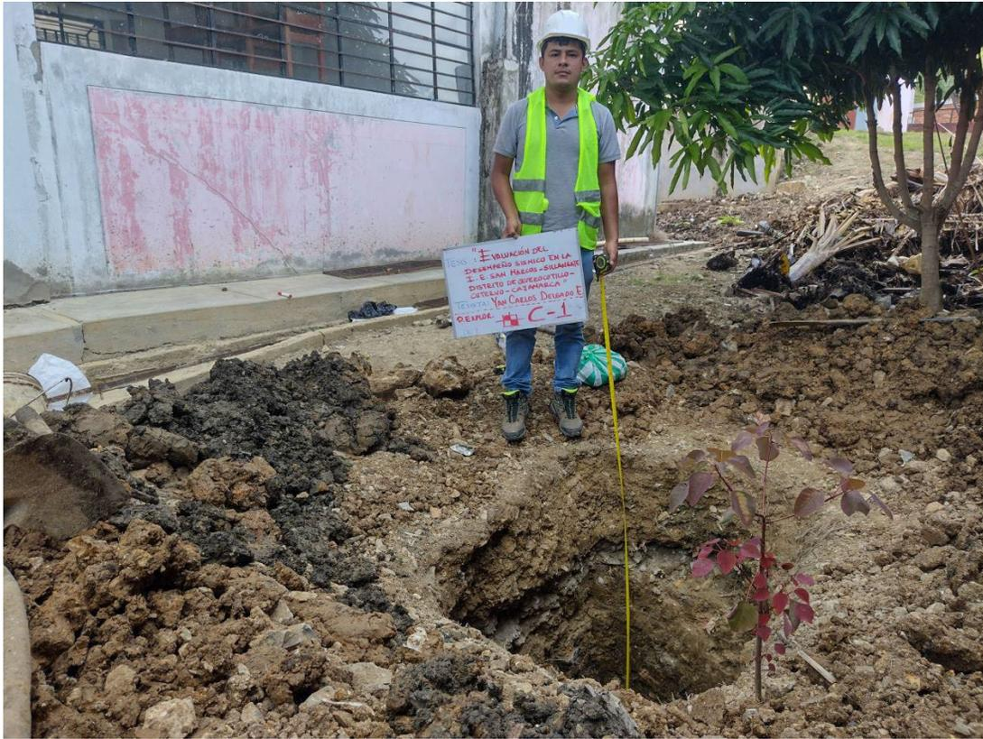
**Imagen 09:** Inspección a la excavación de la calicata para el EMS.
