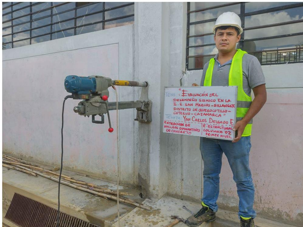
**Imagen 10:** Inspección a la extracción de diamantina
