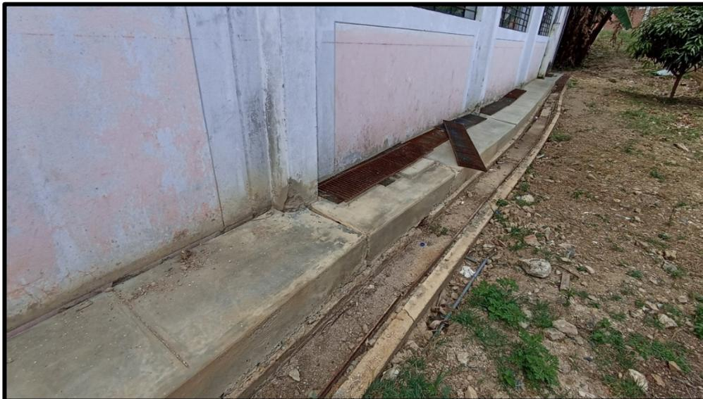
**Imagen 08:** Se observan una serie de fallas estructurales como: elementos estructurales agrietados, asentamientos, mala calidad de materiales entre otros, estos problemas son tan notorios que habido fallas en el diseño o construcción.
