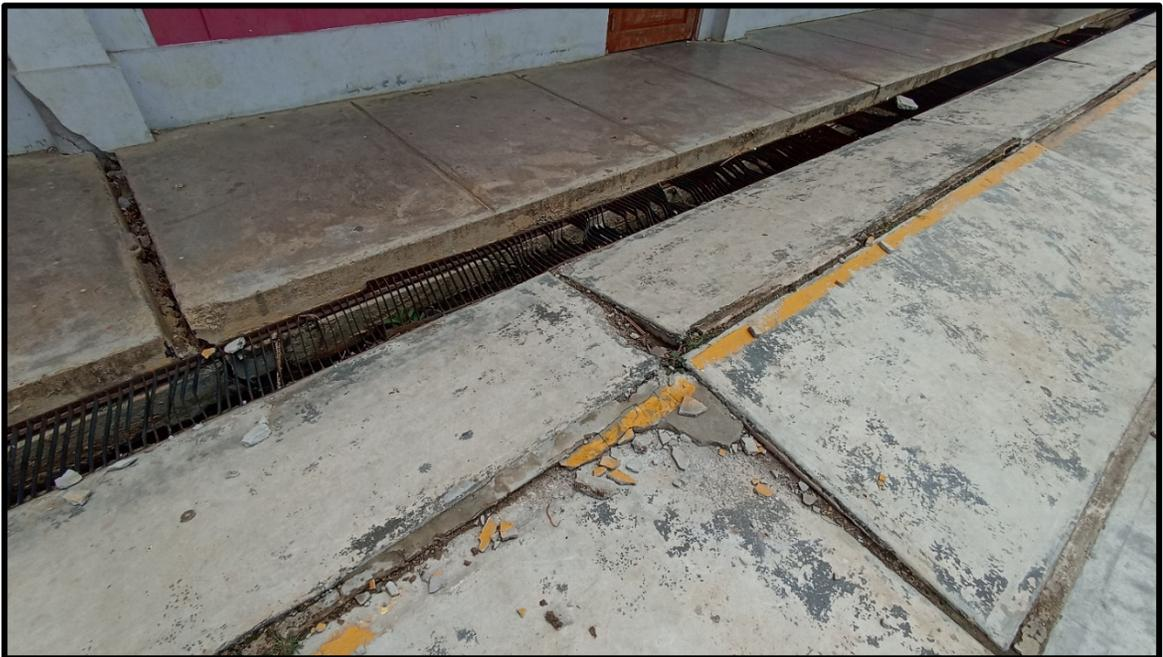
**Imagen 06:** Se muestra un asentamiento diferencial del pabellón 01, puede ser que algunas partes de la cimentación se este asentando de manera desigual.
