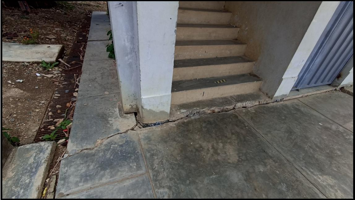
**Imagen 05:** Se muestra una grieta de separación entre el pabellón y la vereda, parte frontal, se puede deducir que ha sucedido por problemas en la fundación de la estructura.
