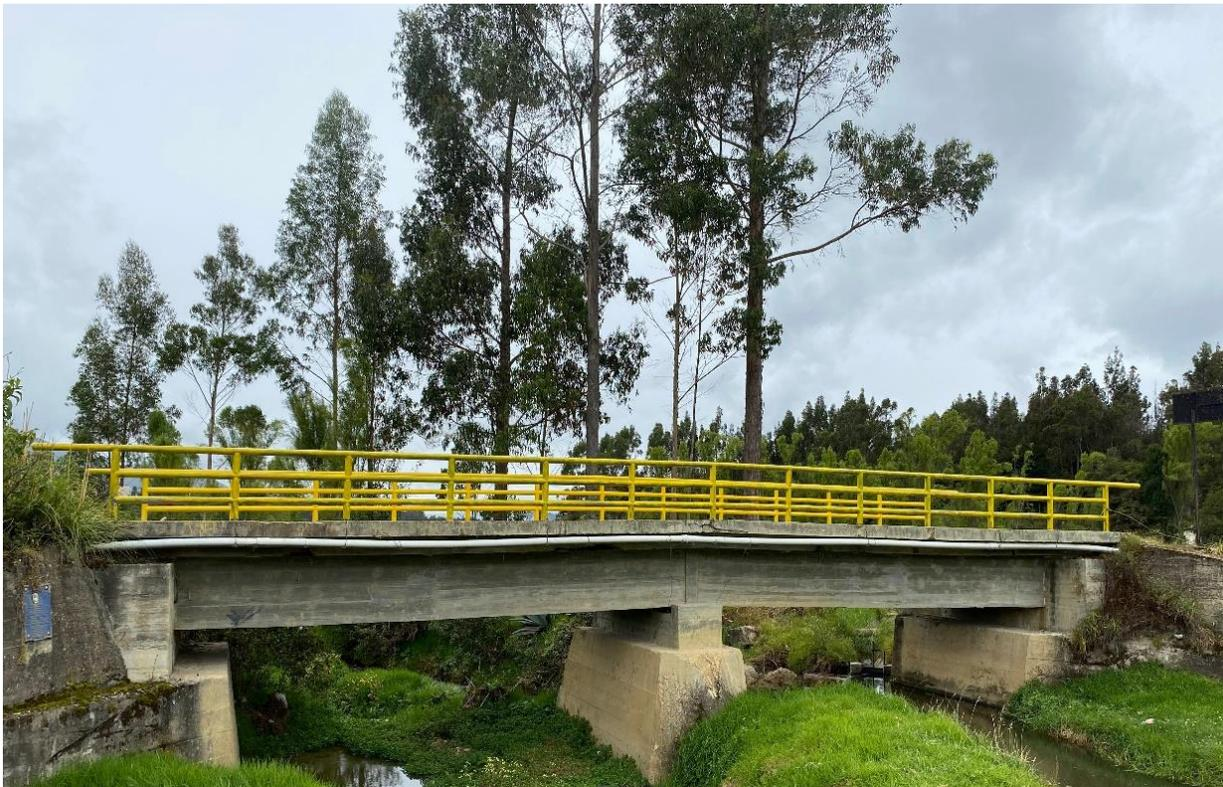
El Puente Carrozable construido sobre el Río Encañada es un proyecto de infraestructura vial que cuenta con un solo carril, el cual tiene un ancho total de 5.00 metros, que comprende 3.60 metros de calzada, el ancho de la vereda es de 0.65 metros y tiene una altura de 0.20 metros por sobre la losa.
