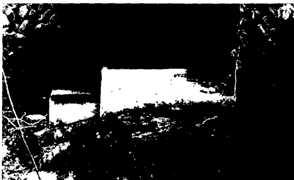
Foto 3.1.: Captación, se puede apreciar la falta de cerco perimétrico.
