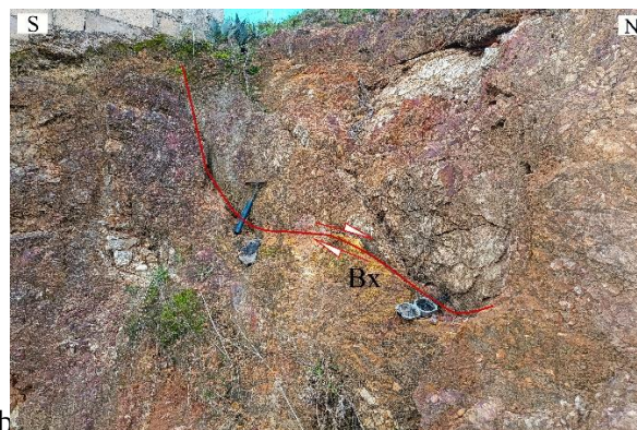
Fotografía 48. Brecha en F-12, N: 9211824, E:775136 Cota: 2766 m.s.n.m.
