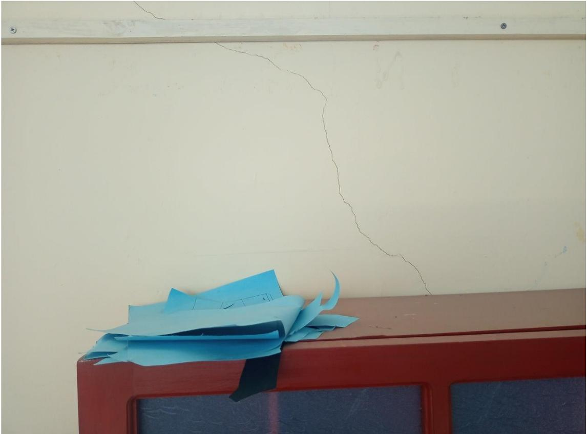
Se considera que la construcción tiene una calidad de albañilería regular debido a su antigüedad y estado de servicio. Además, se ha comprobado la verticalidad del muro con un nivel de mano, y la junta del motorista tiene un grosor aproximado de 1,5. Sin embargo, debido a su antigüedad, se considera que su estado de conservación es regular, lo que le otorga una calificación C.
