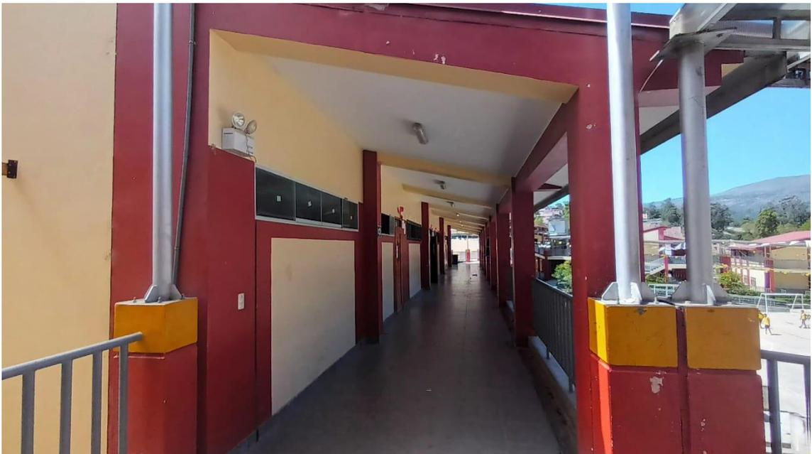
**Evaluación:** El tercer nivel del Pabellón D tiene una buena conexión entre la membrana horizontal y las columnas. El primer y segundo piso cumplen tres condiciones para este parámetro. Por tanto, la calificación equivale a A porque no se cumple la primera condición.
