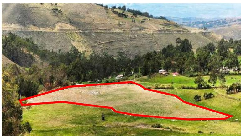
Foto 39: Depósito de relaves revegetado, ubicado en Michiquillay Alto, al margen derecho del río Michiquillay. Coordenadas: E:794979; N:9220731; Cota: 3439 m.s.n.m.
