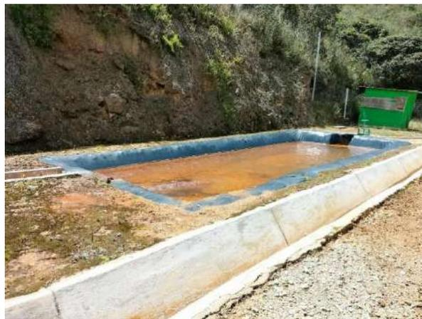
Foto 41: Poza de sedimentación del drenaje que efluye de la bocamina principal. Coordenadas: E:795628; N:9220952; Cota: 3500 m.s.n.m.
