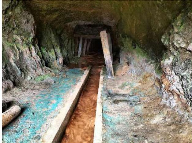
Foto 40: Bocamina principal “El Túnel” con el drenaje ácido de mina que efluye de su interior. Coordenadas: E:795623; N:9220971; Cota: 3500 m.s.n.m.
