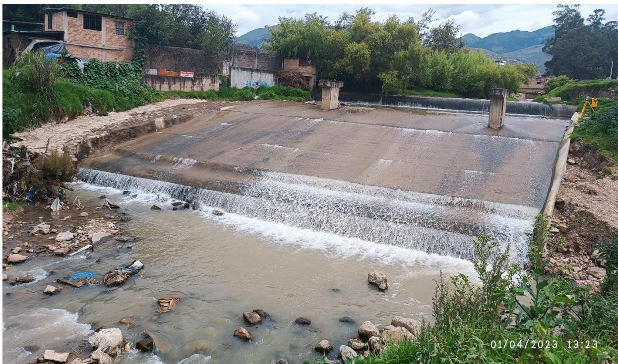
La morfología del río Mashcón de un tramo de 300 m aguas arriba y 50 m aguas abajo del barrage se obtuvo realizando un levantamiento topográfico usando una estación total Leica FlexLine TS10, la toma de puntos se realizó seccionando el cauce cada 10 y 20 metros de manera estratégica, identificando puntos para cálculo de pendientes, talweg, taludes de la rivera.
