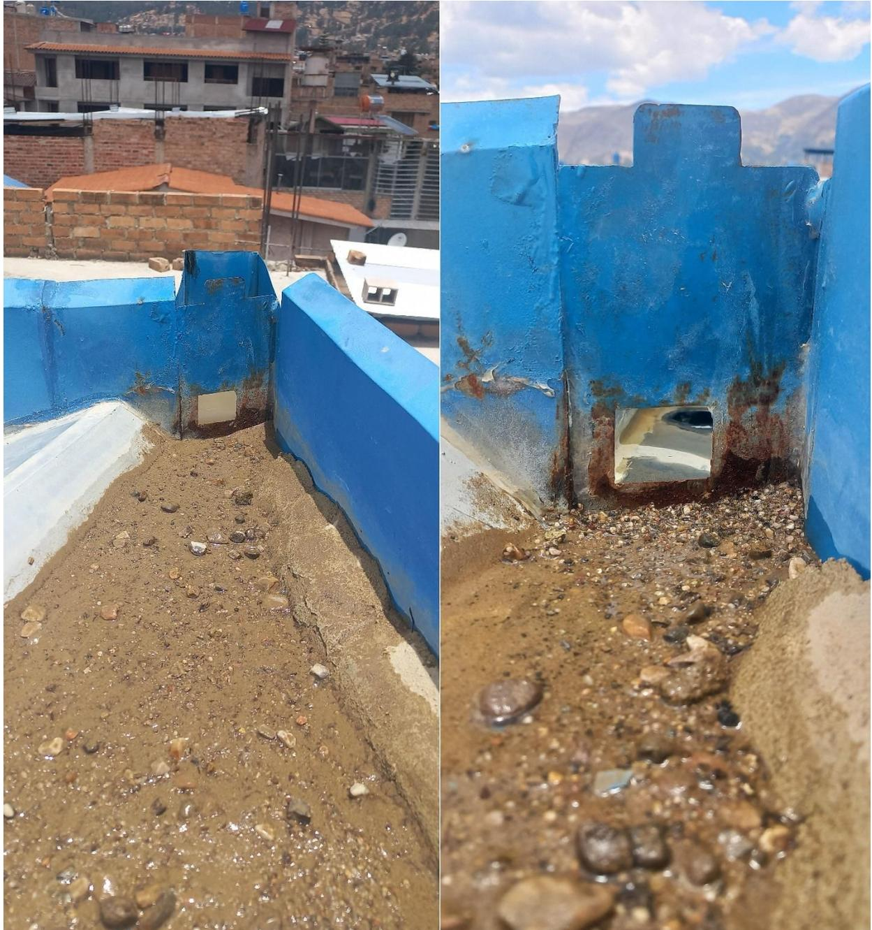
**Figura 76:** *Medición de altura de sedimentos antes de la descolmatación*
