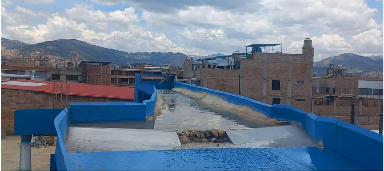
**Figura 79:** *Funcionamiento a 100% del bocal de captación*
