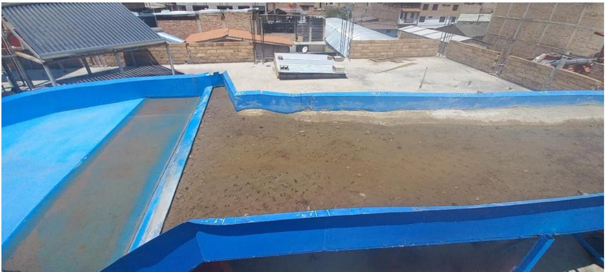
**Figura 60:** *Bocal colmatado con sedimentos*
