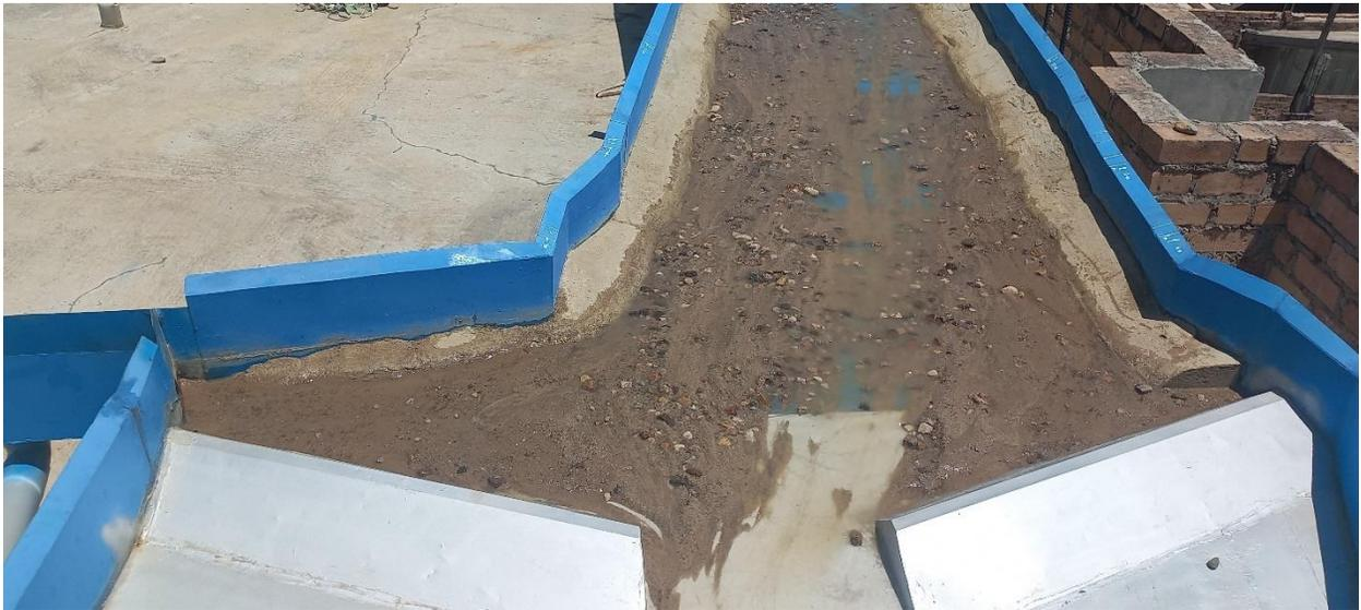
**Figura 75:** Bocal 100% libre de sedimentos después de terminado el proceso de descolmatación
