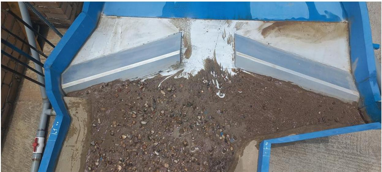
**Figura 40:** Condiciones del bocal al finalizar la descolmatación inducida con el nuevo barrage
