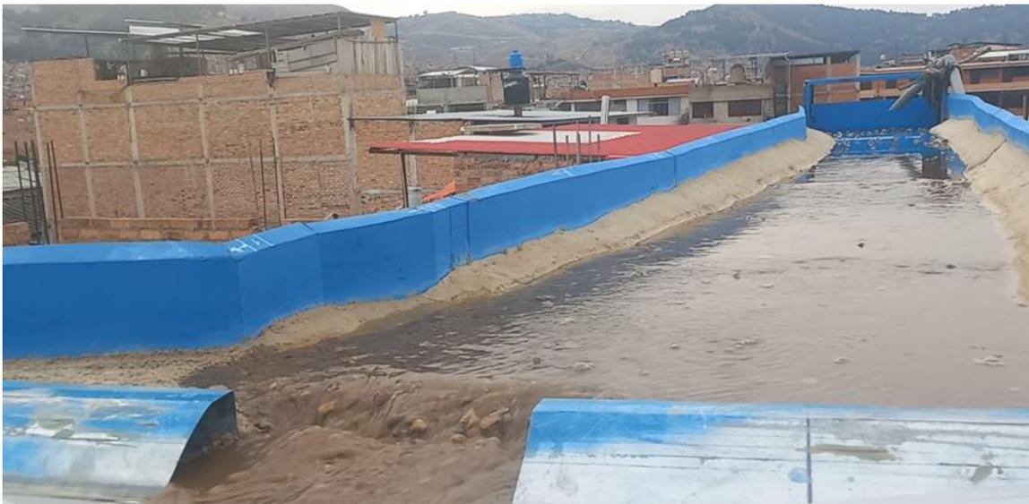
*Nota:* Se realiza pruebas con los caudales más altos, con la finalidad de comprobar la eficiencia de descolmatación en estas condiciones.
