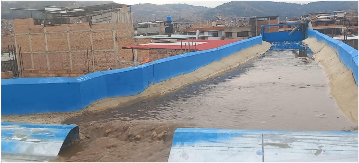
**Figura 68:** *Resultado de aperturar la parte central del barrage original*
