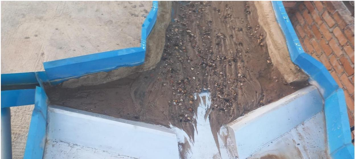
**Figura 73:** *Descolmatación del bocal de captación*
