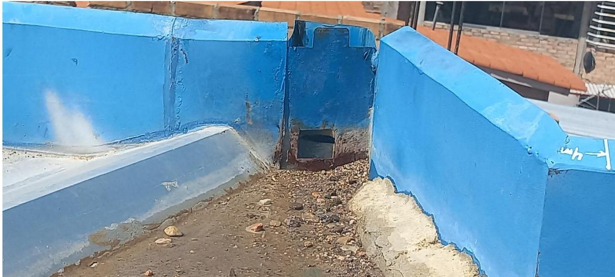
**Tabla 19:** Profundidad de sedimentos en estructura descolmatada
