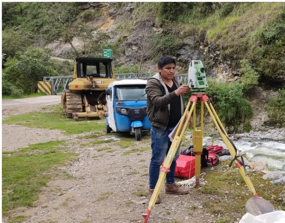
**Figura N° 14 Levantamiento topográfico en tramos de los puntos de aforo dentro los caseríos La Lucma y Tacarpo (Parte baja del río Sendamal)**
