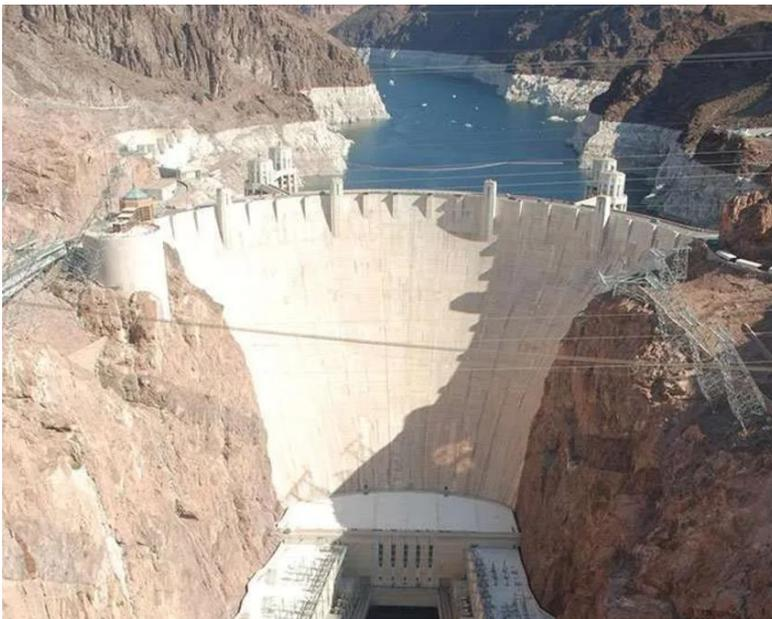
Fuente: Se utilizó más de 3.3 millones de metros cúbicos de concreto, se construyó en bloques de 1.5m de altura para controlar la temperatura. Obtenido de 360 en Concreto, n.d.
