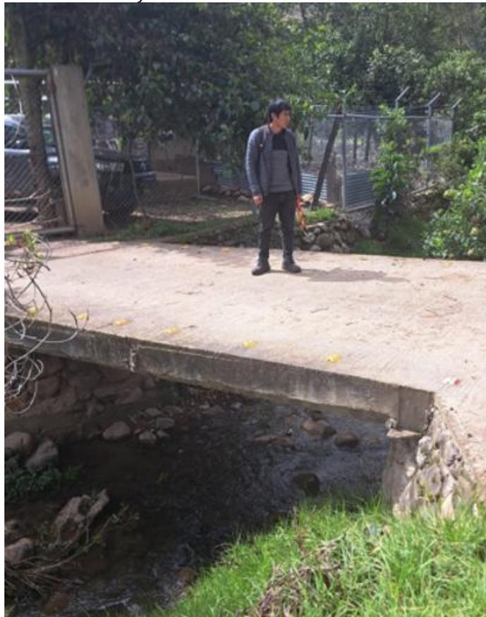
*Figura 22. Puente de concreto con apoyos contruidos en forma artesanal.*
