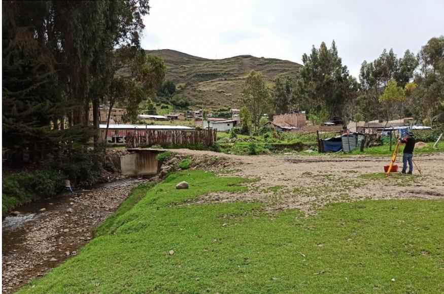
*Figura 19. Puente carrozable de concreto con tablero de madera y acero, viviendas en las riberas del río.*
