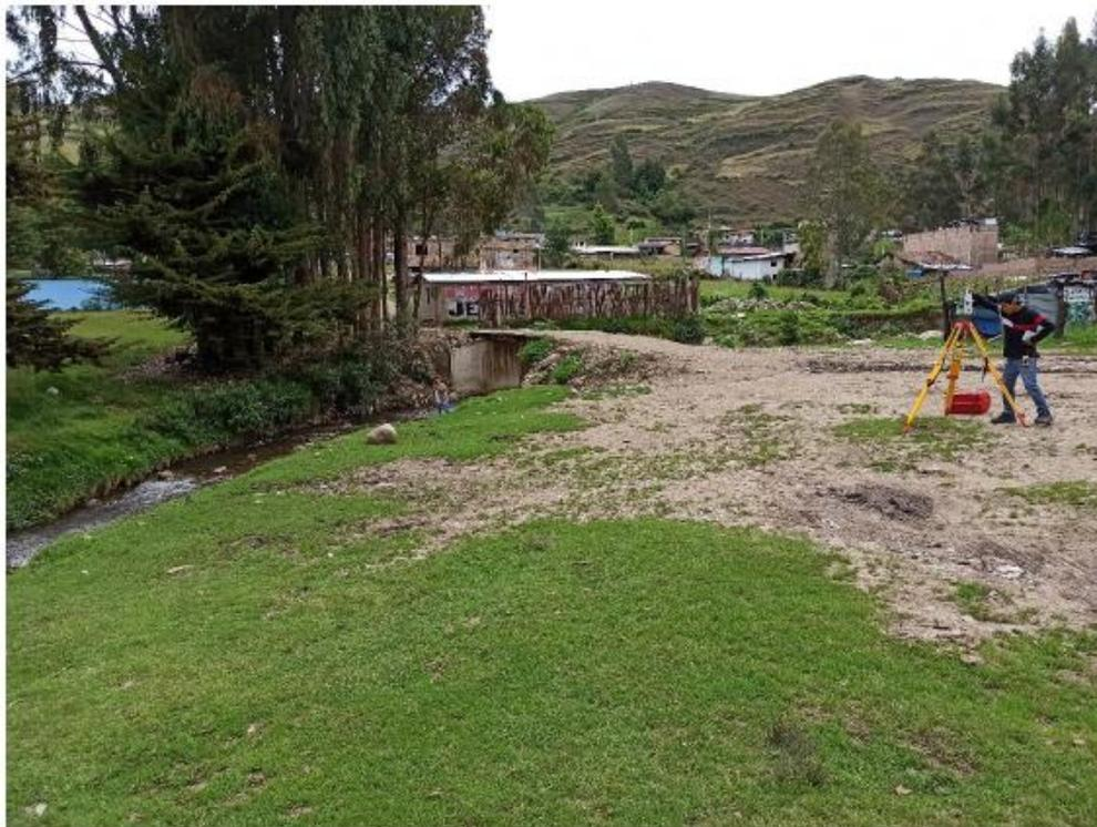
*Figura 59. Levantamiento Topográfico con Estación Total.*
