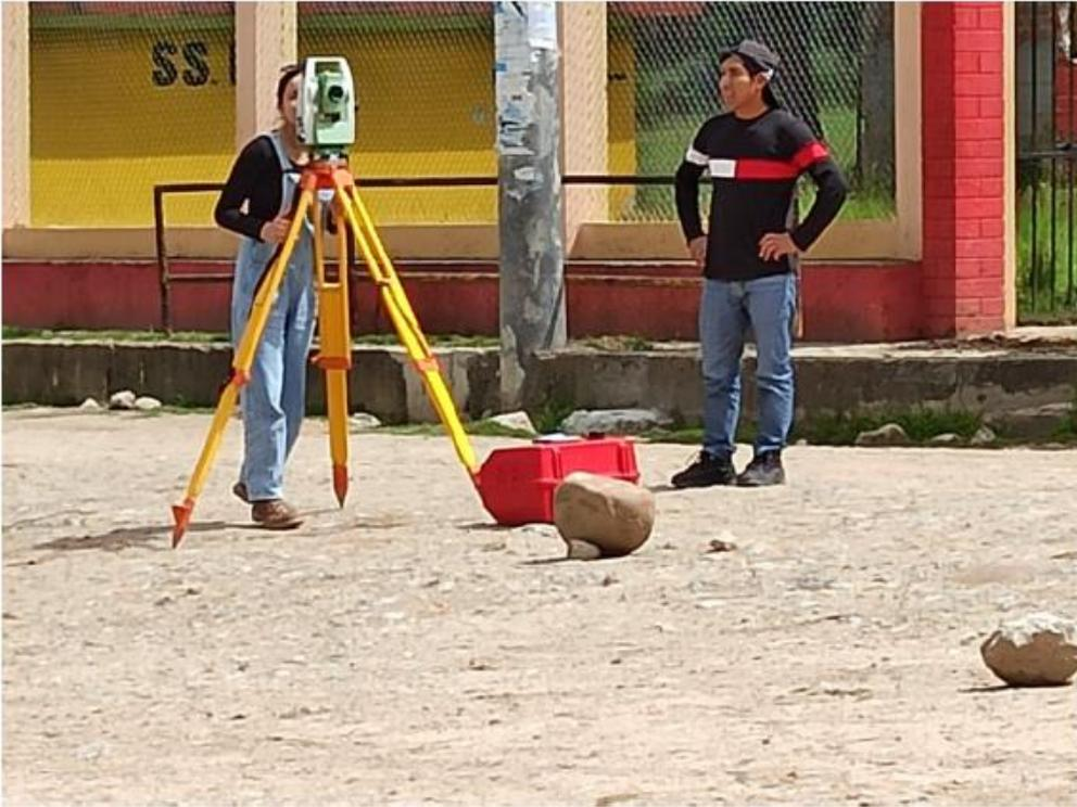
*Figura 60. Levantamiento Topográfico con Estación Total.*
