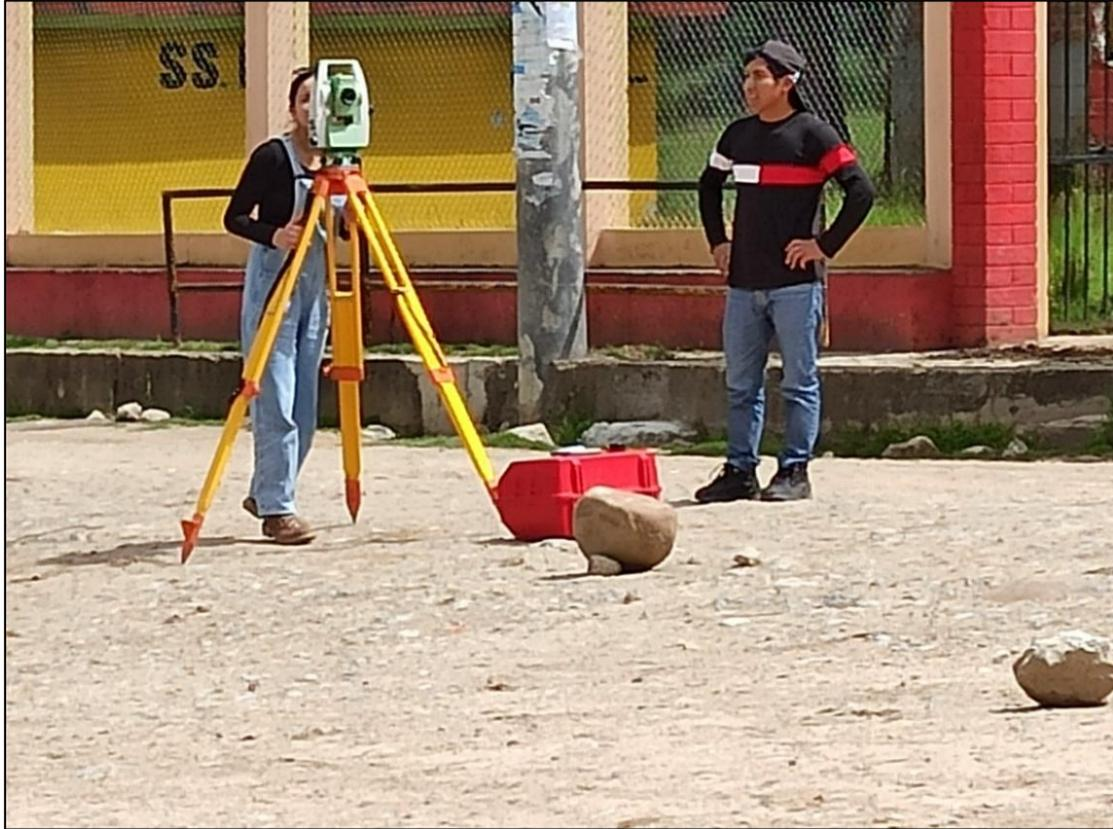
*Figura 14. Uso de estación total para levantamiento del lecho del río y ensamblaje a imagen.*
