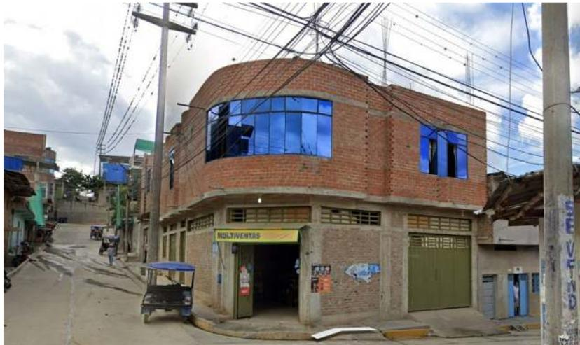
Como se puede visualizar en la figura los muros de albañilería confinada de la vivienda no tienen continuidad vertical por lo que dicha vivienda no estaría cumpliendo con el sistema estructural de albañilería confinada.
