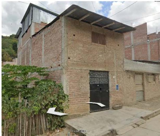
En la figura se puede apreciar que la edificación de albañilería confinada presenta patologías como grietas, fisuras, humedad, entre otras que afectan el estado de la estructura y su funcionalidad de la misma.
