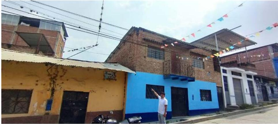
En la figura se muestra que la edificación de albañilería no cuenta con una buena conexión debido a que dicha edificación no presenta elementos estructurales tales como columnas ni vigas que sirven de amarre a la losa aligerada. Este parámetro calificó los diafragmas rígidos que presentan las edificaciones, si tiene buena conexión con sus elementos estructurales, si estos presentan deflexiones o si presenta discontinuidades abruptas.
