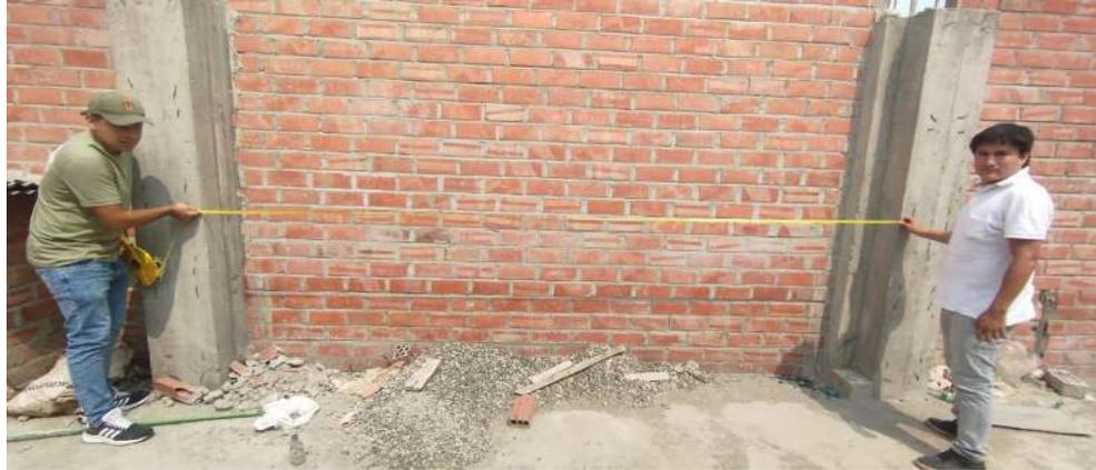
Como se puede observar en la figura se calificó este parámetro a través de la fórmula para medir el distanciamiento de los muros de manera transversal y ver si cumple el distanciamiento permisible para que la estructura funcione.
