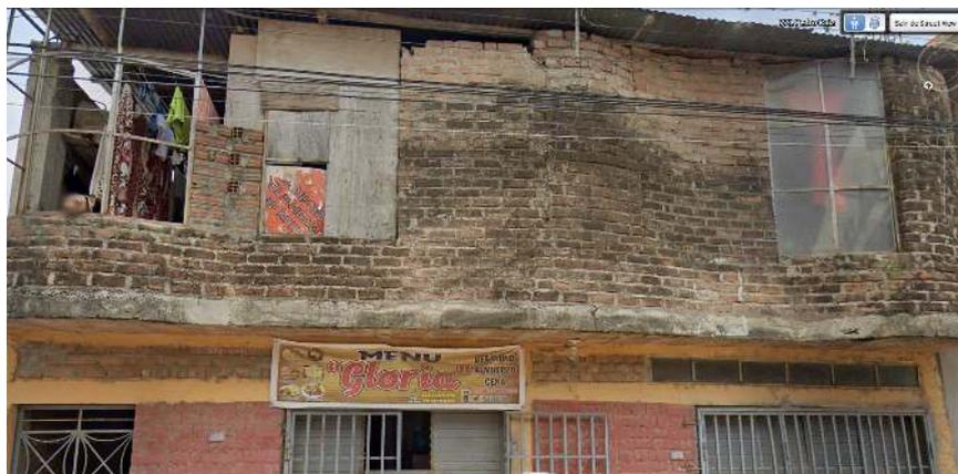
En la presente figura se revisó que las unidades de albañilería que conforman el muro portante tengan homogeneidad de sus lados, que las juntas tengan entre 1 a 1.5 cm; y muros en perfectas condiciones.
