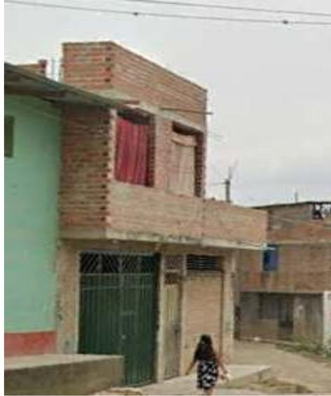
De acuerdo a la figura se puede apreciar que su tabiquería y parapetos no se encuentran confinados por elementos de concreto por lo que suele ser inestable al momento de suscitarse un sismo.
