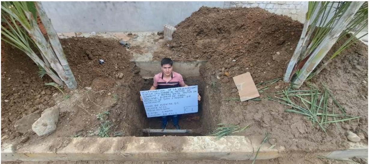
**Figura 114 Verificación de medida de calicata C-1**
