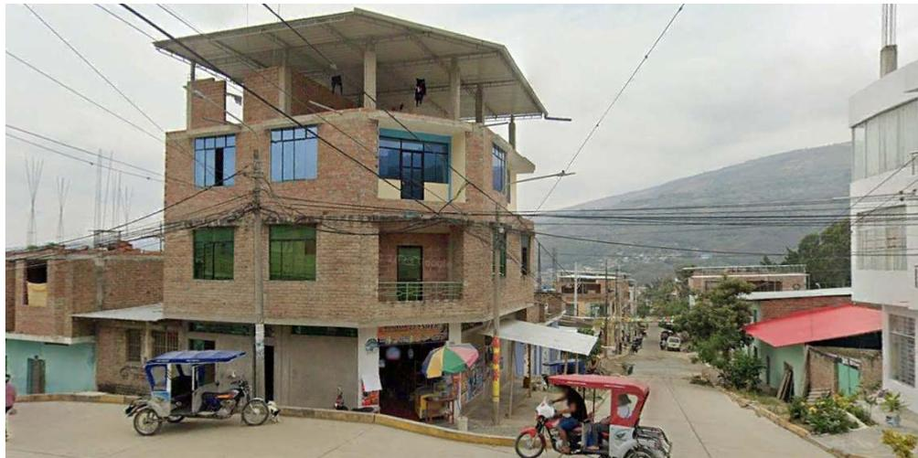
Como se puede apreciar en la imagen el tipo de cubierta que presenta esta vivienda es de calamina en malas condiciones y sin una adecuada conexión a los muros de albañilería confinada.
