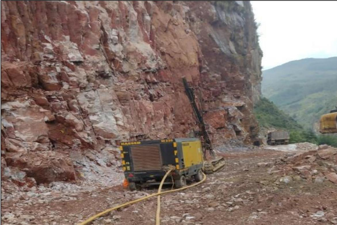
Figura 2: Perforación en roca muy dura tipo cuarcita.
