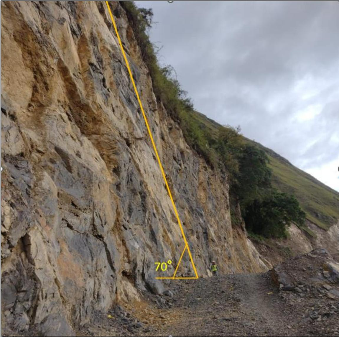
Figura 18: Zona de acceso después del empleo de perforación y voladura. Carretera Bambamarca – Marañón.
