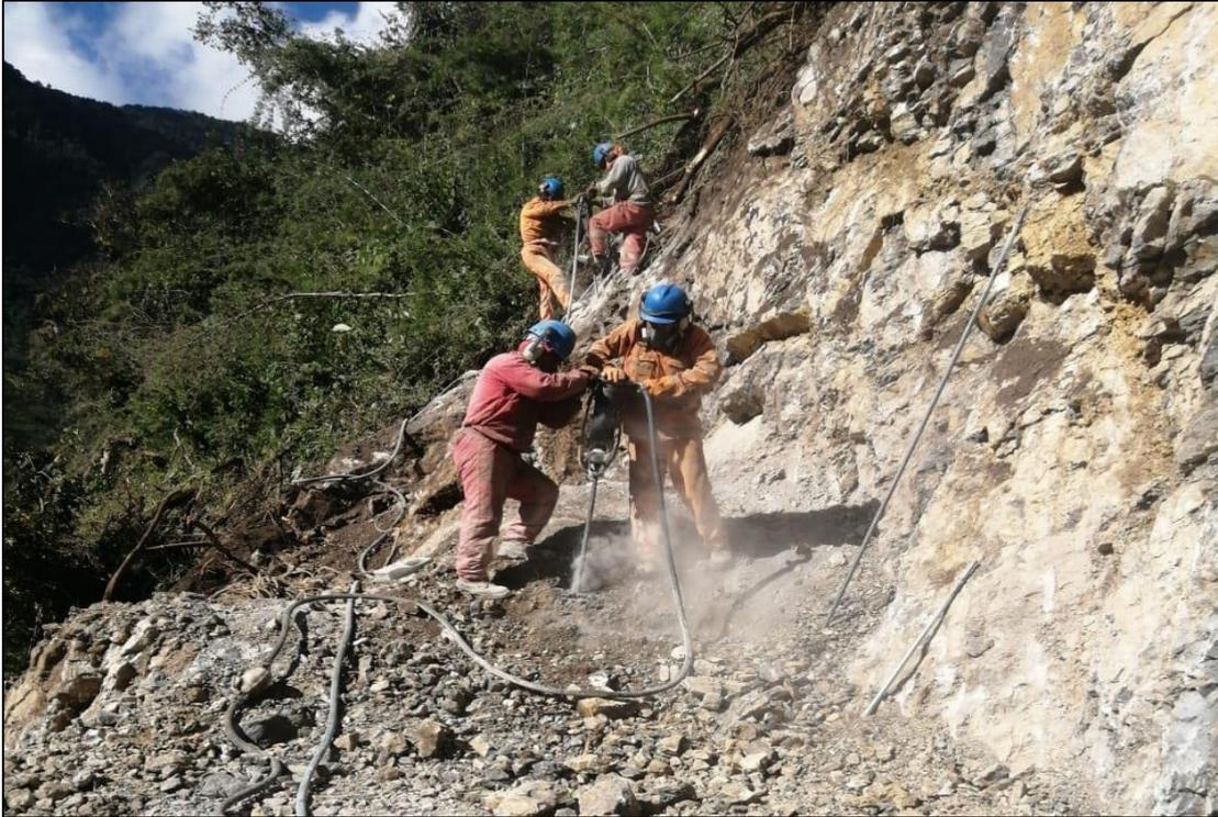
figura 8: Inicio de la perforacion de corte de talud hasta tener un ancho operativo para el rockdrill.
