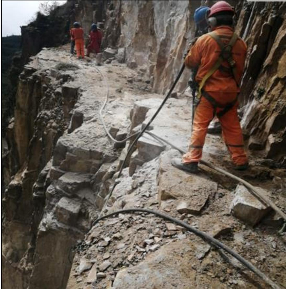
Figura 9: Perforación con martillos neumáticos RH en corte de talúd.
