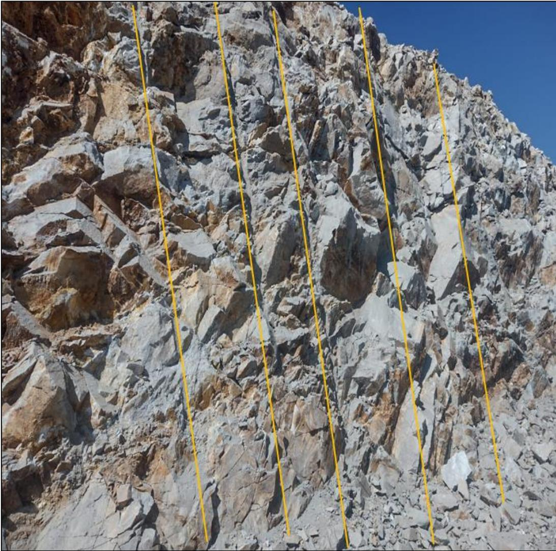
Figura 20: Talud después de la voladura aplicando el precorte con equipo hidráulico. Carretera Bambamarca-Marañón.
