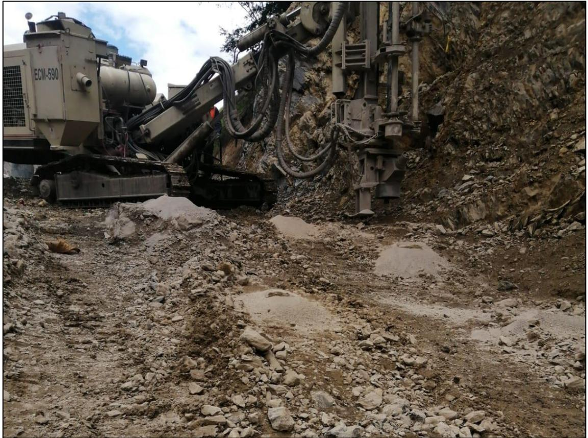
Figura 13: Perforación con equipo hidráulico vertical. Carretera Bambamarca- Marañón.
