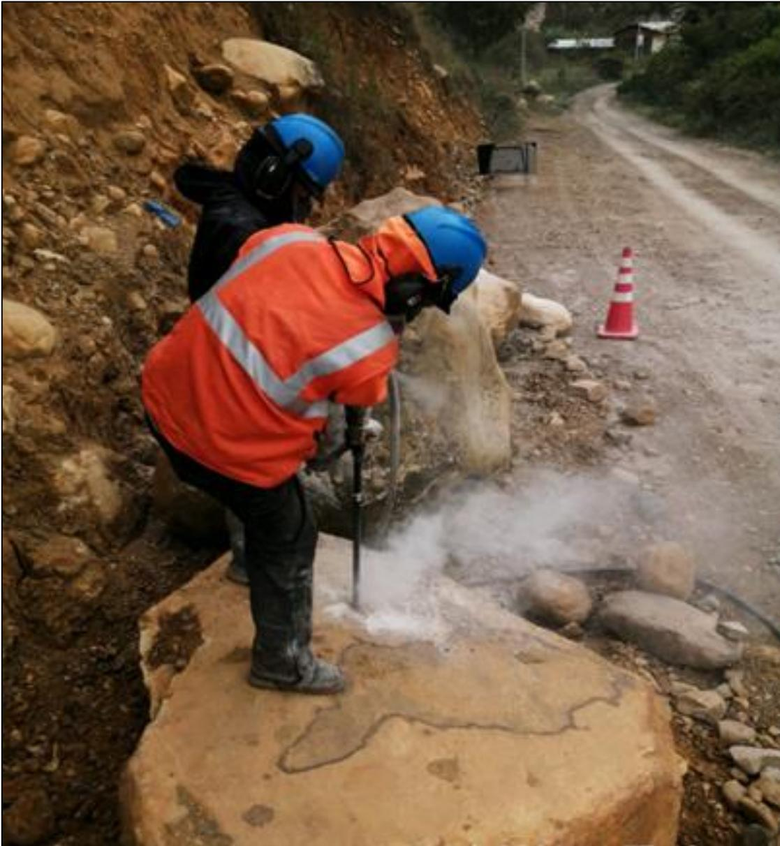
Figura 7: Perforación de bolones de roca con martillo neumático RH.
