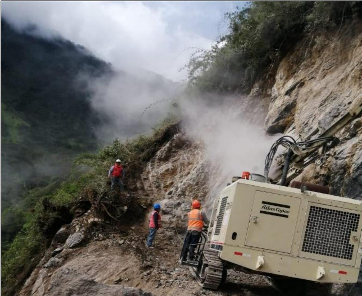
Figura 12: Perforación con Rockdrill en corte de talud (avance con perforación frontal). Carretera Bambamarca- Marañón.
