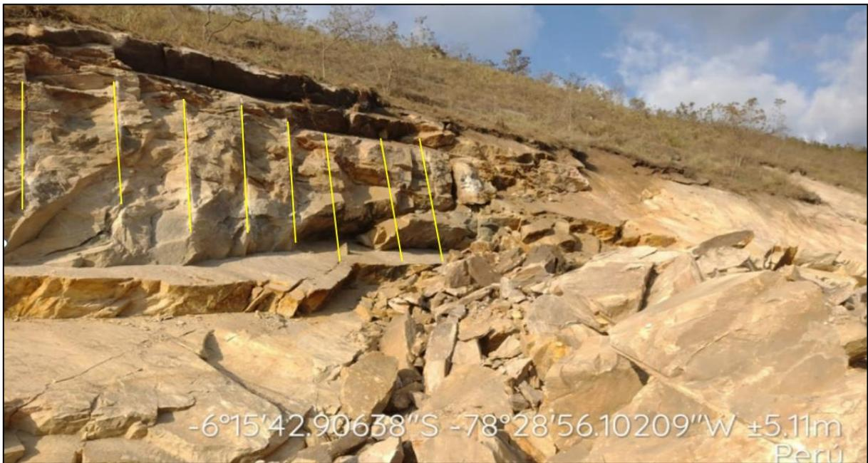
Figura 11: Talúd después de la voladura con martillos neumaticos. Carretera Bambamarca – Marañón.km86+250
