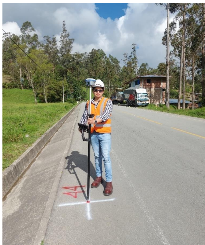
Fotografía 8. Marcado y toma de punto de apoyo - fin del tramo Chota Bambamarca
