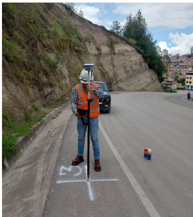
Fotografía 7. Marcado y toma de puntos de apoyo en el tramo Chota – Bambamarca
