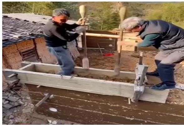
Figura 5. Ejecución del tapial (muros de tierra).
