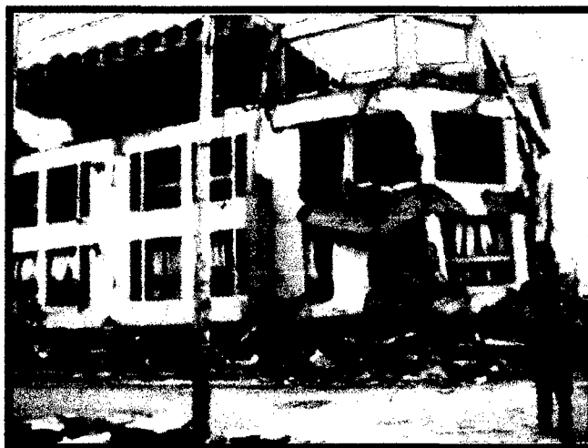
Figura 1. 3: Colapso del Hotel Embassy por falla por piso blando (Pisco)
