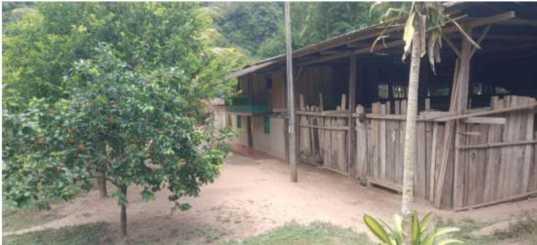
Figura 27 Vivienda construida con material de la zona (madera)
