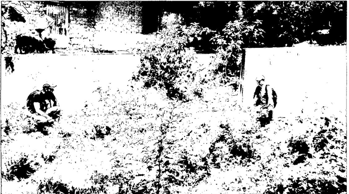
Figura 19. En la vista se observa, la interrupción de los muros de encauzamiento por entradas o accesos a las viviendas anexas a la defensa ribereña
